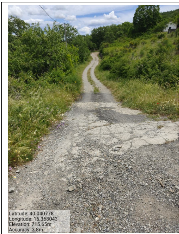
Int. _3.4.1_ Manutenzione Piste Loc. Monaca Foto 1
