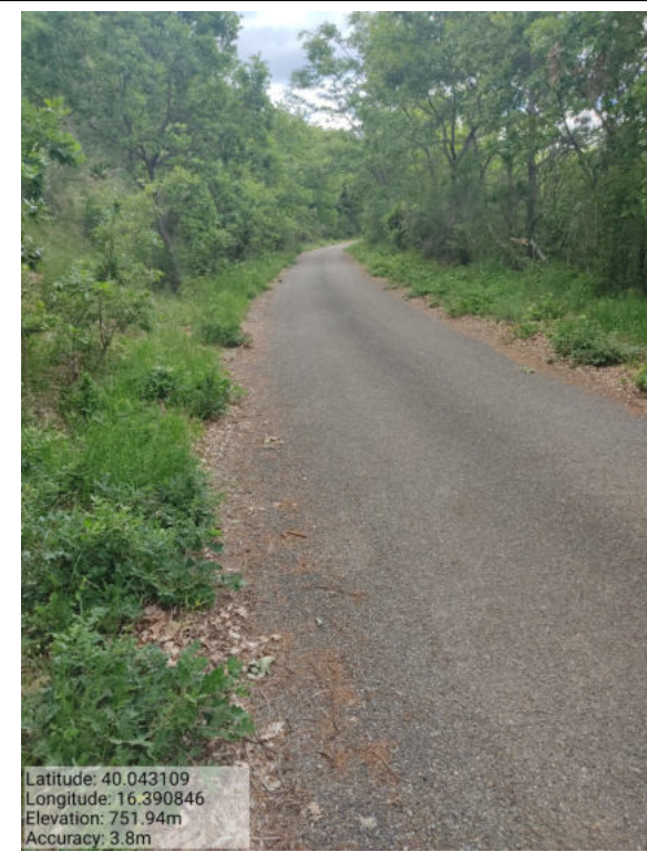
Int. _5.1.5_Manuten. Strade Loc. Monaca Pulli Foto 3
