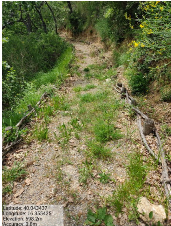
Int. _6.1.1_Manut. Vimate Loc. Scavi Foto 1
