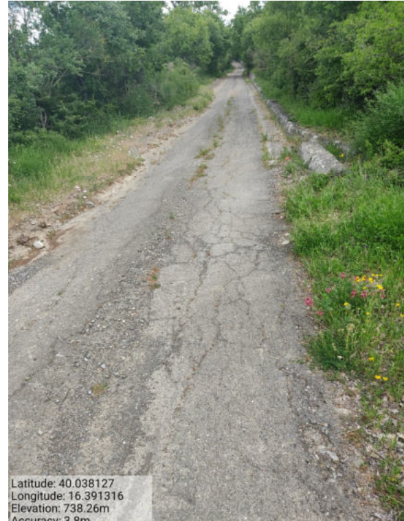
Int. _5.1.5_Manuten. Strade Loc. Monaca Pulli Foto 2
