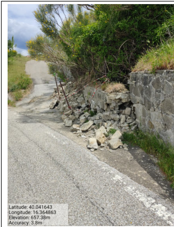
Int. _6.3.2_Man. Muretti in Pietra Loc. SS. 482 Foto 1
