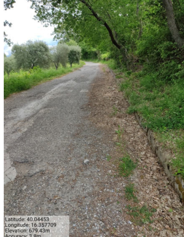
Int. _5.1.1_ Manutenzione Strade Loc. Colonia Foto 1
