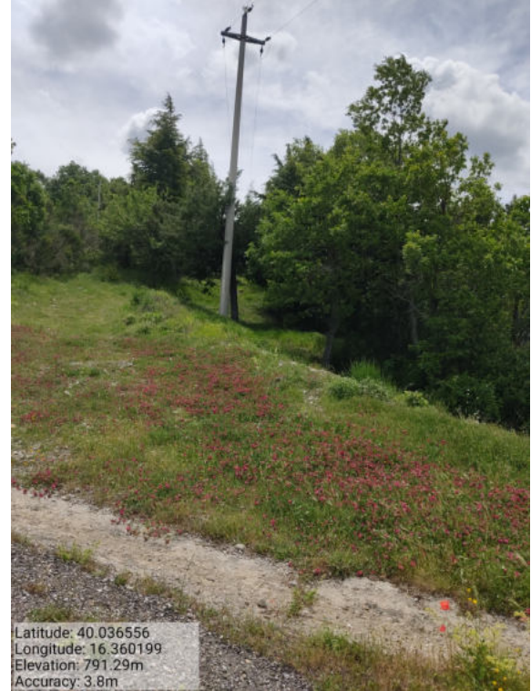
Int. _1.1.3_ Fascie Loc. Colonia - Foto 2
