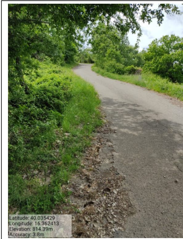
Int. _5.1.1_ Manutenzione Strade Loc. Colonia Foto 2
