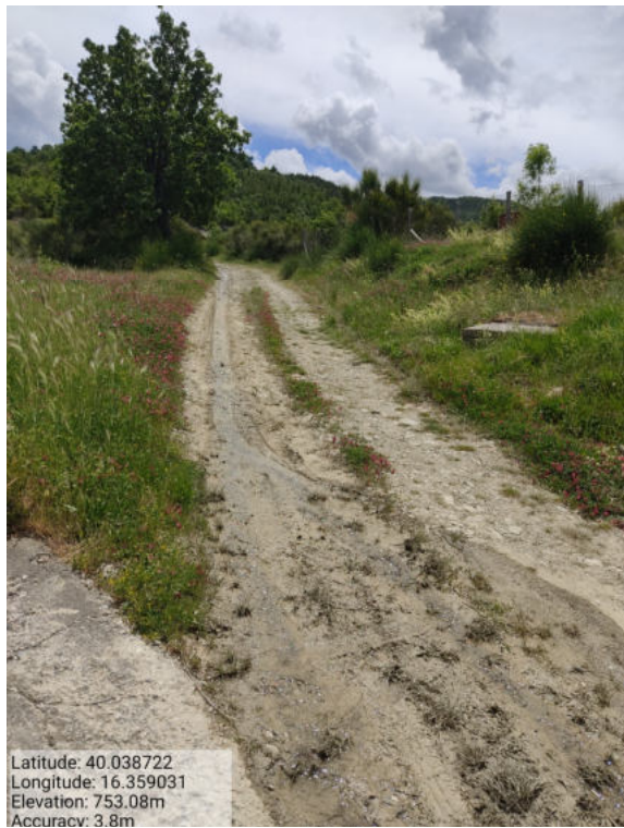
Int. _3.4.2_ Manutenzione Piste Loc. Capillo Foto 1
