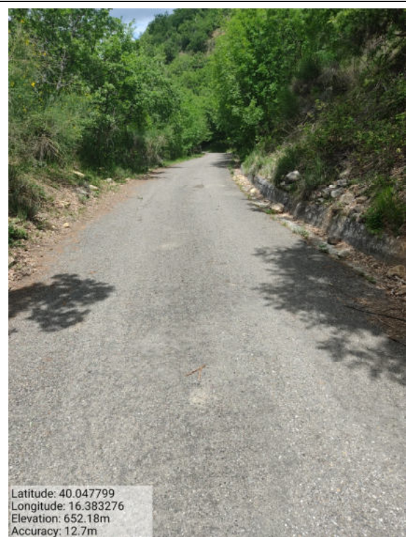
Int. _5.1.5_Manuten. Strade Loc. Monaca Pulli Foto 4
