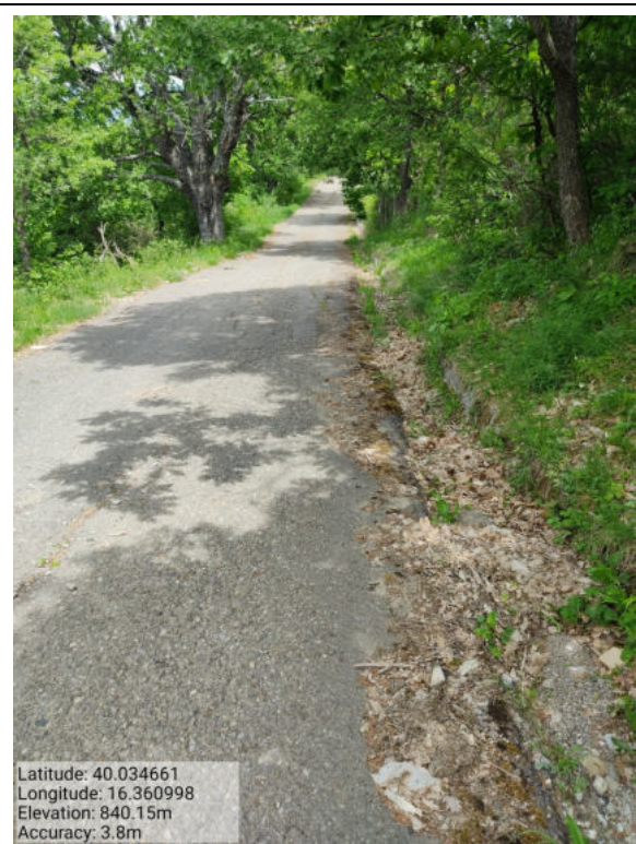
Int. _5.1.1_ Manutenzione Strade Loc. Colonia Foto 3
