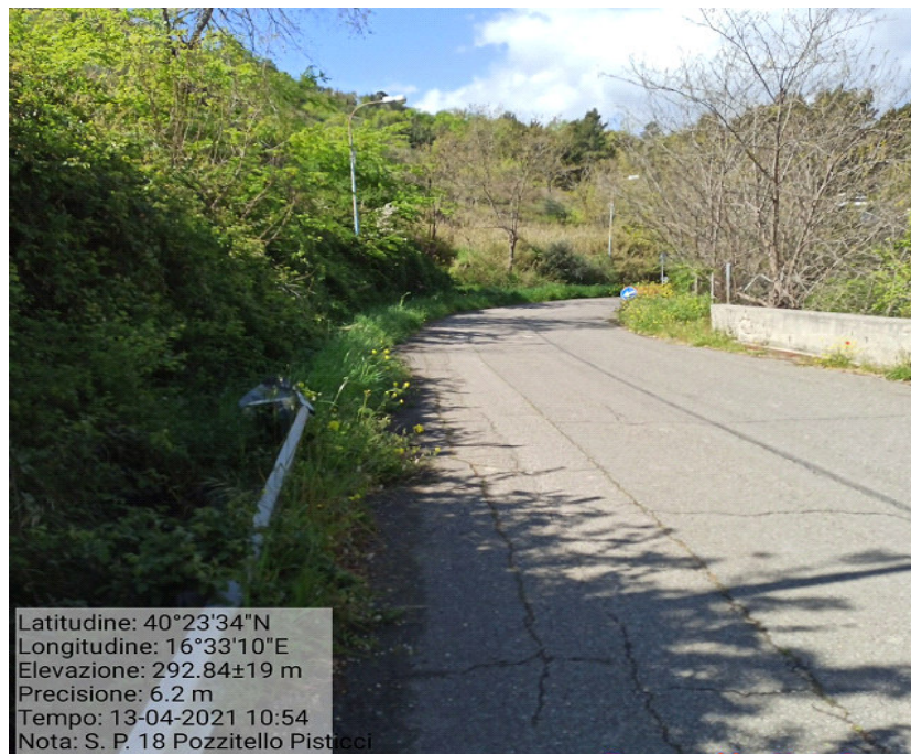
Int.5.1.1 S.P. 18 Pisticci-Pozzitello Manutenzione della Viabilità Decespugliamento scarpate stradali
