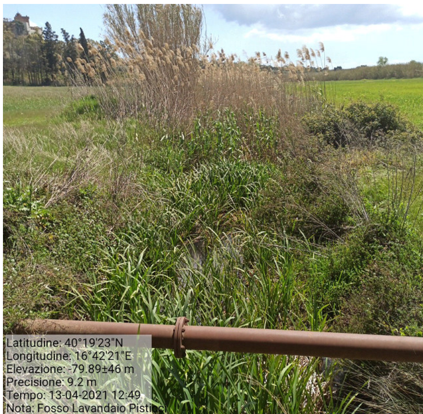
Int.4.1.4 Loc. Fosso Lavandaio Decespugliamento asta fluviale
