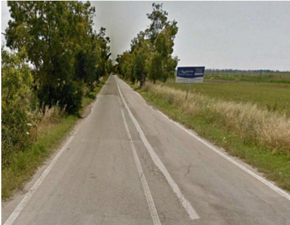
Int.5.1.2 S.P. 18 Pozzitello -San Basilio Manutenzione della Viabilità
