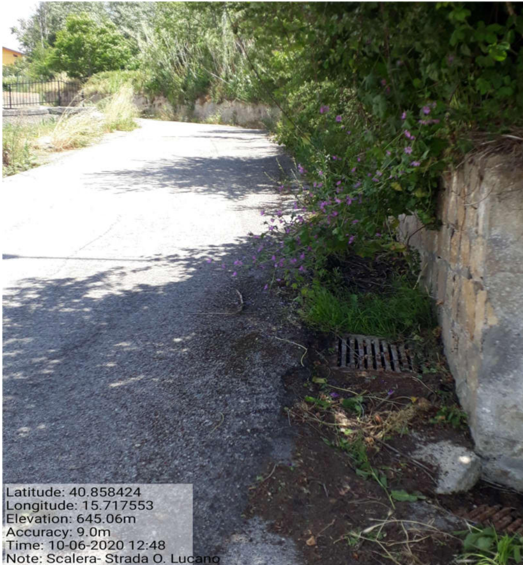
Foto 07 - Manutenzione strada comunale - Scalera - Filiano.
