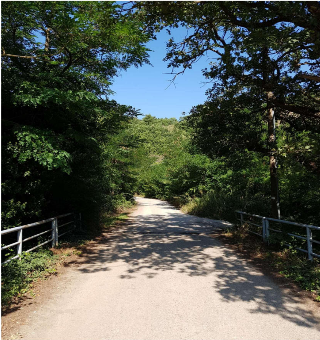
Foto 1,5 – Manutenzione strada provinciale/comunale – Pietragalla.
