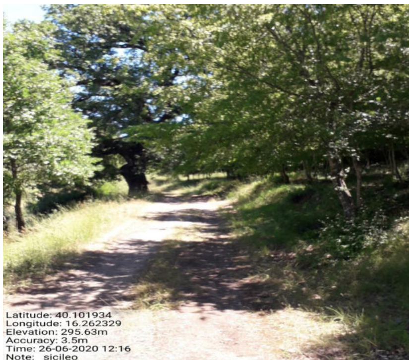
Int . Manutenzione viale tagliafuoco Loc. Sicileo
