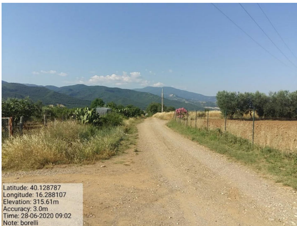
Int . Pulizia cunette e scarpate Loc. Strada Borelli
