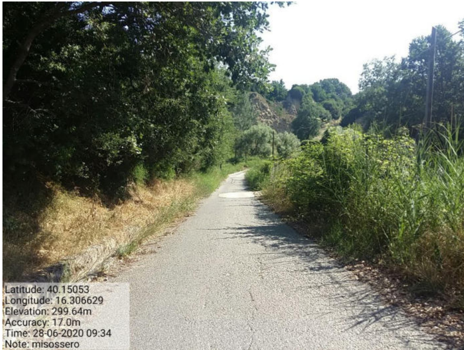
Int . Pulizia cunette e scarpate Loc. Strada Misossero
