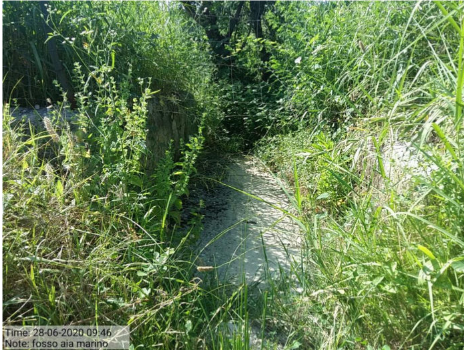
Int . Manutenzione canalette o fossi di guardia Loc. Fosso Aia Marina
