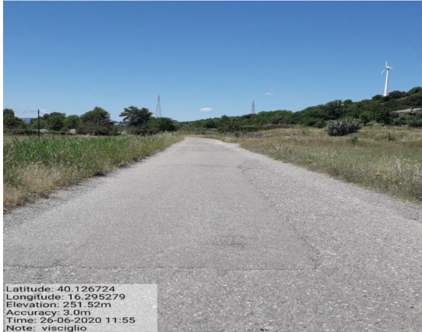
Int . Pulizia cunette e scarpate Loc. Strada Visciglio
