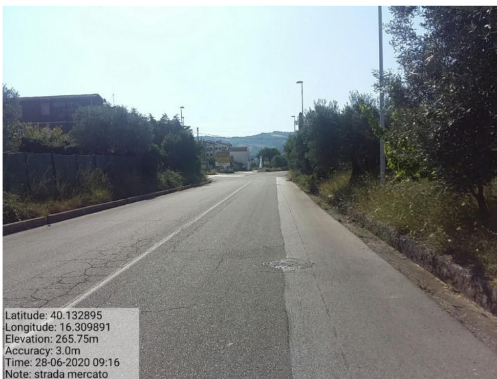
Int. Pulizia cunette e scarpate Loc. Strada Mercato
