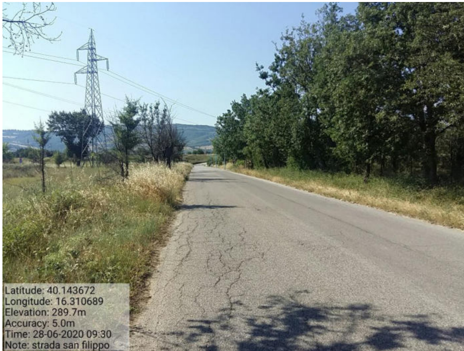
Int . Pulizia cunette e scarpate Loc. Strada San Filippo
