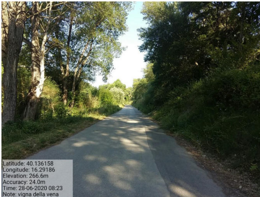
Int . Pulizia cunette e scarpate Loc. Vigna della Vena
