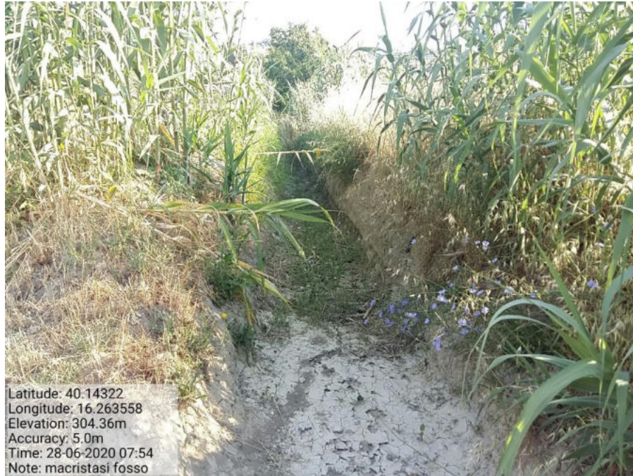
Int . Manutenzione canalette o fossi di guardia Loc. Fosso Macristasi
