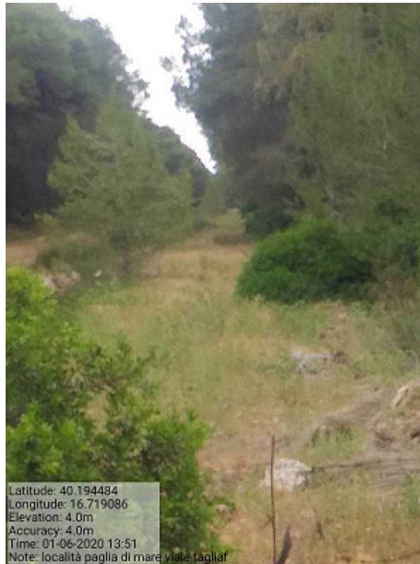
Int.1.1.3 Loc. Paglie di mare fg. 5 p.lle 110,116,965,123 Manutenzione viale tagliafuoco
