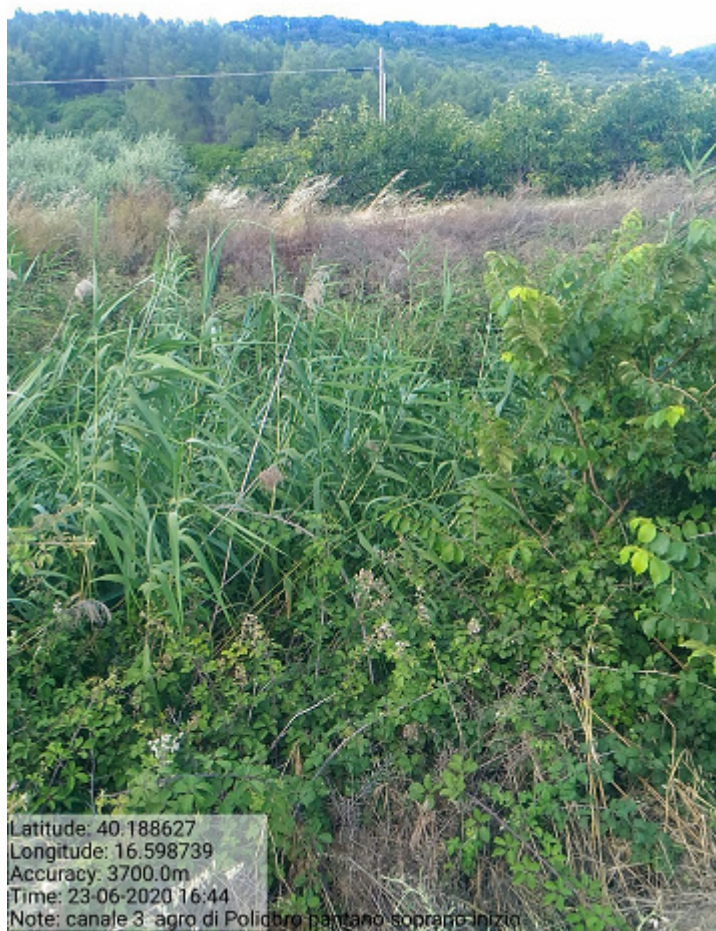
Int.4.1.2 Loc. Canale 3 Manutenzione aste fluviali
