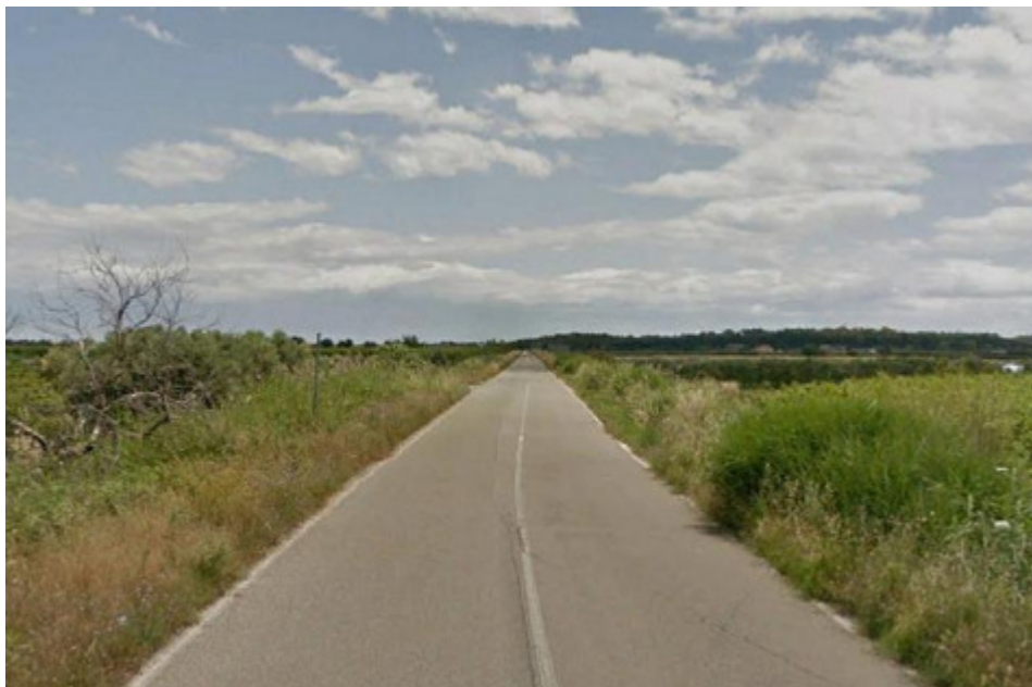
Int.5.1.3 Loc. Via san Giusto Manutenzione Viabilità Comunale e Provinciale
