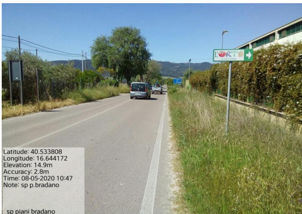
Int. 5.2.1 S.P. 33 Montescaglioso – Piani bradano - Pulizia cunette-
