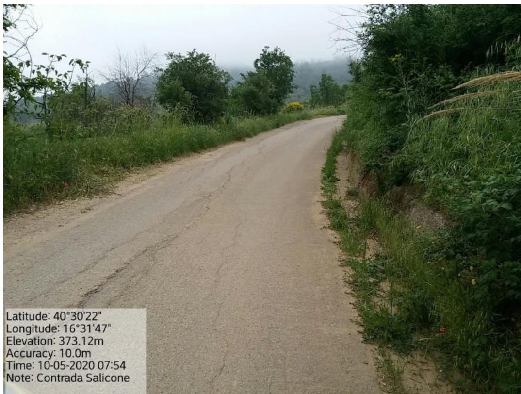
Int. 5.2.4 Loc. Strada Comunale da S.P. 24 - Contrada Salicone – Pulizia cunette
