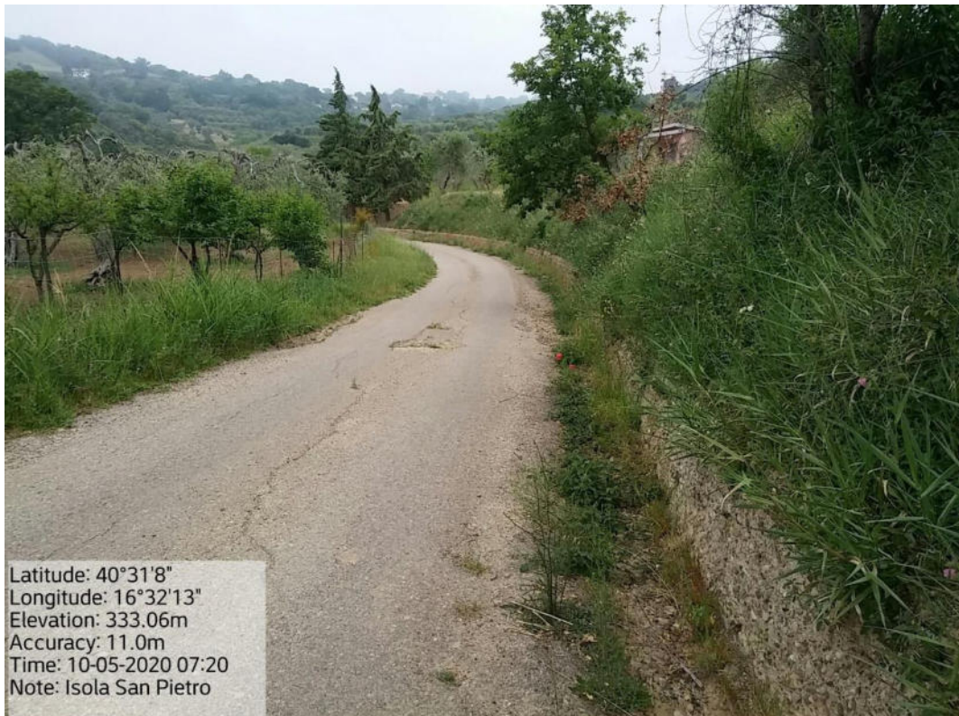
Int. 5.2.2 Loc. Strada Comunale Pomarico - Isola S. Pietro - Pulizia cunette
