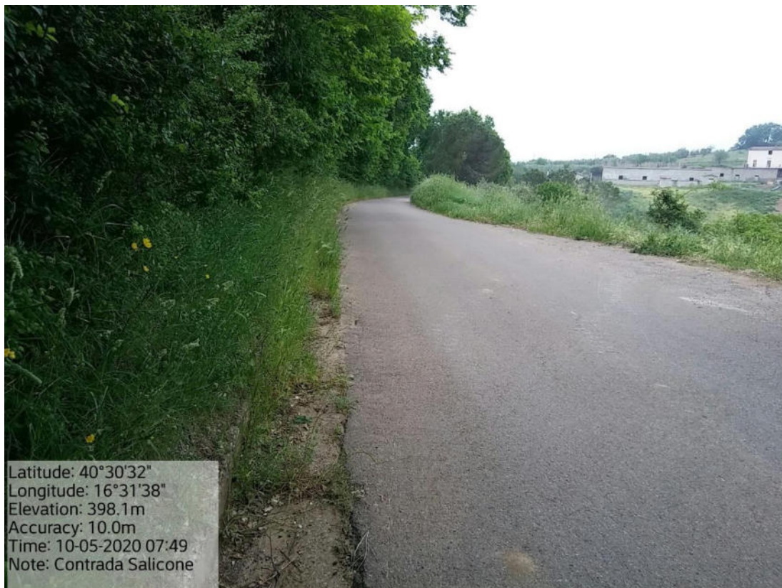
Int. 5.1.4 Loc. Strada Comunale da S.P. 24 - Contrada Salicone – Decespugliamento Scarpate stradali
