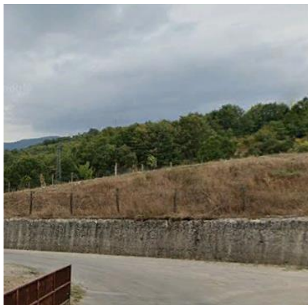
Int. 4.1.3- Strada forestale Discesa del Grillo – Pantanelle- Fiumicello foto n°1
