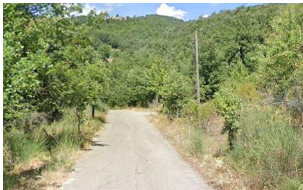
Int.6.3.8.1+6.3.8.2- Strada Valloni di sotto foto n°1
