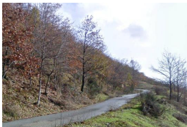
Int. 4.1.7- Strada turistica Sellata-Monteforte foto n°1
