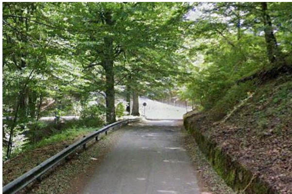
Int.6.3.1.1+6.3.1.2-S.P.5 Ponte Giardino-Sellata- Pignola- foto n°1
