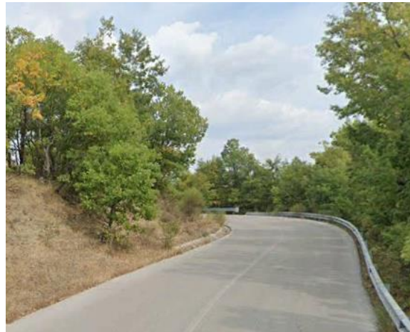
Int-6.3.9.1+6.3.9.2-Strada comunale Foresta foto n°2
