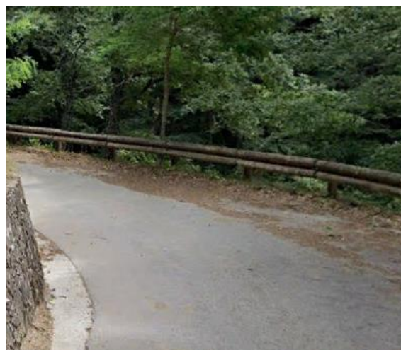
Int.1.1.2 – Fascia su Strada Sellata-Rifreddo foto n°2
