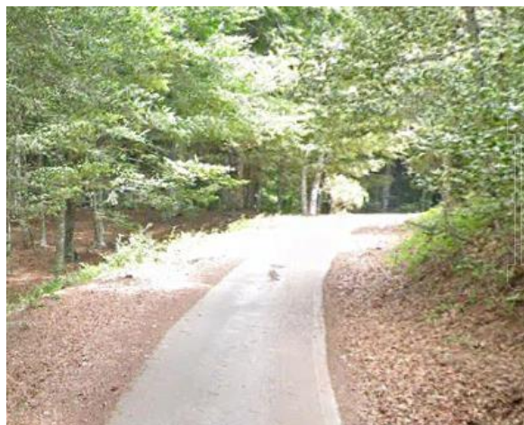
Int.1.1.2 – Fascia su Strada Sellata-Rifreddo foto n°1
