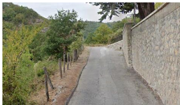
Int. 2.1.4- Area cimiteriale- Abriola Foto n°2
