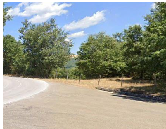
Int. 6.3.6.1+6.3.6.2-Strada Casinale foto n°2
