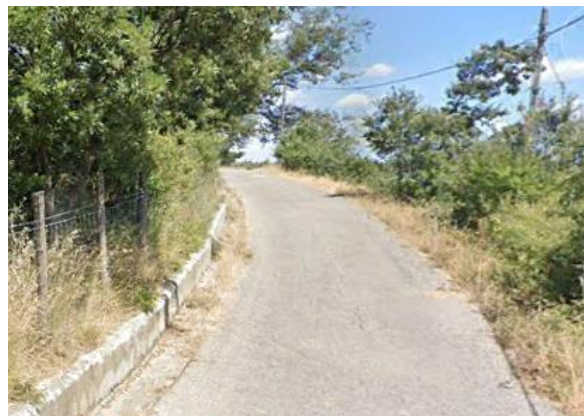
Int. 6.3.8.1+6.3.8.2 - Strada Valloni di sotto foto n°2
