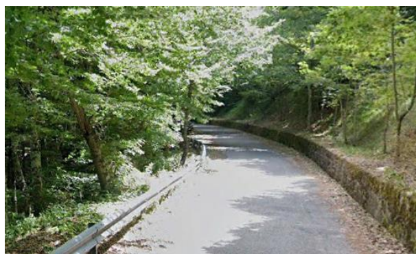
Int.1.1.1- Fascia su Strada Sellata- Arioso foto n°1
