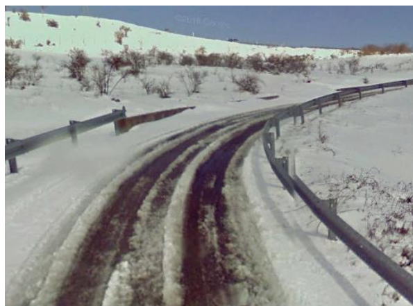
Int.6.3.2.1+6.3.2.2- Strada San Giovanni- Case Romano- Masseria Smaldore- foto n°1
