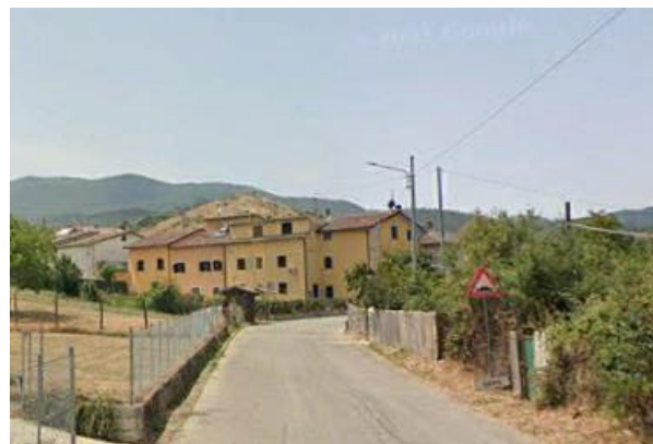
Int. 2.1.3– Centro abitato loc. Tintiera Foto n° 2
