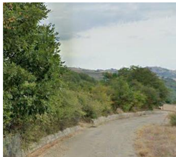
Int. 6.3.7.1+6.3.7.2 - Strada Cugni-Farneta foto n°2
