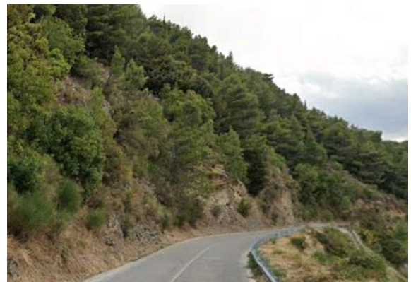
Int. 6.3.1.1+6.3.1.2 - S.P.5 Ponte Giardino-Sellata- Pignola- foto n°2
