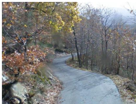
Int. 4.1.7- Strada turistica Sellata-Monteforte foto n°2
