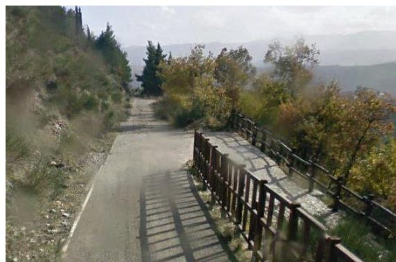
Int. 4.1.1- Strada forestale variante Monteforte foto n°2
