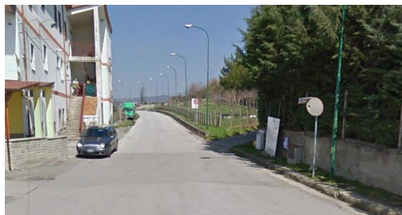
Int. 2.1.2 – Frazione San Donato foto n°1
