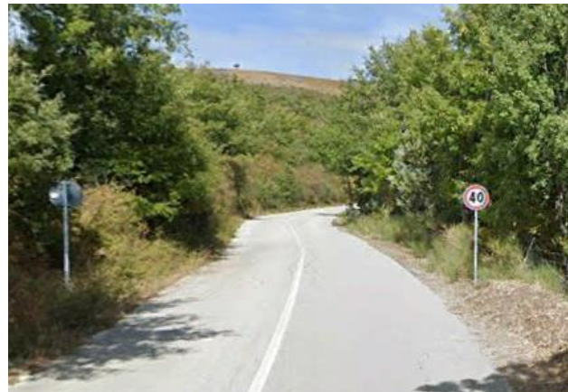
Int. 6.3.8.1+ 6.3.8.2 - Sp.13 tratto Anzi- Abriola foto n°2
