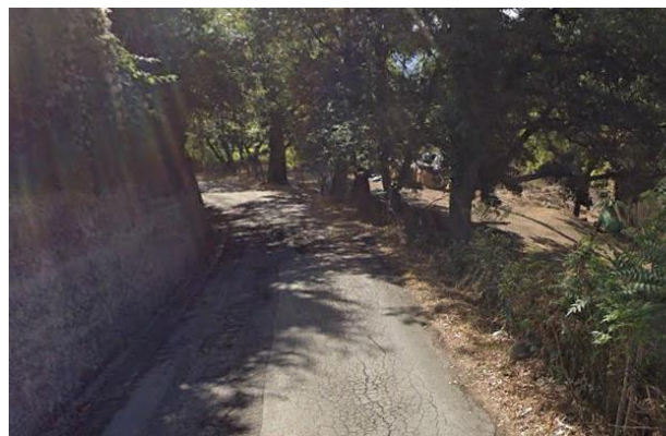
Int.6.3.7.1+6.3.7.2 - St. S. Giovanni- Chiuse SS 92 foto n°2
