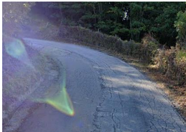
Int. 6.3.7.1+6.3.7.2- St. S. Giovanni- Chiuse SS 92 foto n°1
