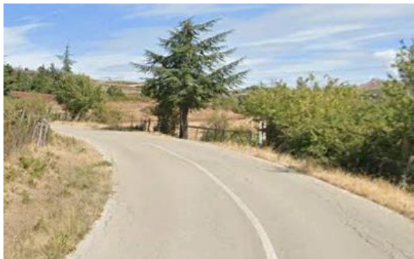
Int. 6.3.8.1+ 6.3.8.2- Sp.13 tratto Anzi- Abriola foto n°1
