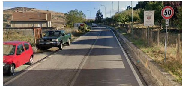
Int. 2.1.2 – Frazione San Donato foto n°2
