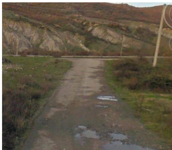
Int. 6.3.4.1+ 6.3.4.2 - SP.32 bis Calvello- bivio Camastra Foto n°1
