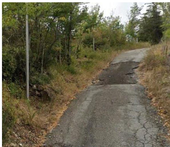
Int. 6.3.8.1 + 6.3.8.2- strada comunale Foresta- 1° tratto foto n°1
