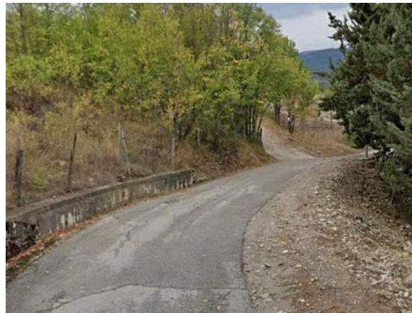
Int. 6.3.9.1 + 6.3.9.2- strada comunale Foresta- 2°tratto foto n°2
