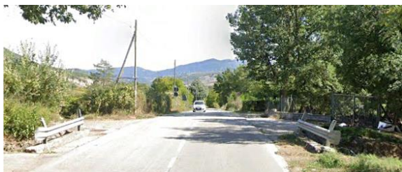
Int. 6.1.4. – Fosso Pincia foto n°1
