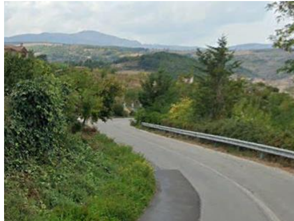
Int. 1.1.1. Fascia n°1 su S.P. 16 foto n°2
