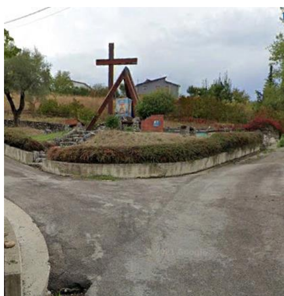
Int. 6.3.9.1 + 6.3.9.2- strada comunale Foresta- 2°tratto foto n°1
