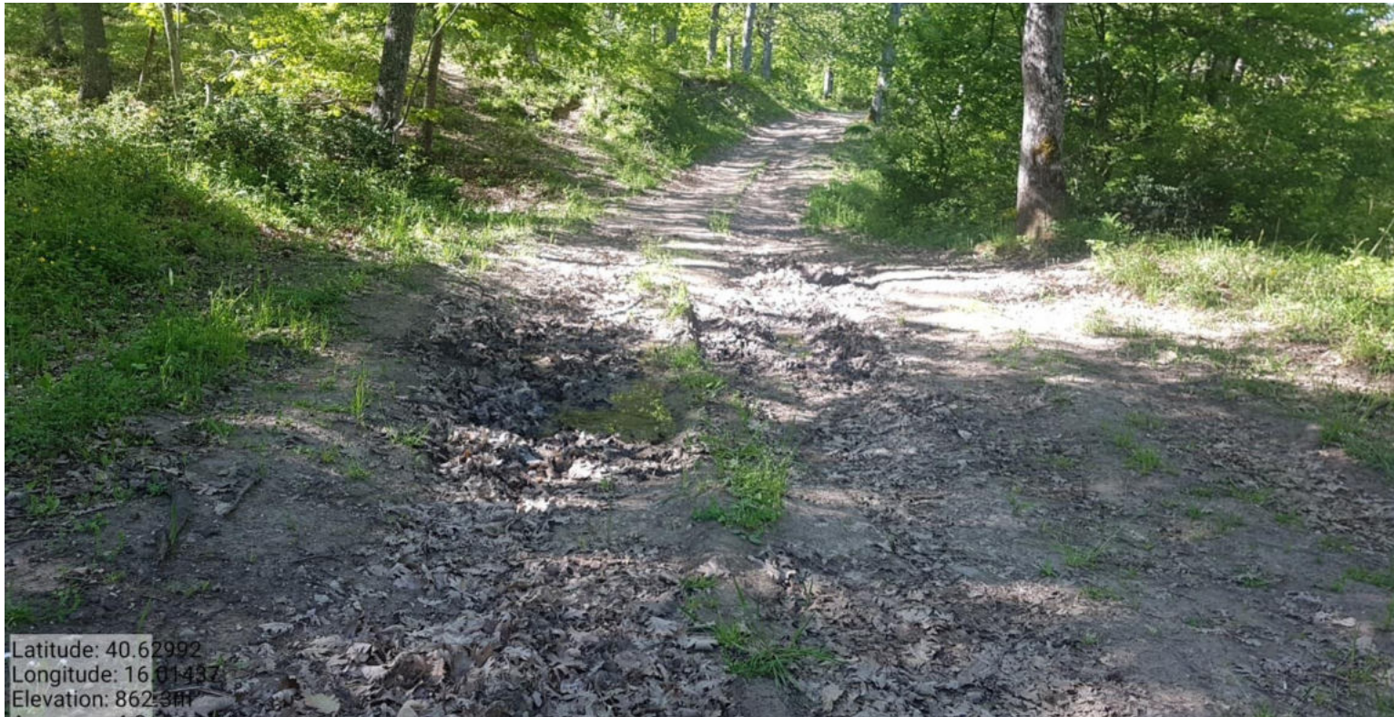
Strada di servizio "Fontana delle nocelle" - Intervento 4.1.1.
