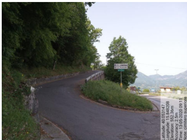
5.1.3 Strada Cimitero Rione Superiore
