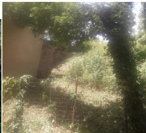
4.1.6 Pulizia Serbatoi Consorzio Torbido – S.Iorio - Bamonte
