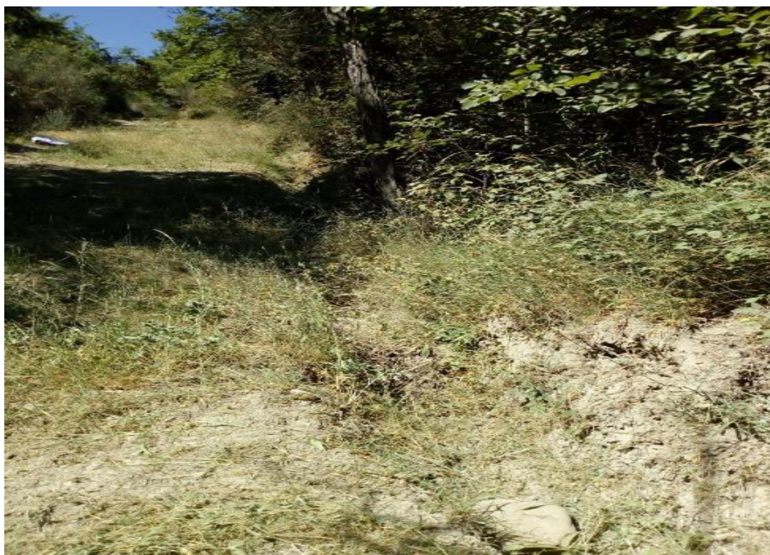
LOC : intervento 6.1.1 manuten.annuale canalette
