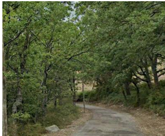
Int. 6.3.2.1+6.3.2.2– Strada Santa Filomena-Castelbello foto n°2
