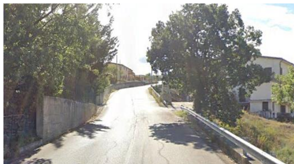
Int. 6.3.1.1+6.3.1.2– Strada da piscina a Santa Filomena foto n°1
