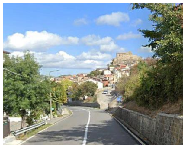
Int. 6.3.8.1+6.3.8.2- Strada centro abitato-torrente Coccone foto n°2
