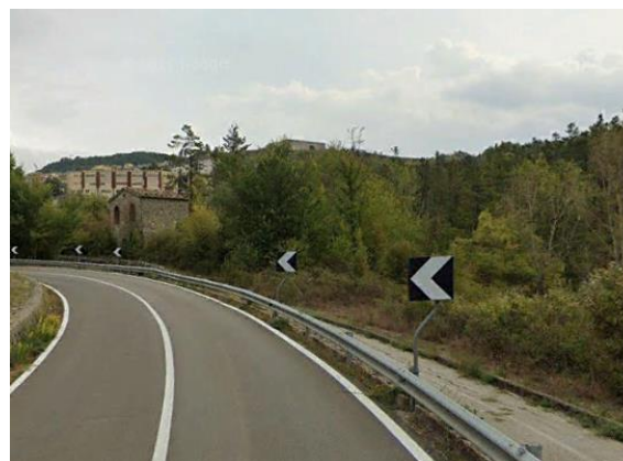
Int. 6.1.3- Torrente Coccone foto n°2
