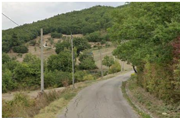
Int. 6.3.2.1+6.3.2.2– Strada Santa Filomena-Castelbello foto n°1
