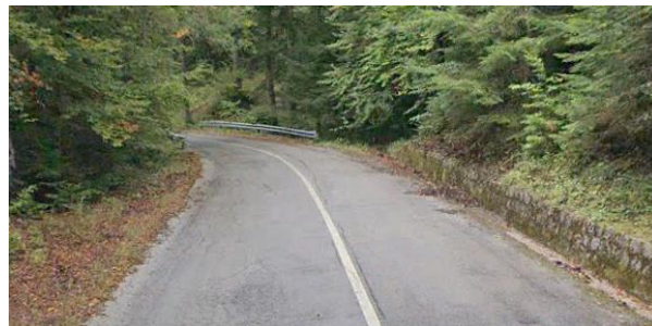
Int. 4.1.1– Strada forestale Barraccone Pasquino foto n°2
