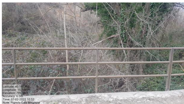
Int. 6.1.3- Attraversamento Strada C. da Magnone Foto n°1
