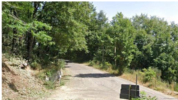
Int. 6.3.9.1+6.3.9.2- Strada frazione Sciffra Foto n°1
