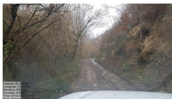
Int. 4.1.1- Strada forestale per l'abbazia di San Michele Foto n° 2
