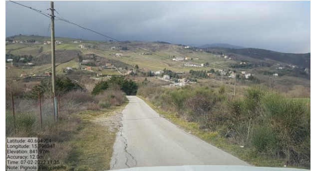
Int. 6.3.15.1+6.3.15.2- Strada Via del Vallone Foto n°2
