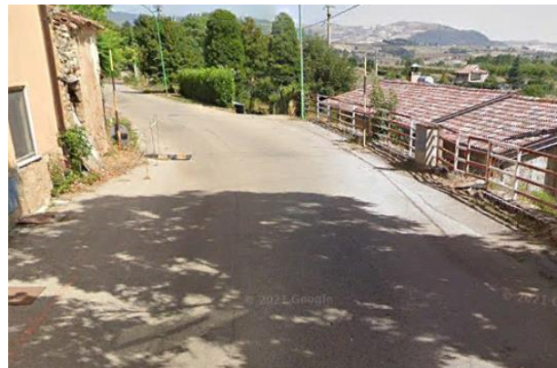
Int. 6.3.9.1+6.3.9.2-Strada frazione Sciffra Foto n°2
