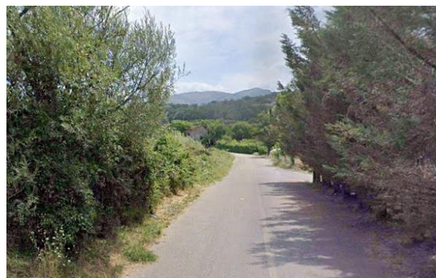
Int.2.1.7+2.2.7-Pista ciclopedonale Pignola-lago Foto n° 2
