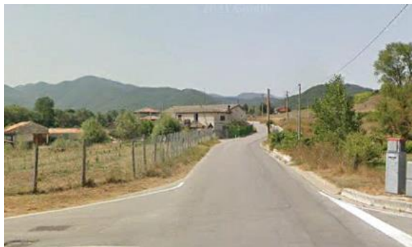
Int. 6.3.4.1+6.3.4.2 - Strada comunale campo di Giorgio- Area artigianale- Ponte delle tavole Foto n°1
