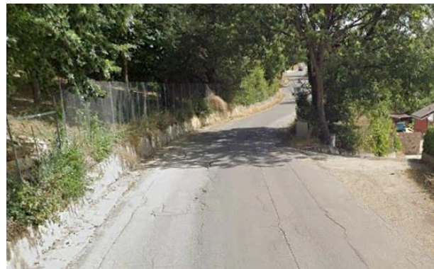
Int. . 6.3.4.1+6.3.4.2 - Strada comunale campo di Giorgio- Area artigianale- Ponte delle tavole Foto n°2
