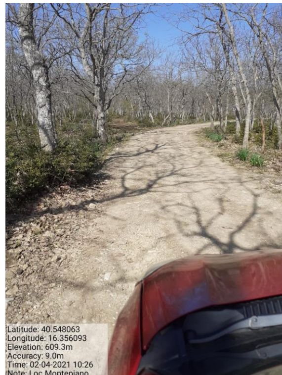
Int.3.2.3 Manutenzione di Strada forestale di servizio Foto 6
