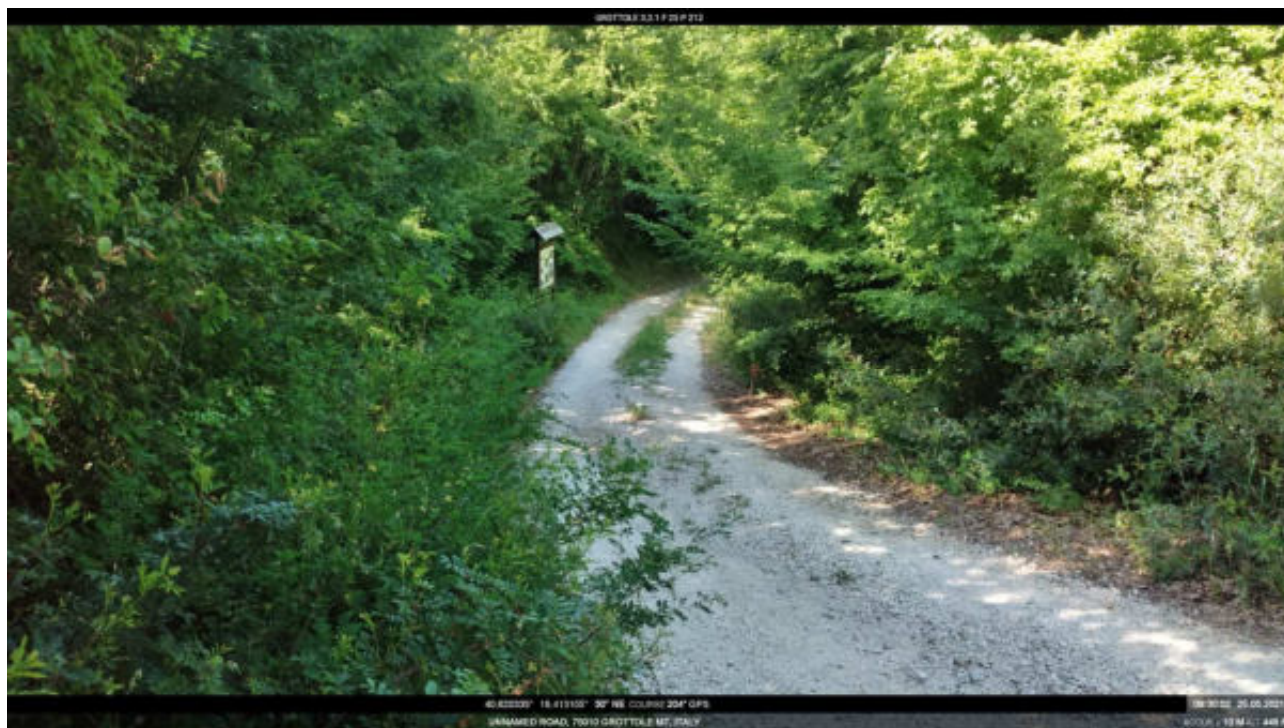
Intervento 3.2.1 Grottole Grottole F.25 Part.212 Loc. Coste Lat. 40.620335 Lon.16.413105 FOTO N.9
