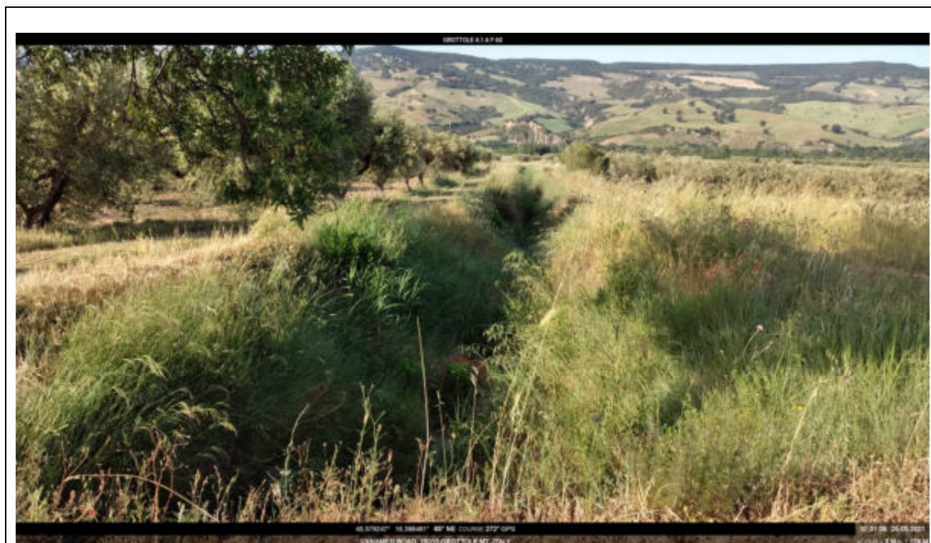
Intervento 4.1.6 Grottole F.60 Canale 6 Ischia Basento Lat. 40.579247 Lon. 16.398481 FOTO N.16
