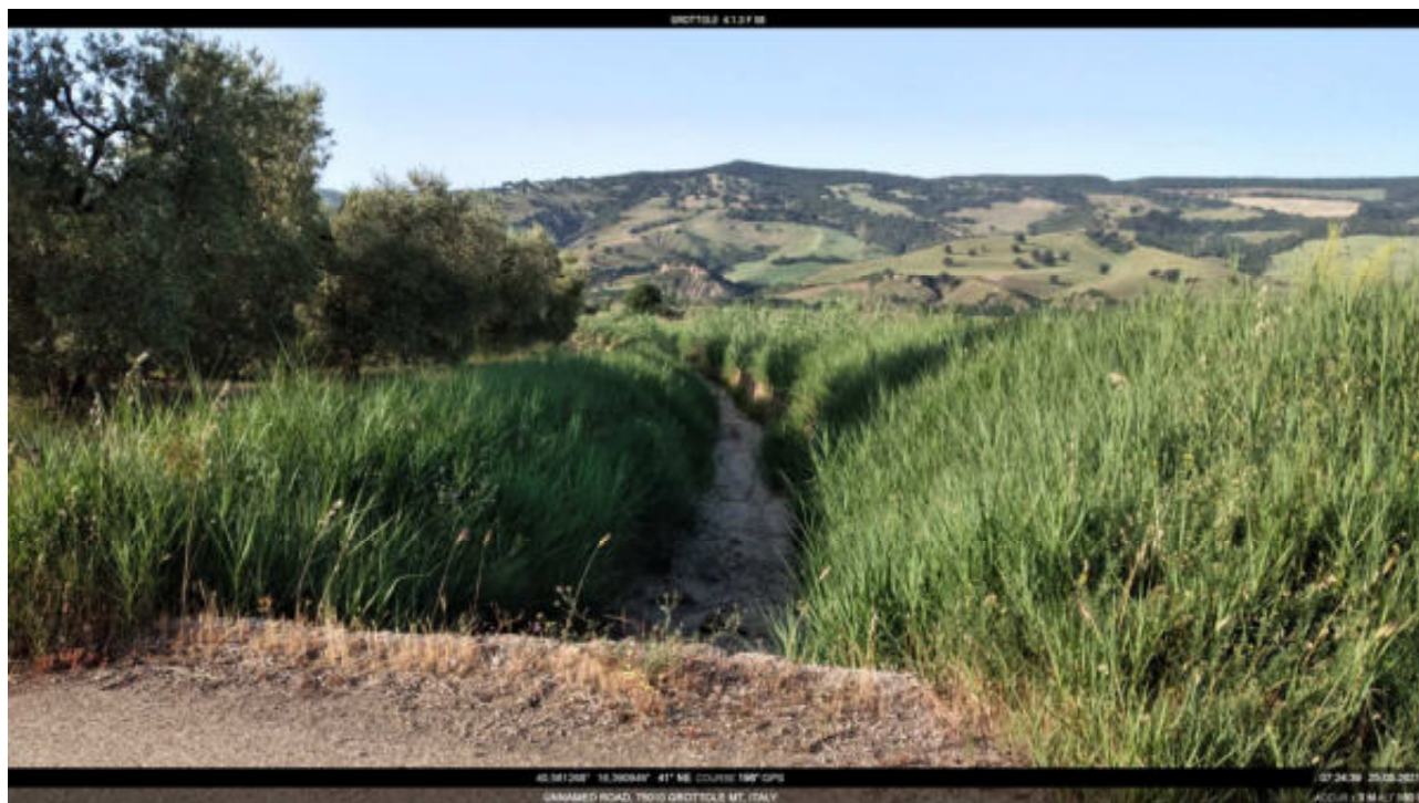
Intervento 4.1.3 Grottole F.58 Canale 3 Ischia Basento Lat. 40.581268 Lon. 16.390949 FOTO N.13
