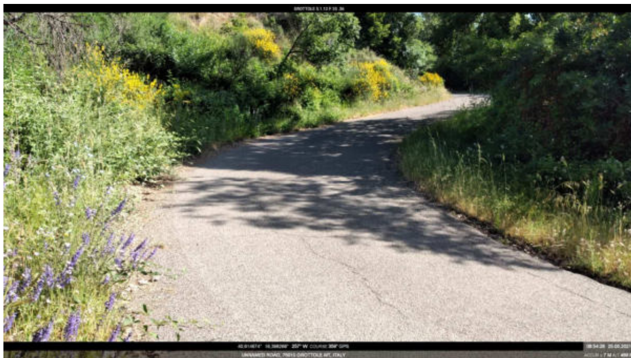
Intervento 5.1.12 Grottole Fg.35-36 part.Strade - Starda Comunale Pietrarola - Bosco Coste Lat.40.614674 Lon.16.398266
