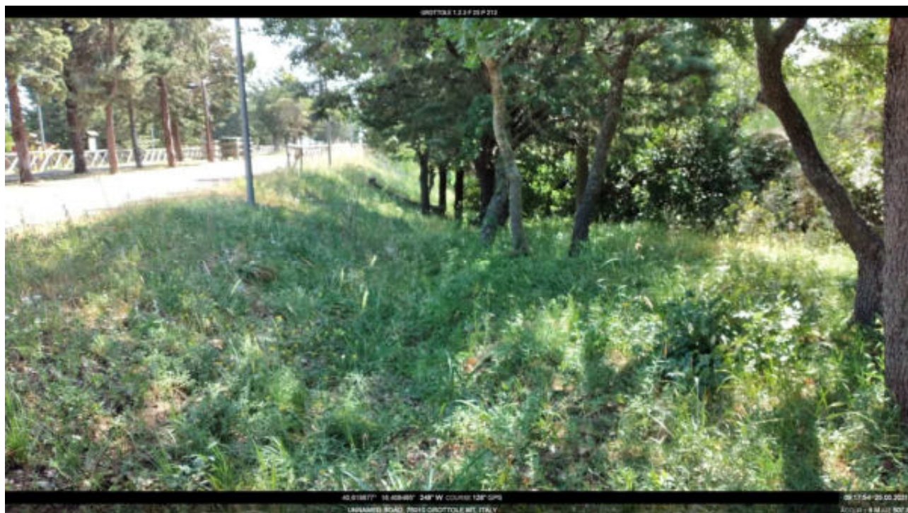
Intervento 1.2.3 Loc. Grottole Fg.25 part.212 -Coste Lat. 40.619877 Lon. 16.408435 FOTO N.5
