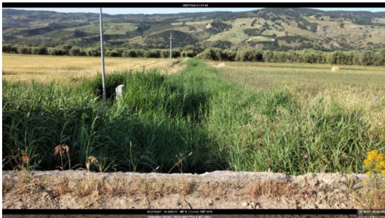
Intervento 4.1.9 Grottole F.60 Canale 9 Ischia Basento Lat. 40.574520 Lon. 16.408272 FOTO N.19
