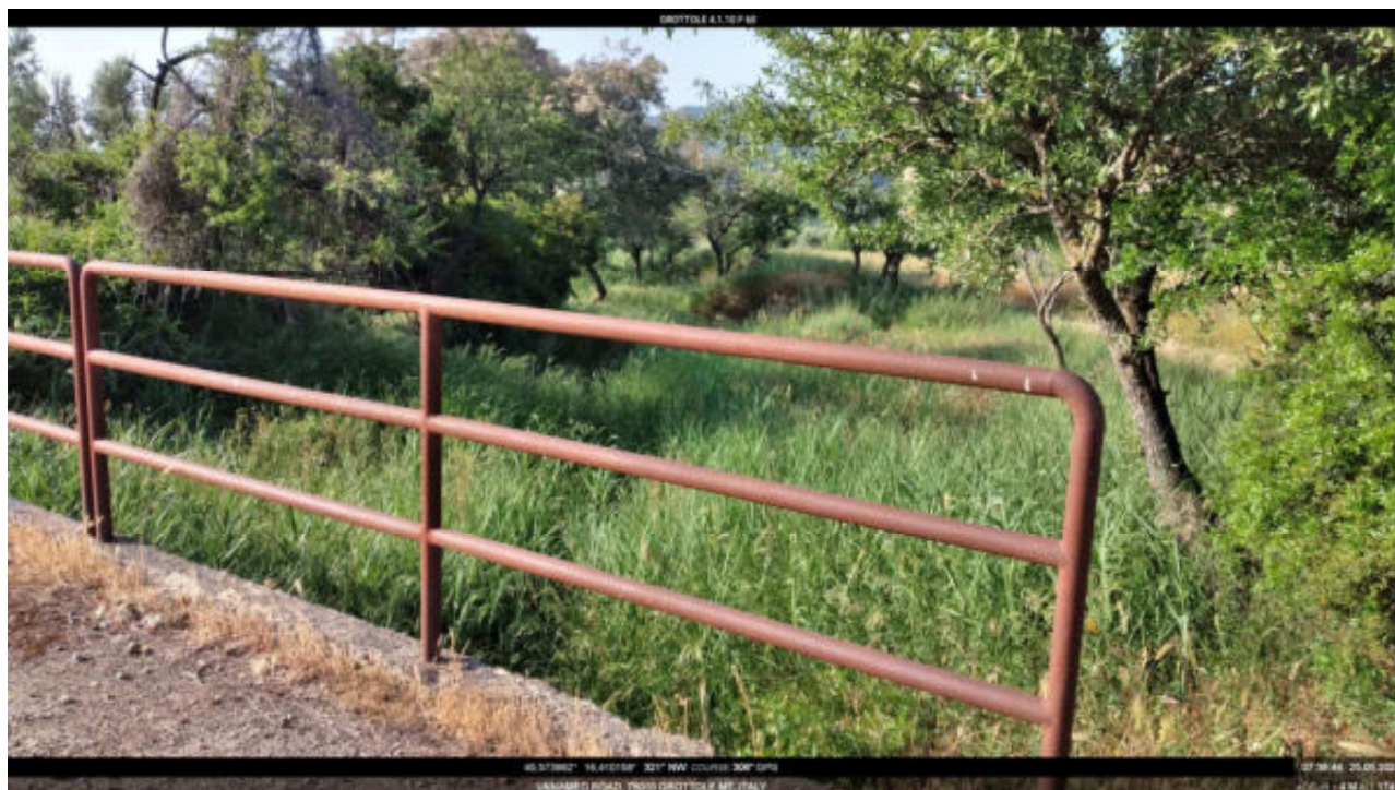
Intervento 4.1.10 Grottole F.60 Canale 10 Ischia Basento Lat. 40.473882 Lon. 16.410158 FOTO N.20
