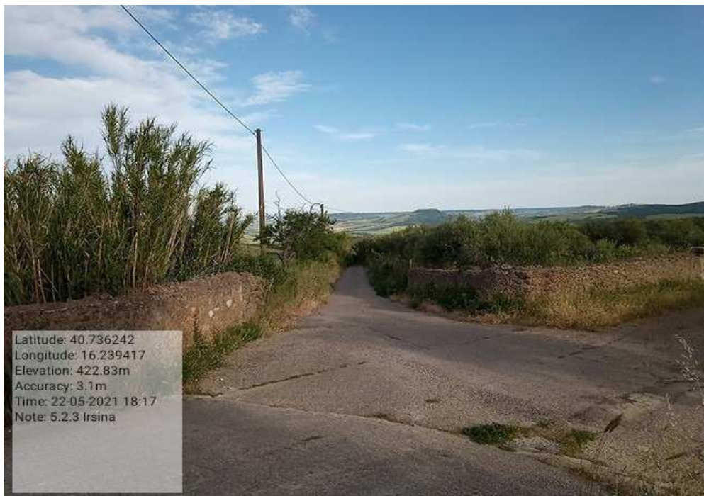
Intervento 5.1.3 Irsina Fg.43 -44 Strada Comunale Fontanelle
