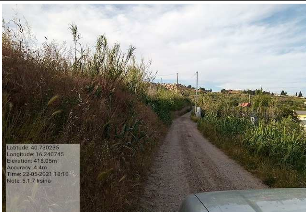
Intervento 5.1.7 Irsina Fg.55 Strada Comunale Contrada Festole FOTO 12
