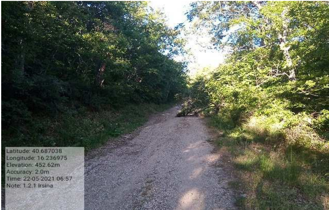
Intervento 1.2.1 Irsina Fg.73 Part.210 Bosvo Verrutoli
