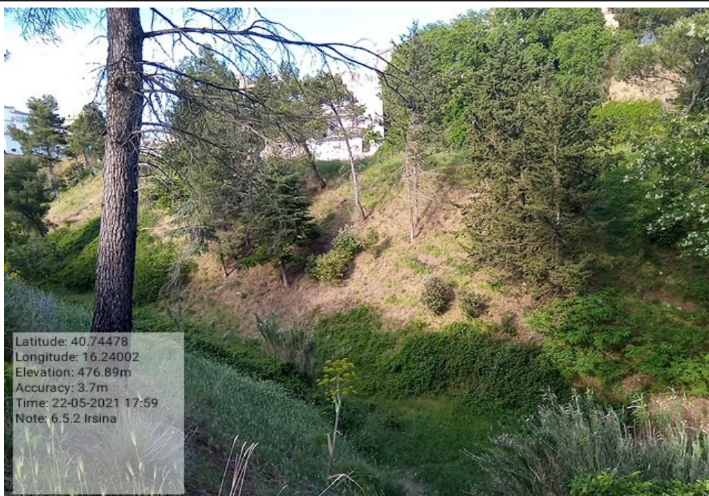
Intervento 6.5.2 Irsina Fg.79 part.1246 Fg.42 part. 199 Parco Rodari
