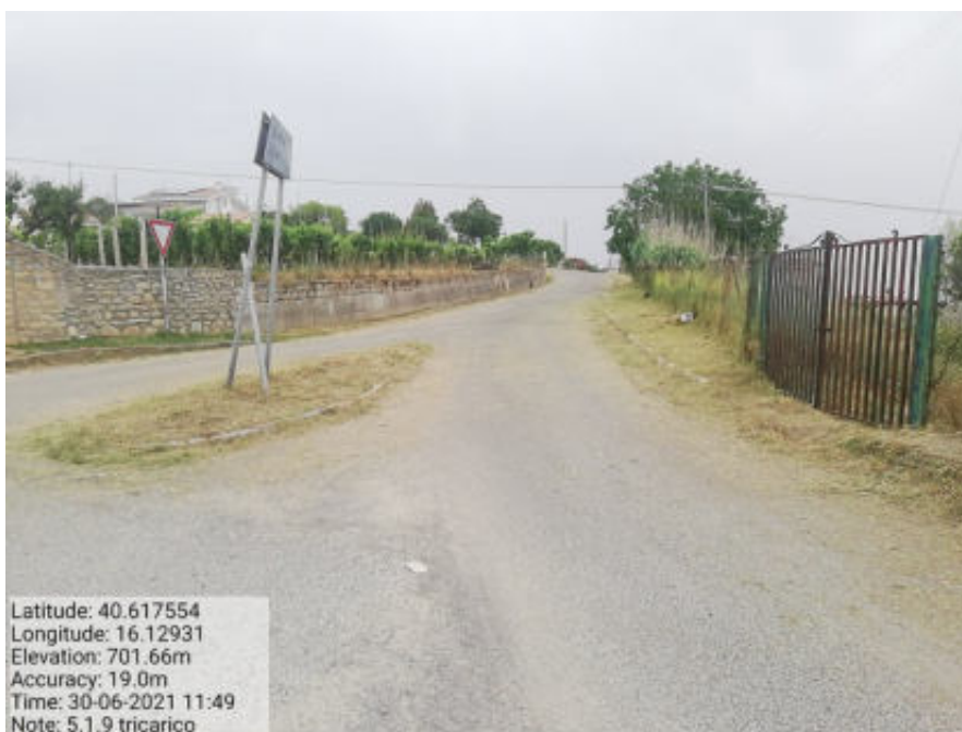
Int. 5.1.9 Tricarico Fg. 59 Strada Comunale Salumificio DOPO
