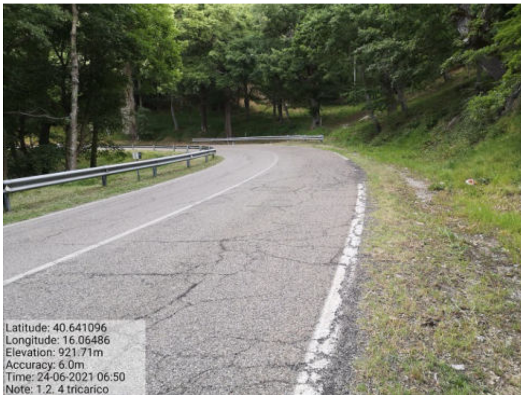
Int.1.2.4 Part. Tricarico Fg.50 171 Loc.Trecancelli DOPO
