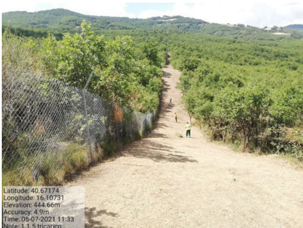
Intervento 1.1.5 Tricarico Fg.11 part.1-27 Loc. Vallone San Chirico DURANTE
