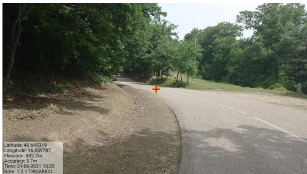
Intervento 1.2.1 Tricarico Fg.42 Part.184 Loc.Trecancelli-
