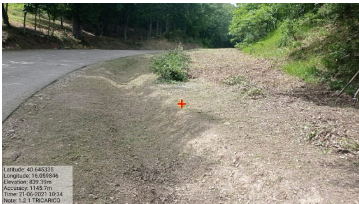
Intervento 1.2.1 Tricarico Fg.42 Part.184 Loc.Trecancelli-
