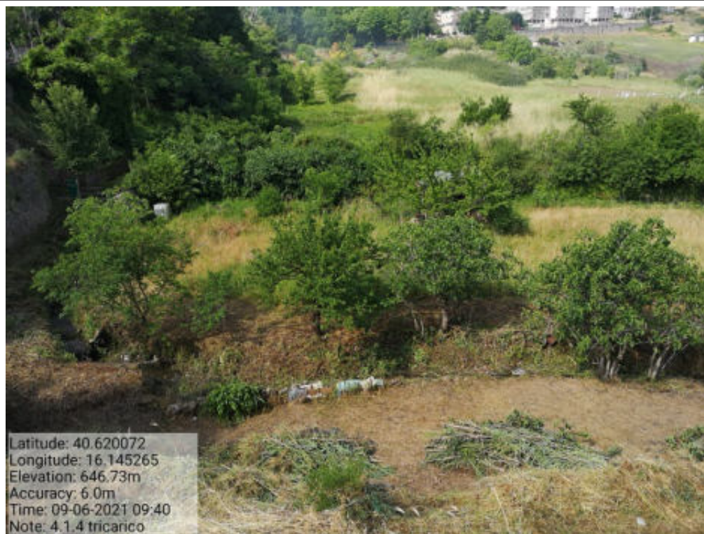
Int.4.1.1 Tricarico Fg.65- Part. Acque VALLONE CACARONE 1° TRATTO DURANTE
