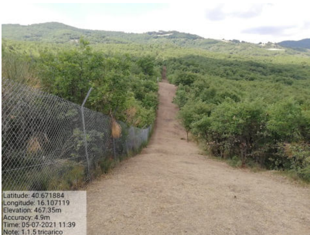
Intervento 1.1.5 Tricarico Fg.11 part.1-27 Loc. Vallone San Chirico DOPO
