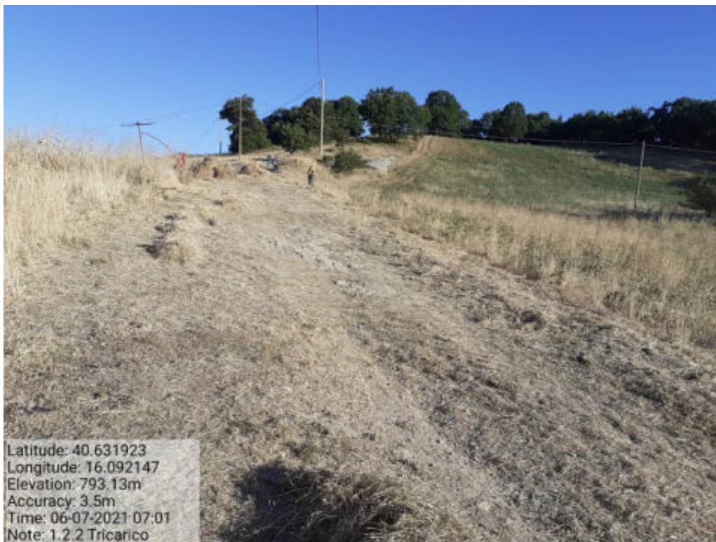
INTERVENTO 1.2.2 TRICARICO F.g.42 part. 43 LOC. CARBONARA
