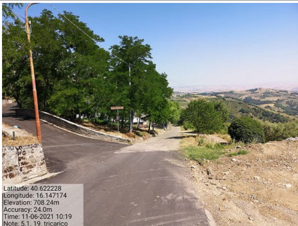
Int. 5.1.19 Tricarico Fg.54-61 Strada Comunale Saracena –DOPO
