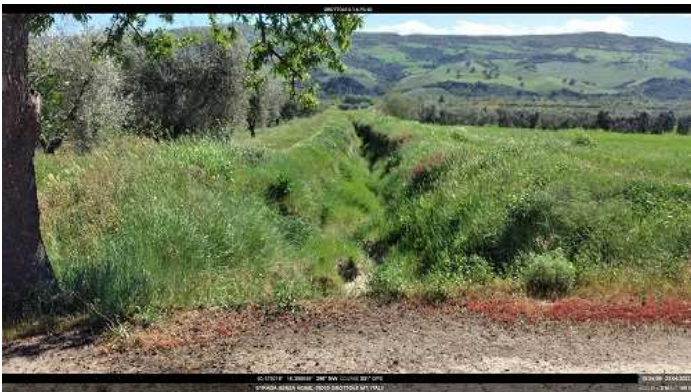
INTERVENTO 6.1.6 Grottole F.60 Canale 6 Ischia Basento
