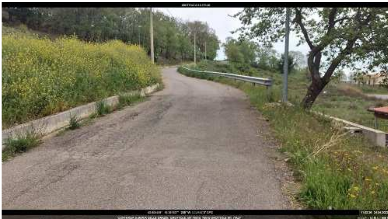
INTERVENTO 6.3.3.1 Grottole F.40 Strada comunale per il Cimitero
