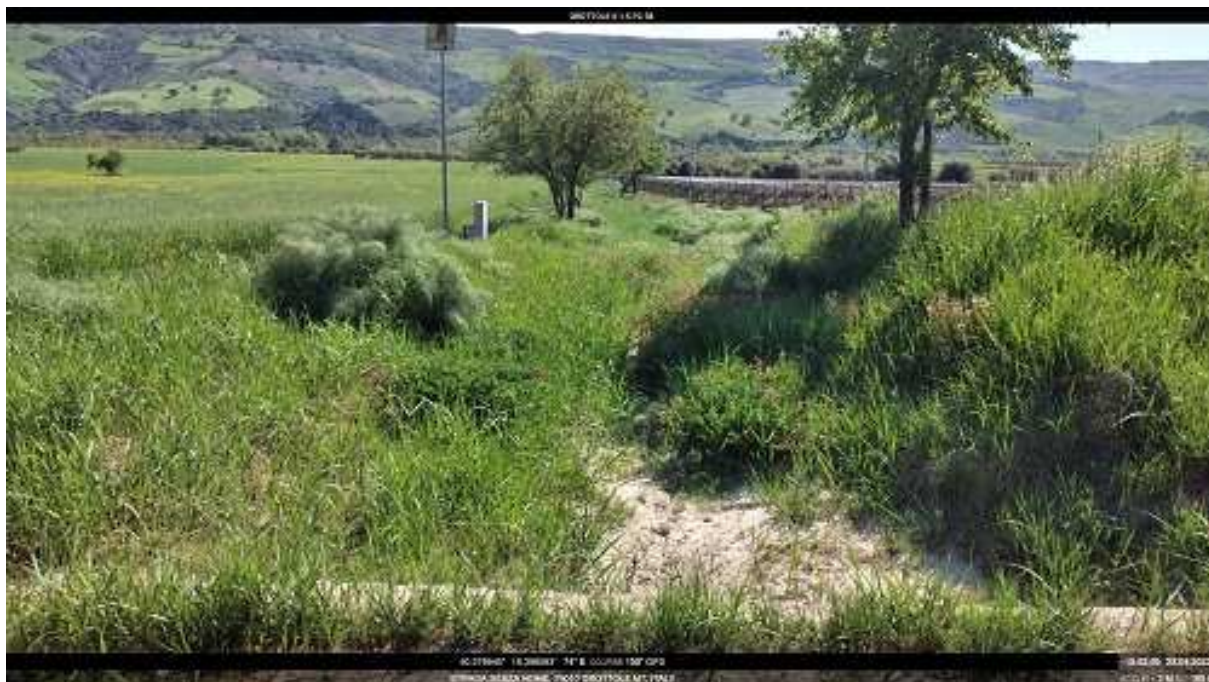
Intervento 6.1.5 Grottole F.58 Canale 5 Ischia Basento
