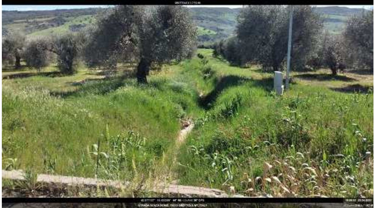
Intervento 6.1.7 Grottole F.60 Canale 7 Ischia Basento
