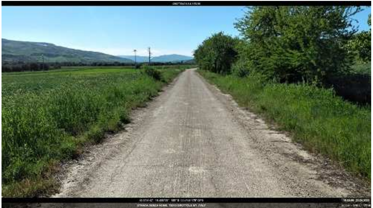
Intervento 6.3.4.1 Grottole F.58 - 60 Strada Comunale Ischia Basento
