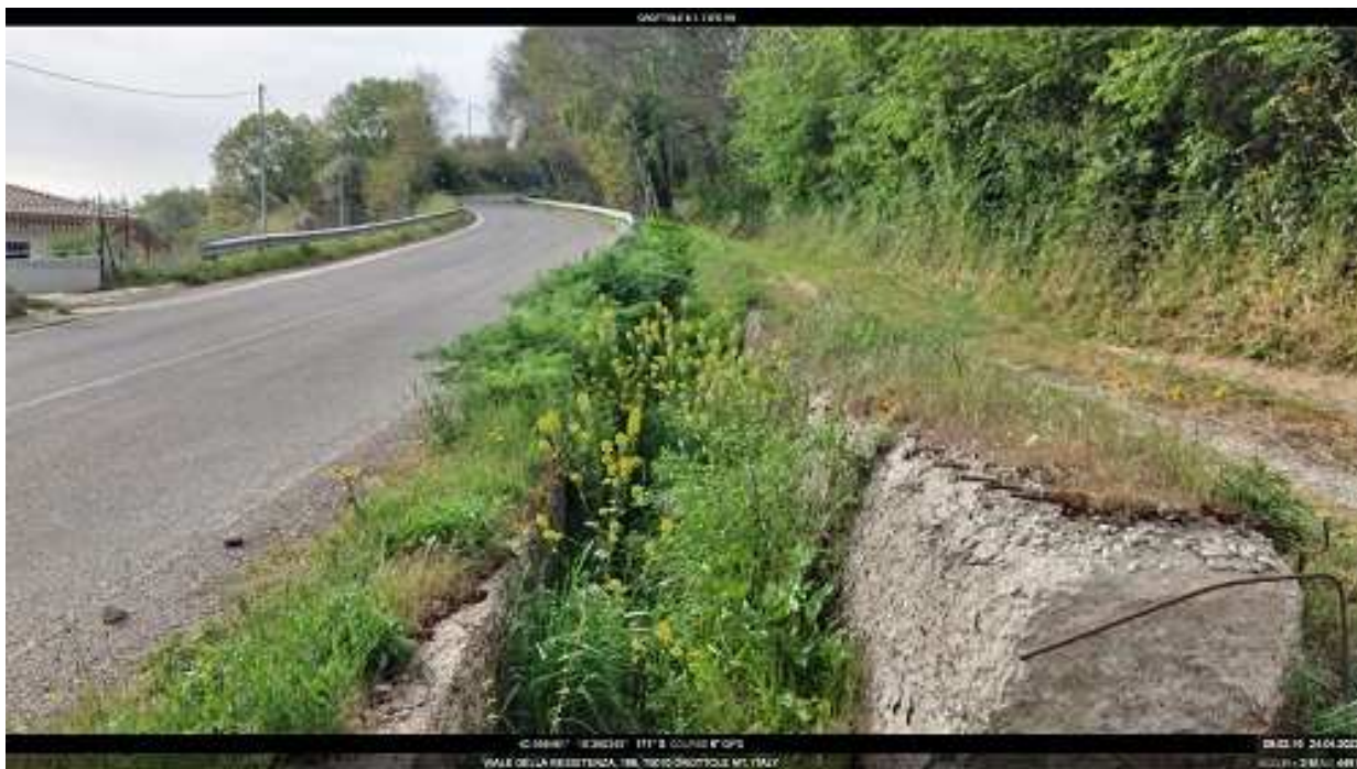
Intervento 6.1.1 Grottole F.53 Canale 1 Ischia Basento
