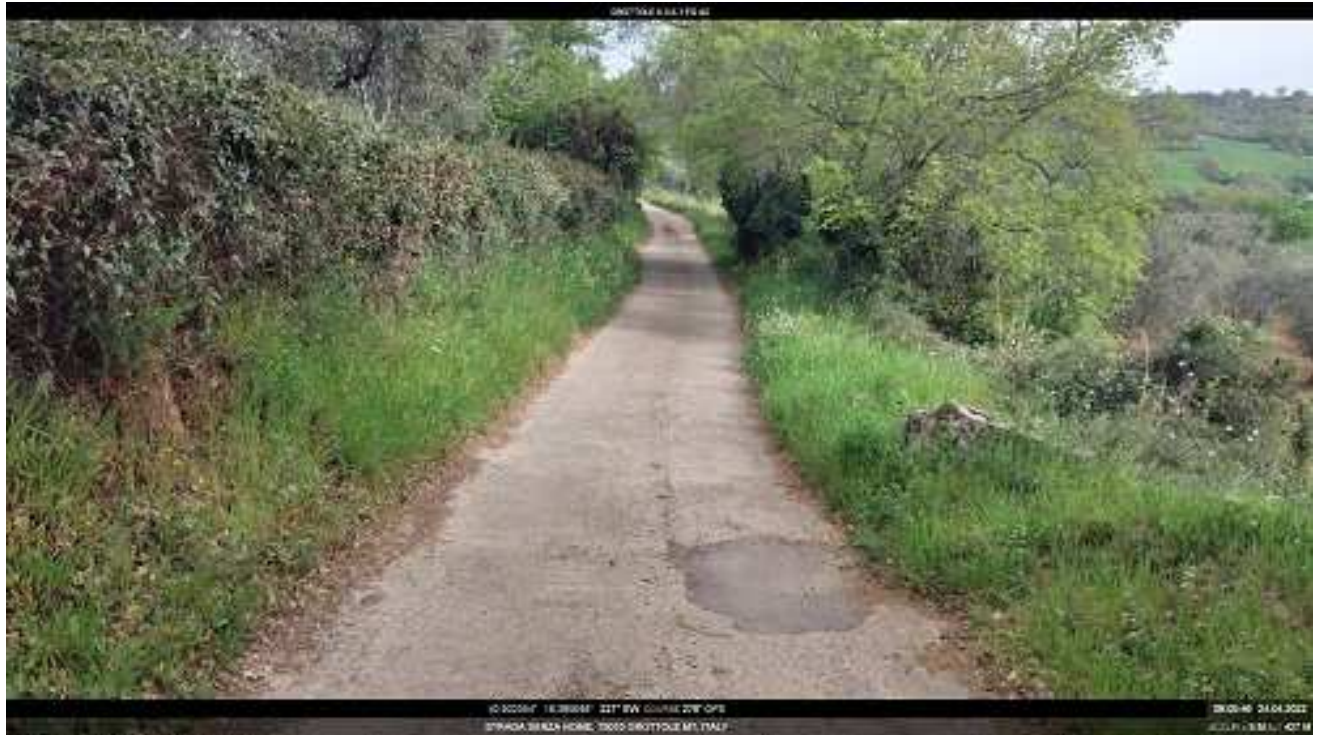
Intervento 6.3.6.1 Grottole Fg.40 Strada Comunale Vignale
