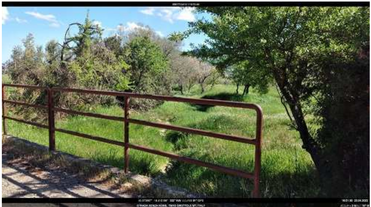
INTERVENTO 6.1.10 Grottole F.60 Canale 10 Ischia Basento
