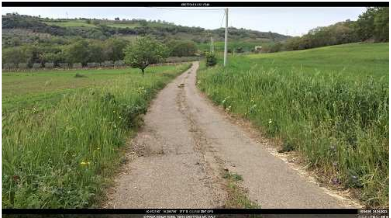
INTERVENTO 6.3.5.1 Grottole F.40 Strada Comunale Pietrarola
