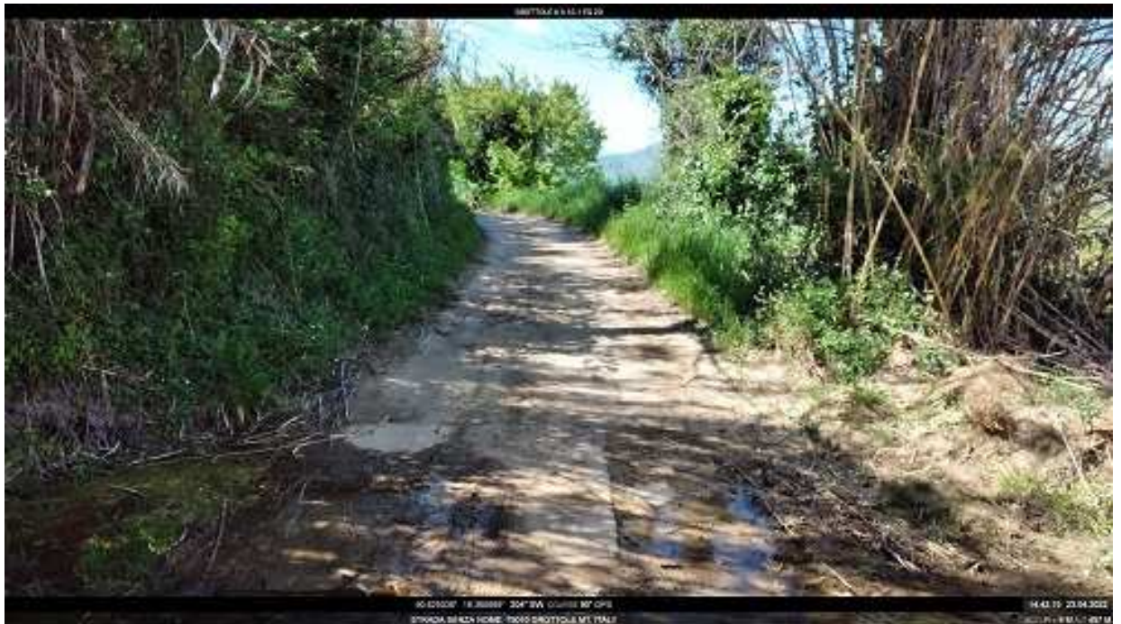
INTERVENTO 6.3.10.1 Grottole Fg.20-31 Starda Comunale Cerreta
