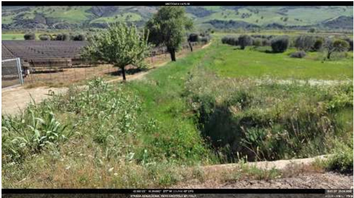
INTERVENTO 6.1.4 Grottole F.58 Canale 4 Ischia Basento
