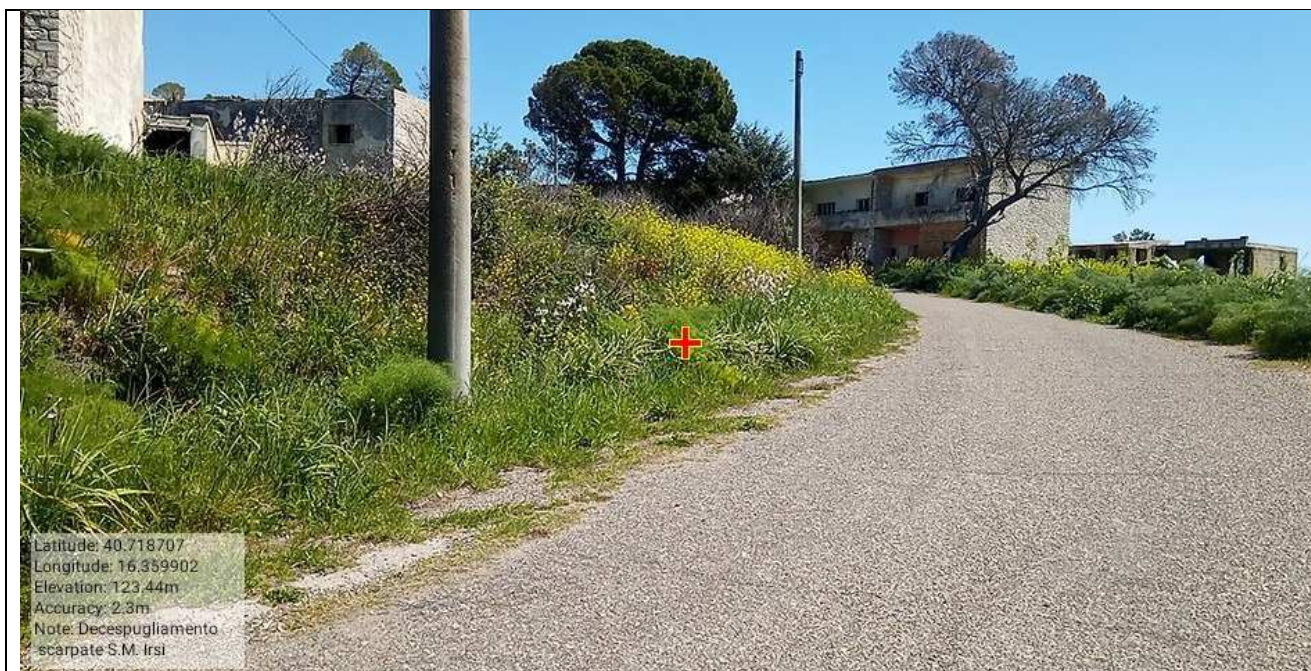
Int. 6.3.12 Manutenzione viabilità. S.C. Santa Maria d'Irsi 2 - Foto N°56
