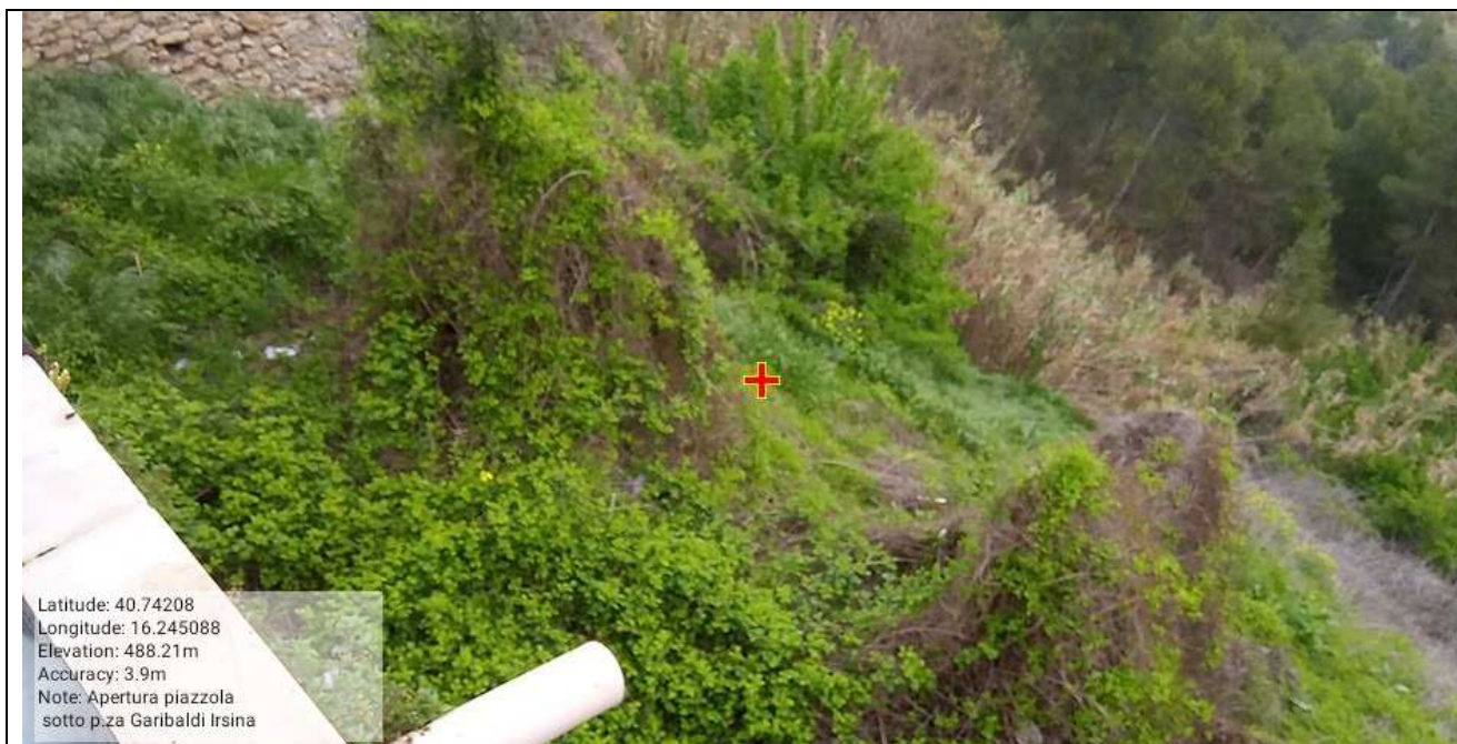
Int. 3.3.1 Apertura piazzola per messa a dimora piante. Zona sotto piazza Garibaldi Irsina - Foto N°13
