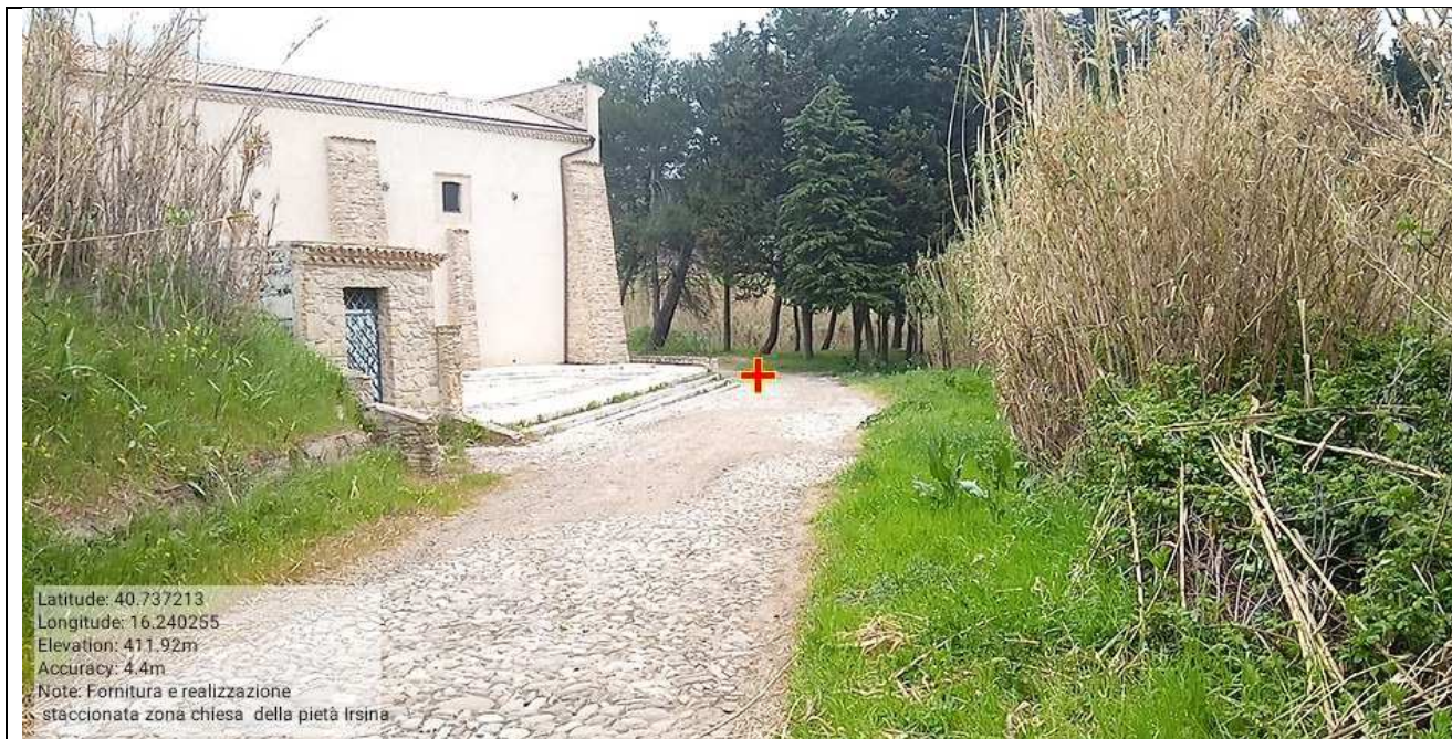
Int. 6.4.2 Realizzazione staccionata a croce di Sant'Andrea presso zona chiesa della Pietà - Foto N°61
