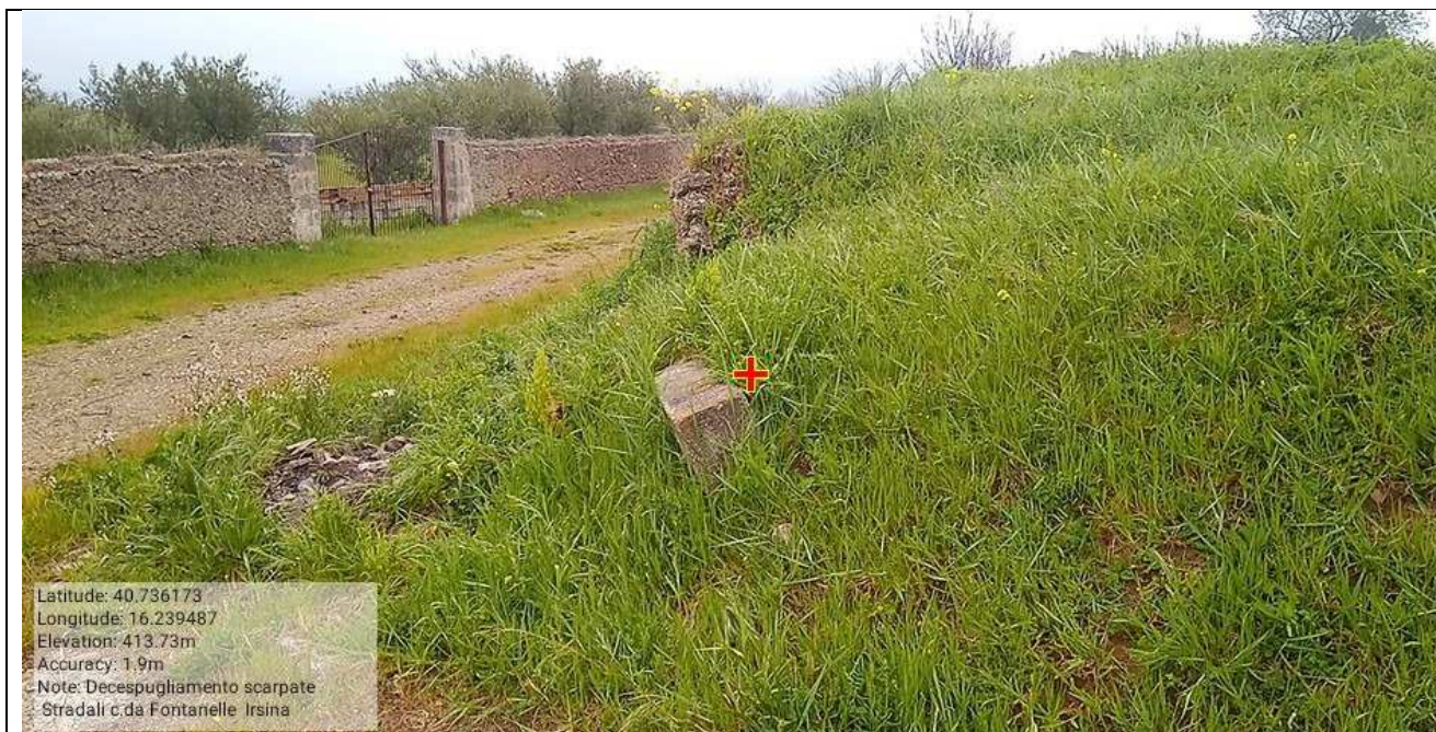
Int. 6.3.3 Manutenzione viabilità. Contrada fontanelle - Foto N° 47
