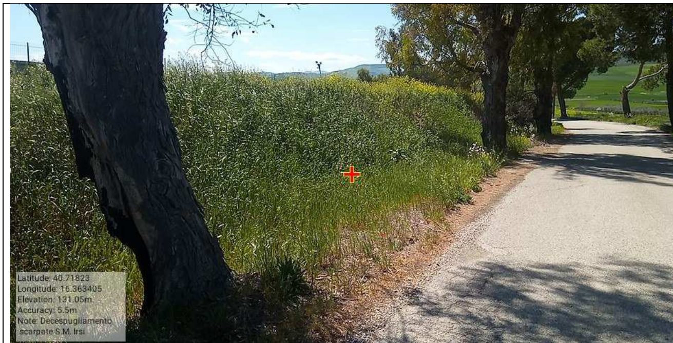
Int. 6.3.11 Manutenzione viabilità. S.C. Santa Maria d'Irsi 1 - Foto N°55
