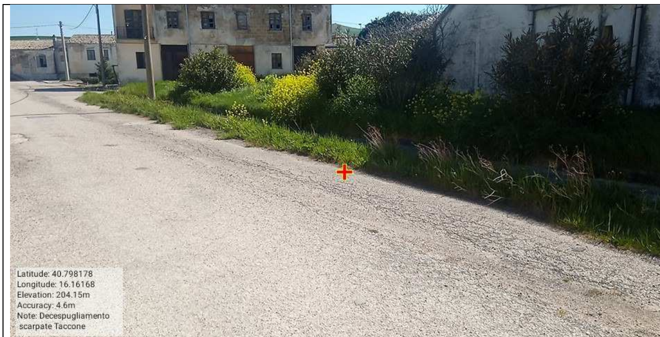
Int. 6.3.10 Manutenzione viabilità. S.C. Borgo Taccone - Foto N°54
