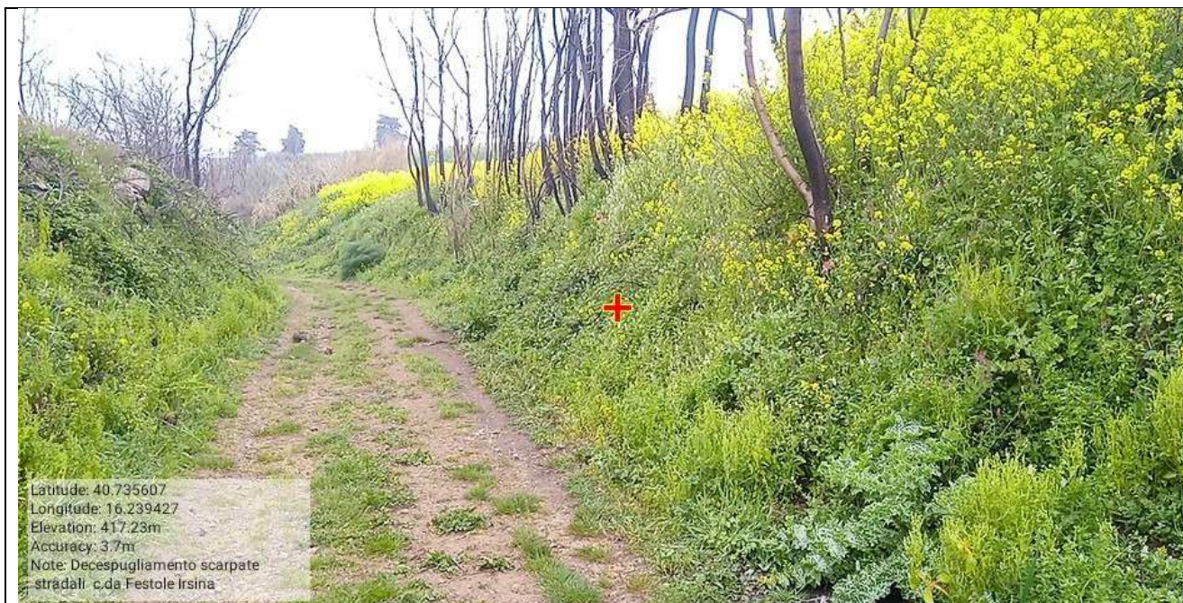
Int. 6.3.7 Manutenzione viabilità. S.C. Festole Irsina - Foto N°51
