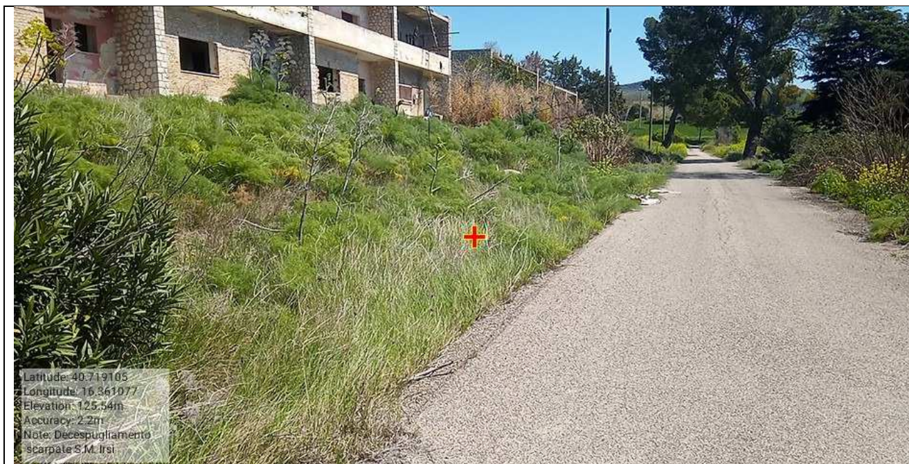
Int. 6.3.13 Manutenzione viabilità. S.C. Santa Maria d'Irsi 3 - Foto N°57
