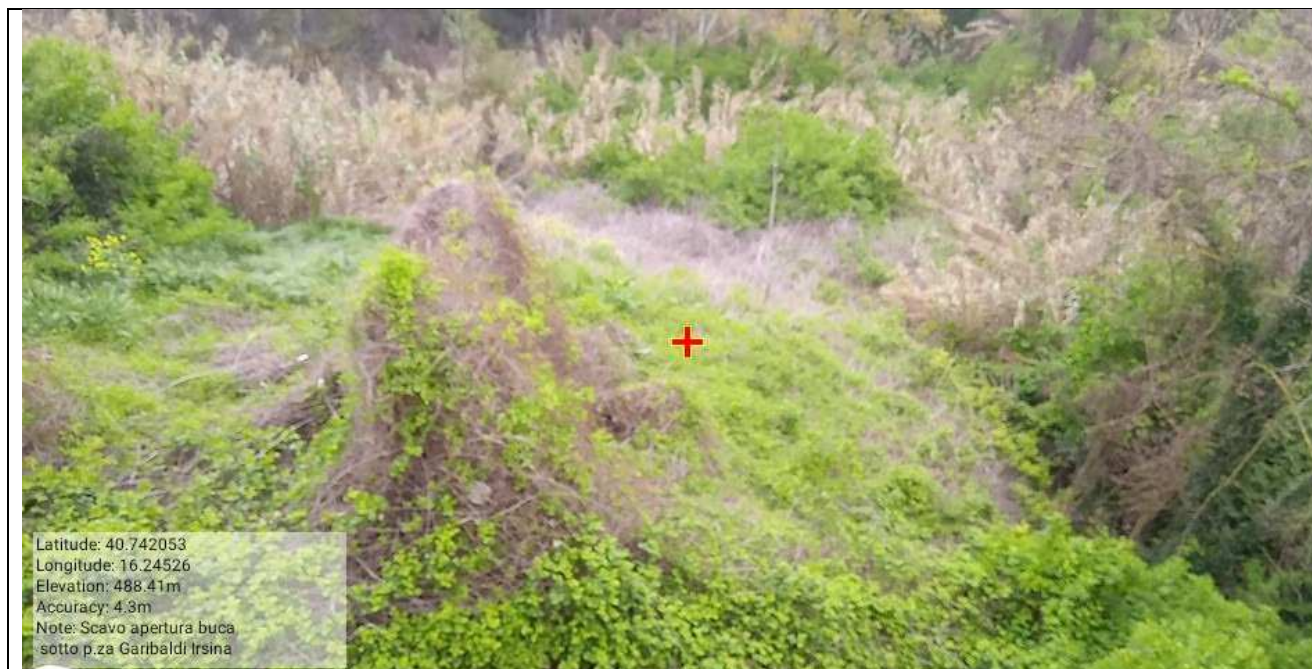
Int. 3.4.1 Scavo per apertura di buca per la messa a dimora pianta. Zona sotto p.za Garibaldi - Foto N°15
