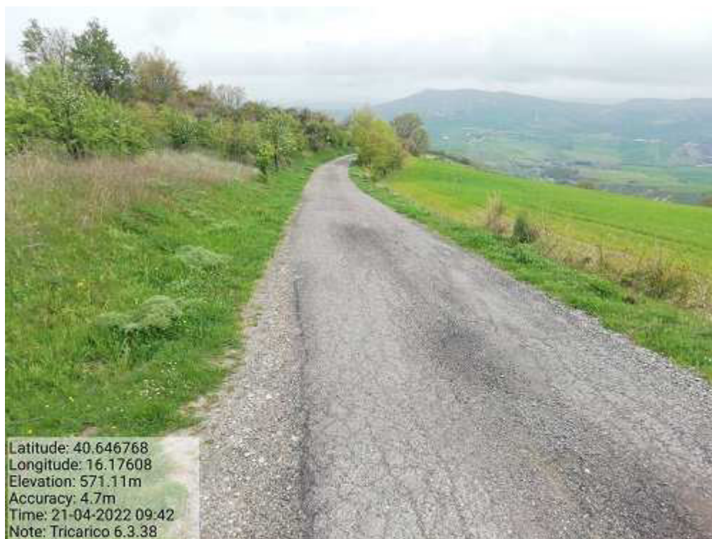
INTERVENTO 6.3.38 - TRICARICO Fg.38 Part.143 e Strade - Strada Comunale Pantano di Volpe Foto n.65
