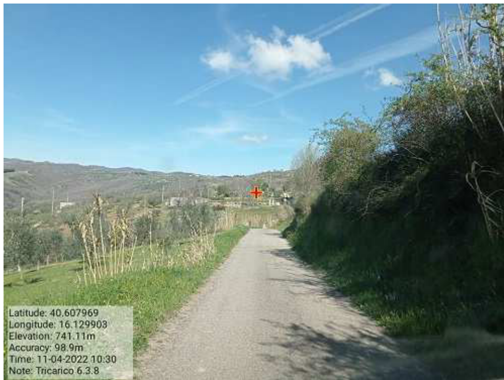
INTERVENTO 6.3.8.- TRICARICO STRADA COMUNALE MALCANALE 6 FG. 64
