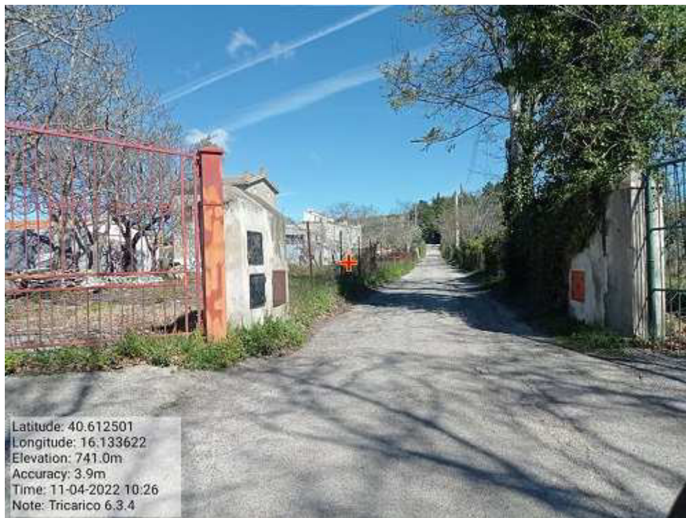
INTERVENTO 6.3.4.- TRICARICO STRADA COMUNALE MALCANALE 2 FG. 64
