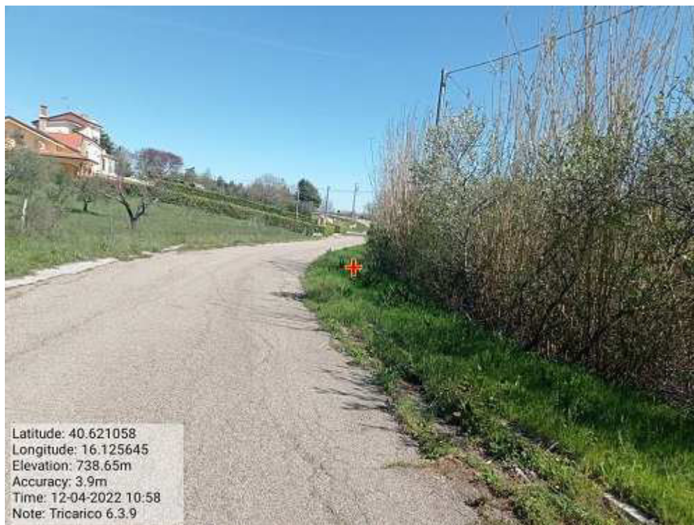
INTERVENTO 6.3.9 - TRICARICO STRADA COMUNALE SALUMICIFIO FG 59
