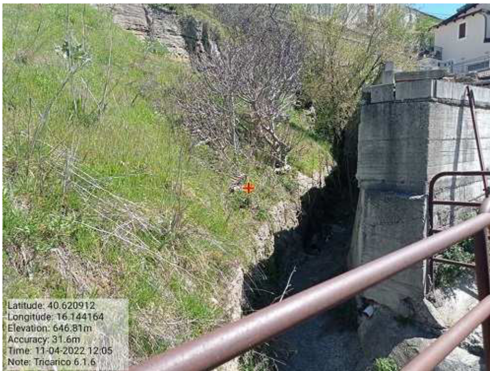
INTERVENTO 6.1.6- TRICARICO Fg.47 Part.Acque TORRENTE CACARONE (AFFLUENTE) Foto n. 38
