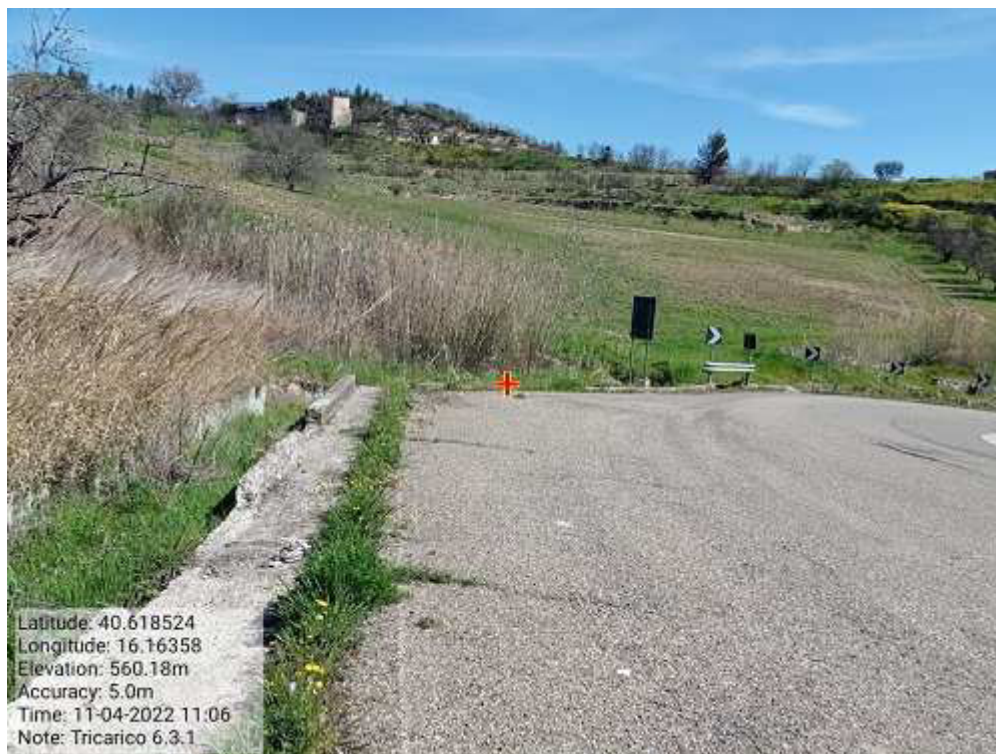
INTERVENTO 6.3.1 - TRICARICO COLLEGAMENTO BASENTANA IANO DELLE GINESTRE FG. 70/68/66/65 Foto n.43
