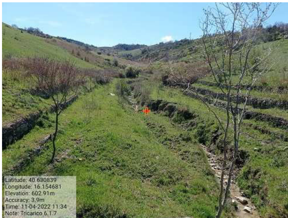
INTERVENTO 6.1.7 - TRICARICO Fg. 61 PARTE ACQUA VALLONE CASTAGNONE Foto n. 39
