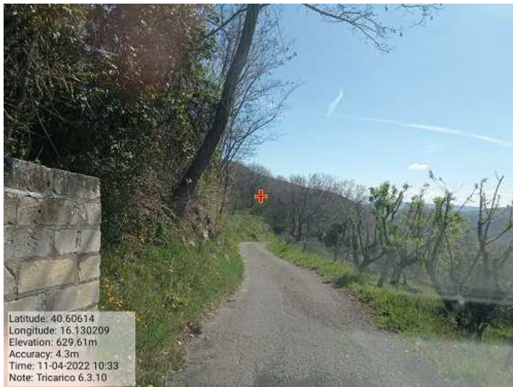
INTERVENTO 6.3.10.- TRICARICO STRADA COMUNALE MALCANALE 7 FG. 64
