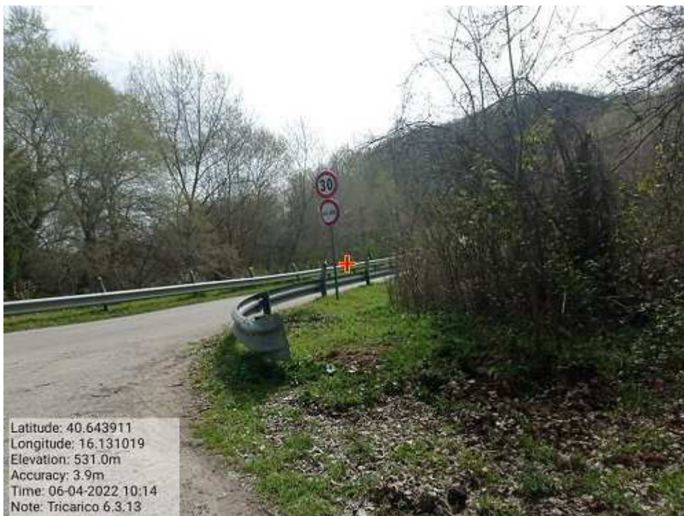
INTERVENTO 6.3.13 - TRICARICO Fg. 46-45-33-34-11-12-4 Strada Comunale Albanello-Cucno della Pica Foto n.
