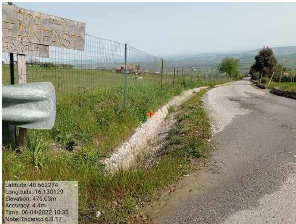
INTERVENTO 6.3.17 - TRICARICO STRADA COMUNALE SAN MARCO 2 FG.12 Foto n. 59
