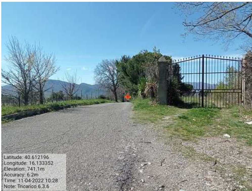
INTERVENTO 6.3.6.- TRICARICO STRADA COMUNALE MALCANALE 5 FG. 64 Foto n. 48
