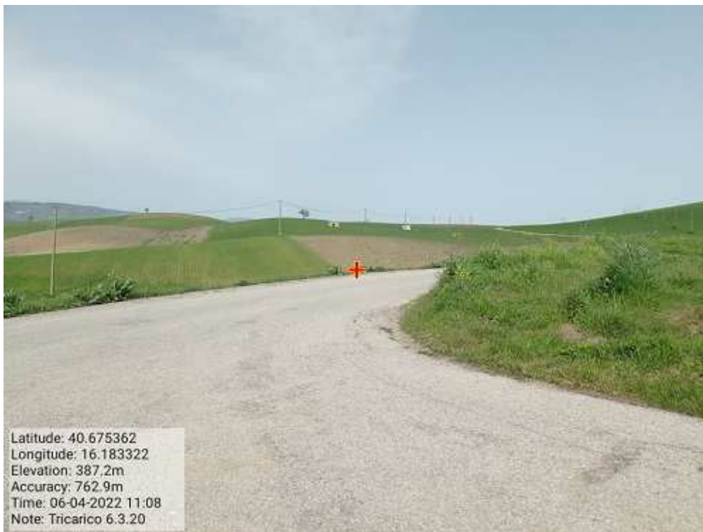
INTERVENTO 6.3.20.- TRICARICO T Fg 15-14-6-10 Strada Comunale Serramendola Bassa Foto n. 62
