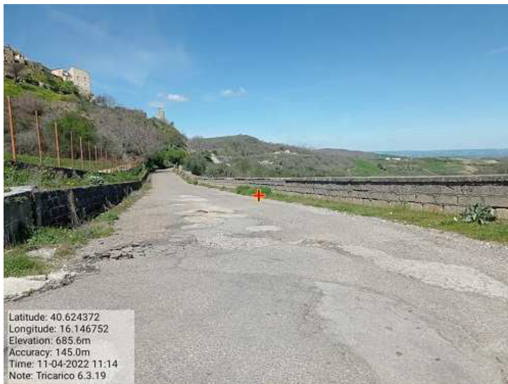
INTERVENTO 6.3.19 - TRICARICO STRADA COMUNALE SARACENA FG. 54/61 Foto n. 61
