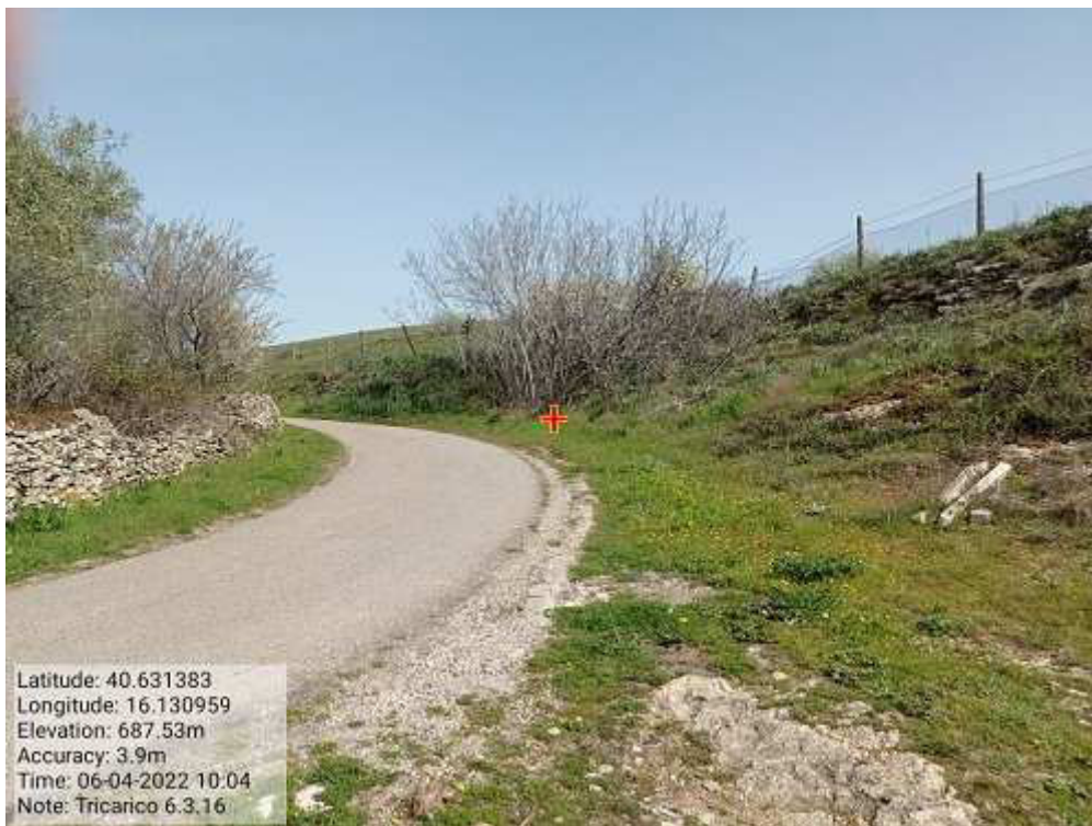
INTERVENTO 6.3.16.- TRICARICO STRADA COMUNALE SANT ANDREA MANCARRONE FG. 53/45 Foto n. 58
