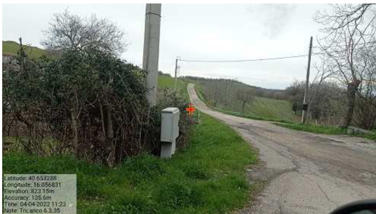
INTERVENTO 6.3.35 - TRICARICO STRADA COMUNALE TRIONTE FG19-19-20-31-32-42 Foto n.63
