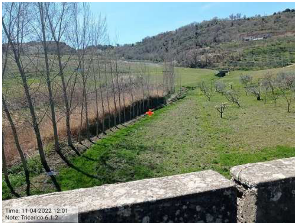
INTERVENTO 6.1.2- TRICARICO Fglio 65 part. Acque TORRENTE CACARONE TRATTO 2° Foto n. 34
