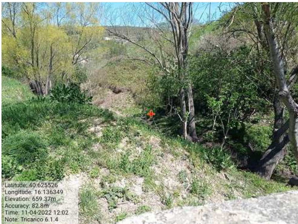
INTERVENTO 6.1.4- TRICARICO Fg.47 Part.Acque TORRENTE CACARONE TRATTO 3
