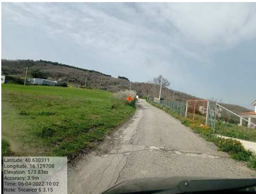
INTERVENTO 6.3.15 - TRICARICO STRADA COMUNALE SANT ANDREA 2 FG. 53/54 Foto n. 57
