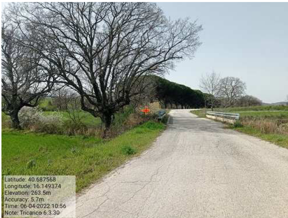
INTERVENTO 6.3.30.- TRICARICO STRADA COMUNALE SERRAMENTOLA ALTA FG5-8 Foto n. 58
