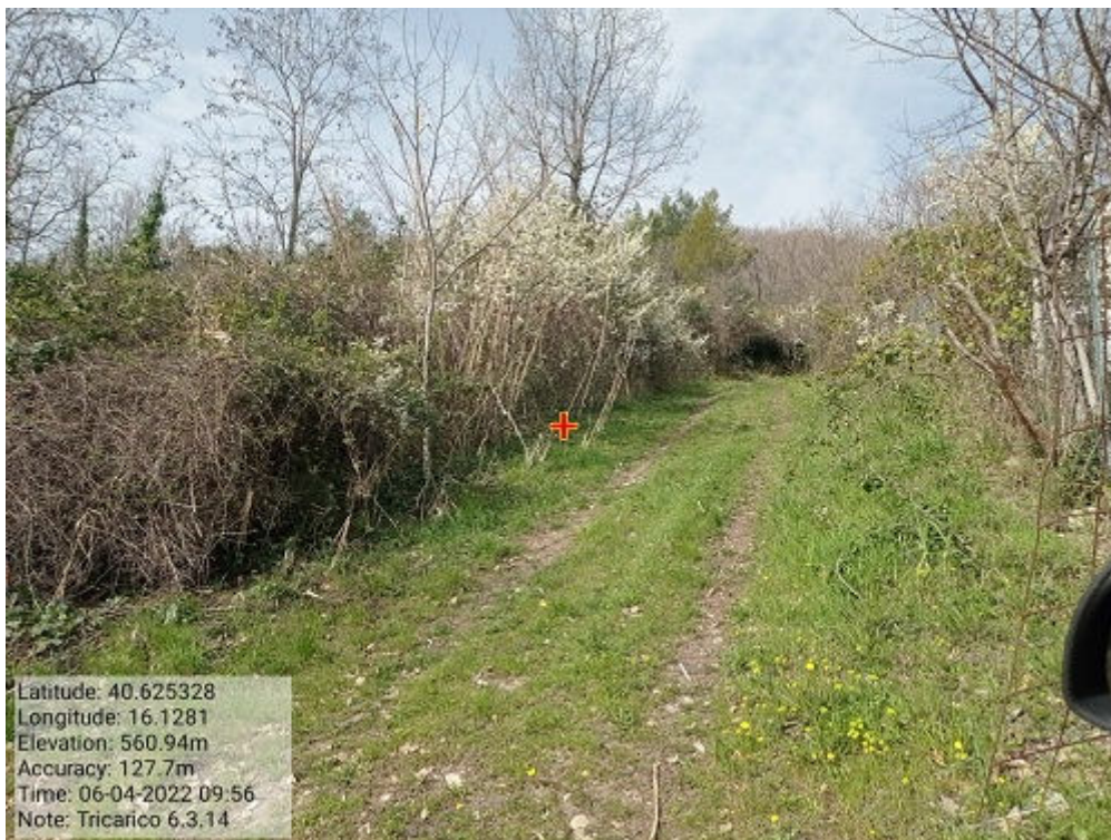
INTERVENTO 6.3.14.- TRICARICO STRADA COMUNALE SANT ANDREA 1 FG. 54/60 Foto n. 56
