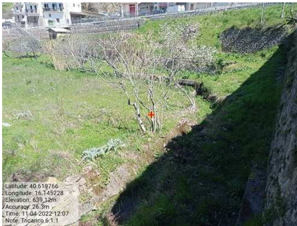
INTERVENTO 6.1.1 - TRICARICO VALLONE CACARONE fg.6 1° TRATTO Foto n. 33
