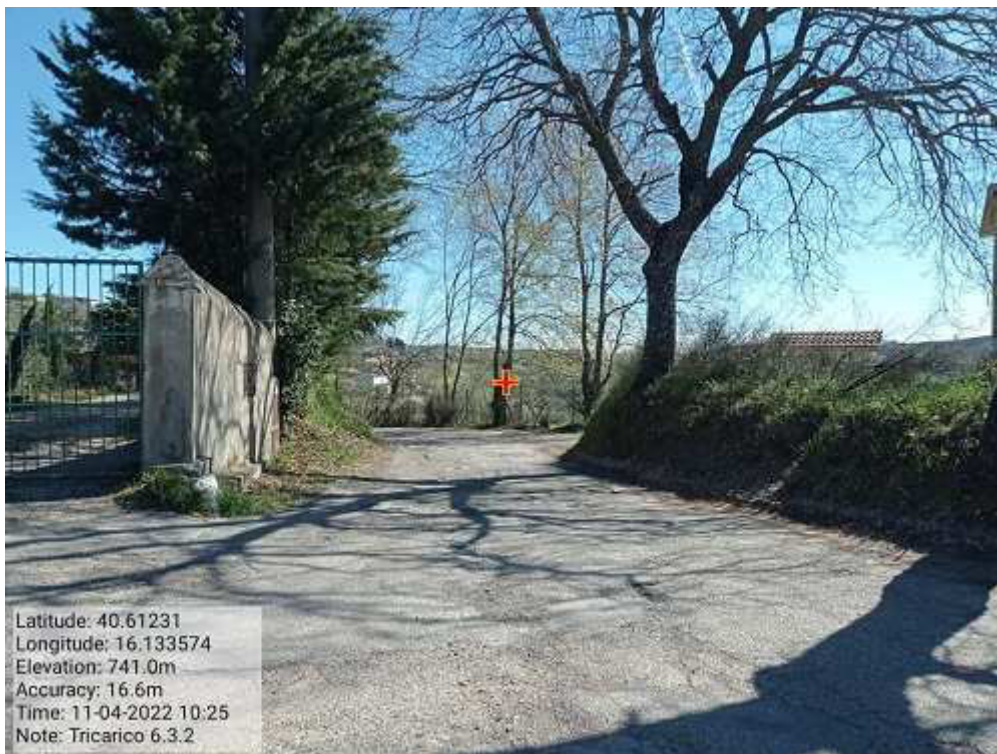
INTERVENTO 6.3.2.- TRICARICO STRADA COMUNALE MALCANALE 1 FG. 64
