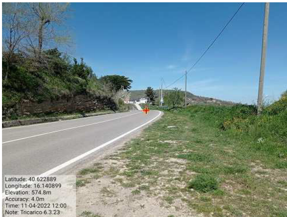
INTERVENTO 6.3.23 - TRICARICO STRADA PROVINCIALE BOCCANERA FG.46-47-35-36-21 1° TRATTO Foto n.65
