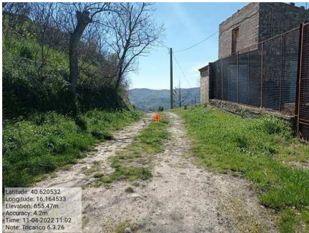
INTERVENTO 6.3.26.- TRICARICO EX COLLEGAMENTO BASENTANA FG.66-67
