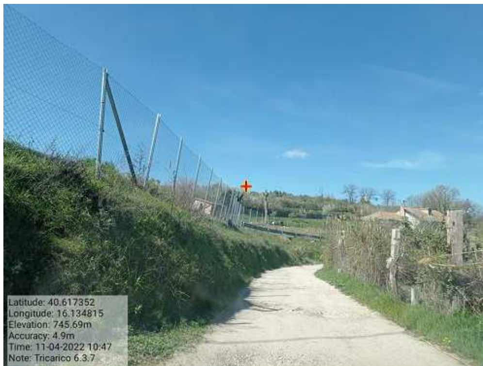
INTERVENTO 6.3.7 - TRICARICO STRADA COMUNALE SAN MARTINO FG. 60 Foto n.49
