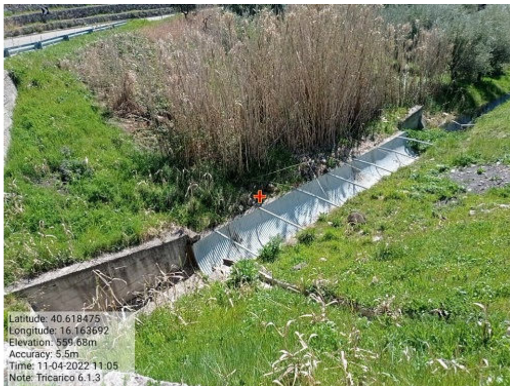
INTERVENTO 6.1.3 - TRICARICO Fg.66 part.97-574-39 CANALE PIANO DELLE GINESTRE Foto n. 35
