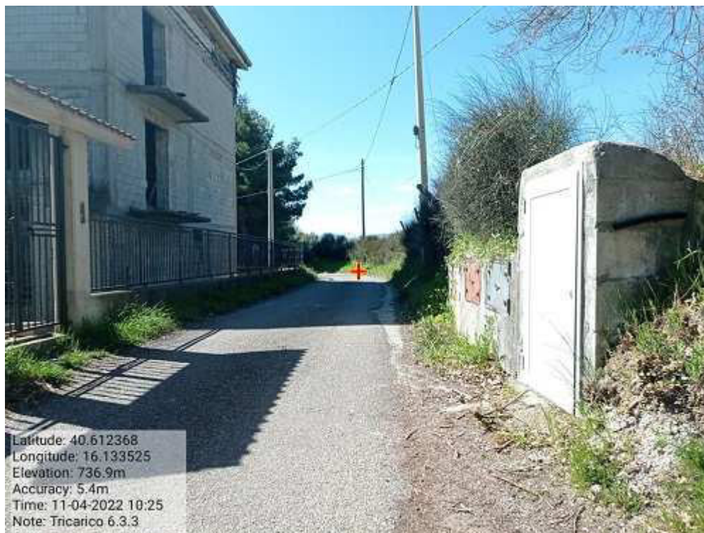
INTERVENTO 6.3.3 - TRICARICO STRADA COMUNALE MALCANALE 3 FG. 64
