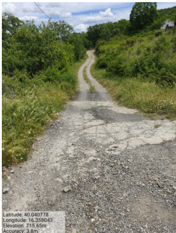
Int. _4.1.1_ Manutenzione Piste Loc. Monaca Foto 1
