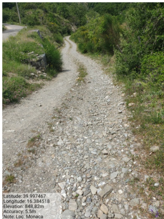
Int. _4.1.1_ Manutenzione Piste Loc. Monaca Foto 2
