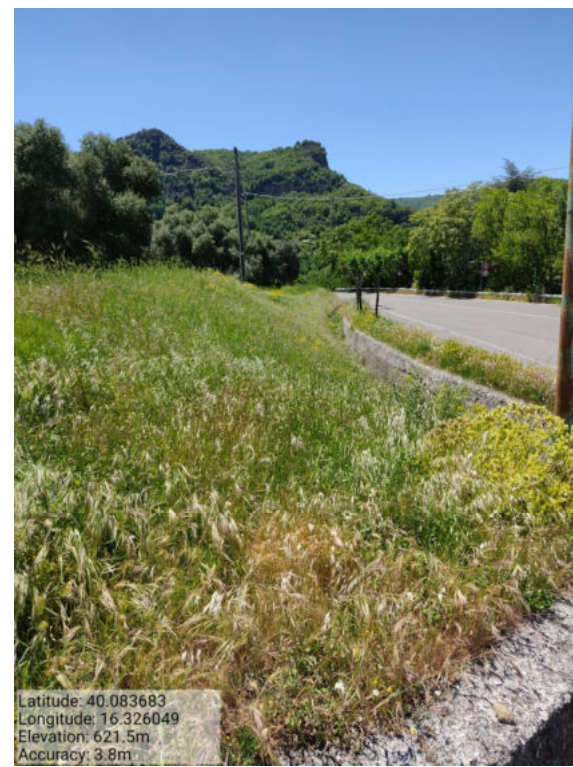
Int. _1.1.4_ Fascie Loc. Cimitero - Foto 1
