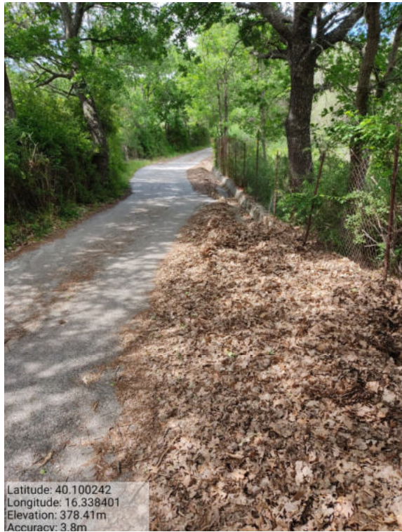
Int. _6.3_Manuten. Strade Loc. Manche Foto 1
