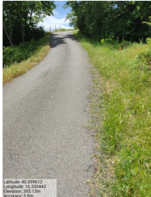
Int. _6.3_Manuten. Strade Loc. Manche Foto 2
