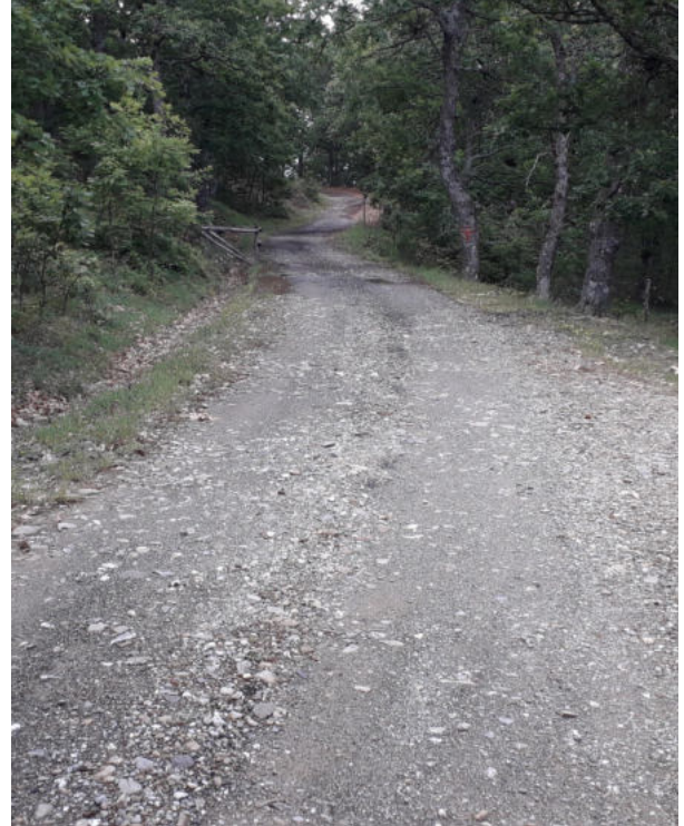
Int. _1.2.1_ Manutenzione Piste Foto 2
