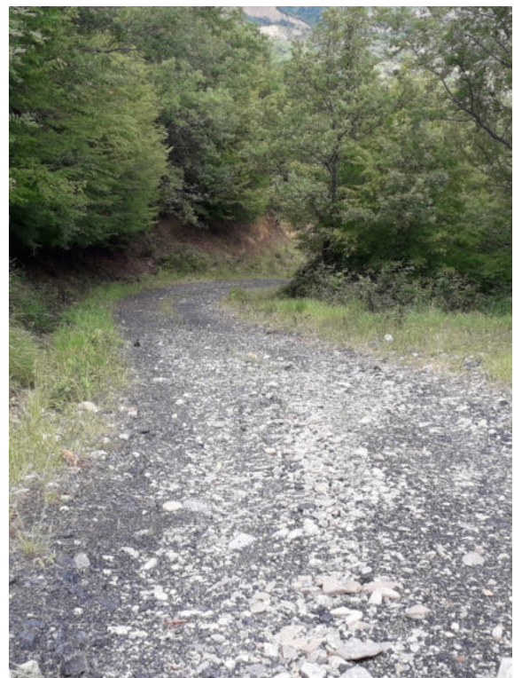
Int. _4.1.1_ Manutenzione Piste Foto 2
