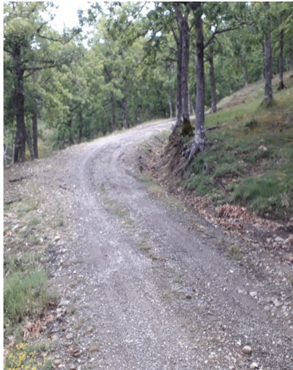
Int. _1.2.1_ Manutenzione Piste Foto 1
