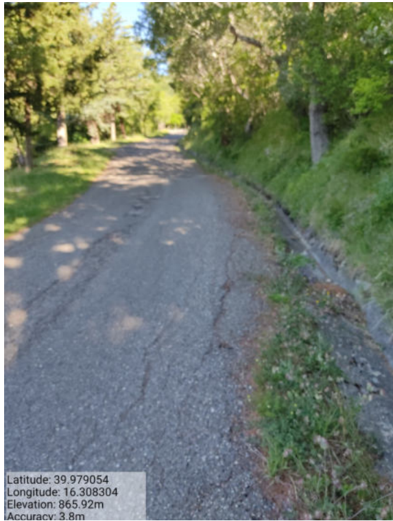
Int. _6.3_Manutenzione Strade Loc. Pietà Foto 1
