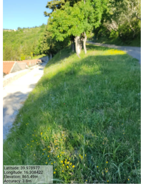
Int. _1.2.2_ Fascie Loc. Cimitero - Foto 1
