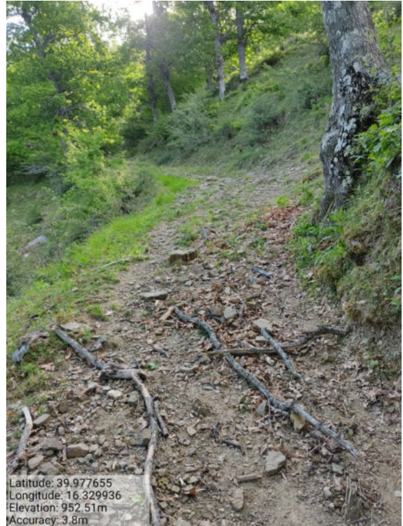
Int. _4.1.3_ Manutenzione Piste Foto 1
