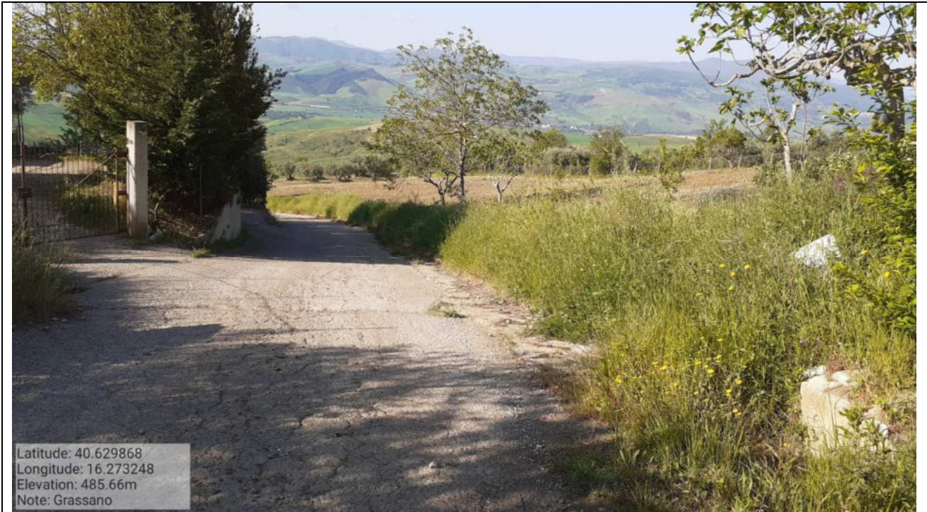
Intervento 6.3.11.1 Grassano F.11 Strada Comunale Gianvincenzo
