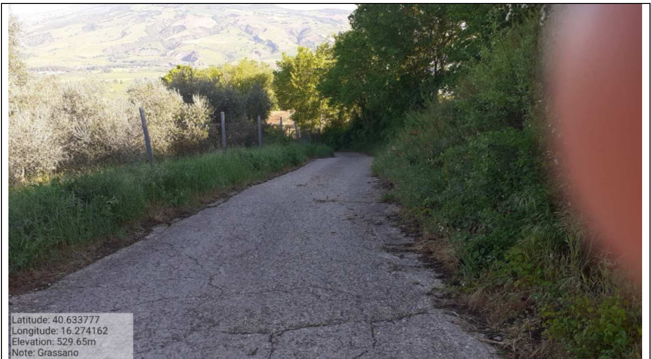
Intervento 4.2.3 Grassano Fg.6 Strada Manche 2
