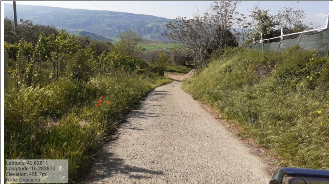
Intervento 6.3.15.1 F.15 Grassano Strada Comunale Marruggio
