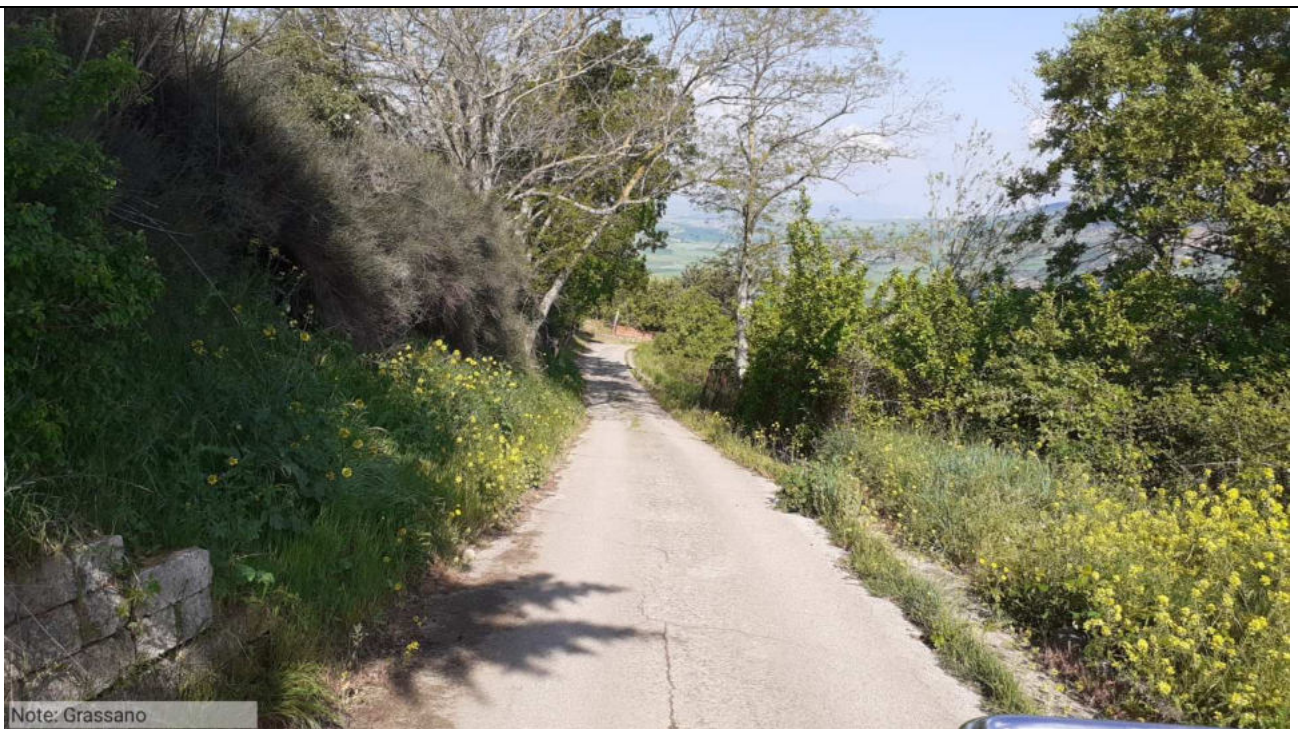
Intervento 6.3.3.1 Grassano F.6 - 3 Strada Com. Manche 1
