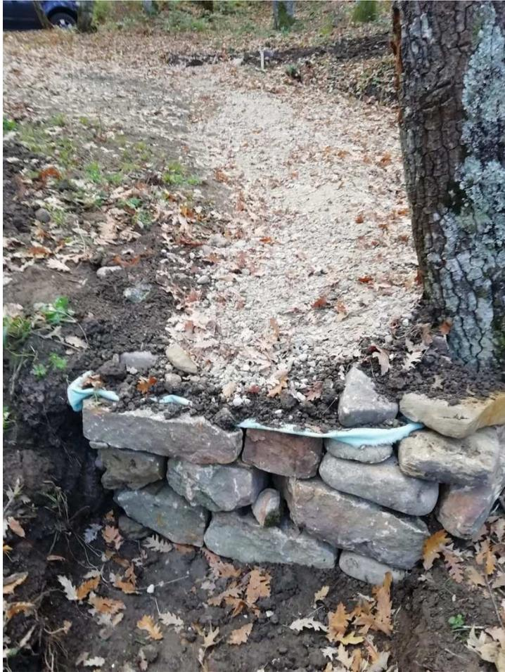
Oltre alla realizzazione delle trincee drenanti, si è proceduto anche alla sistemazione idraulico superficiale, attraverso l'apertura e il ripristino delle cunette per il deflusso delle acque.
