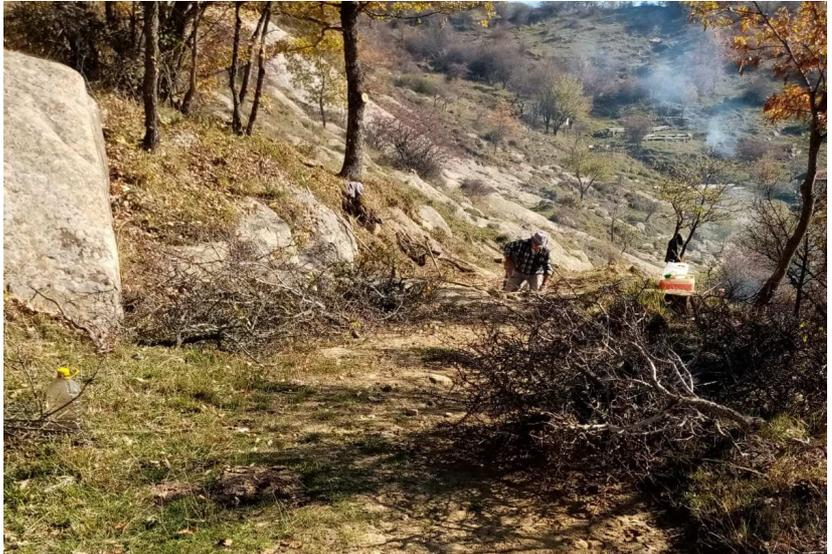
Oltre alla ripulitura della vegetazione, sono stati eseguiti anche interventi di sistemazione del piano di calpestio con materiale pietroso recuperato nella zona d'intervento, e per quanto possibile, interventi di canalizzazione delle acque.
