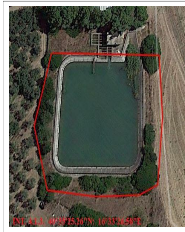
Int. 4.1.3. MANUTENZIONE VASCA CONSORTILE
