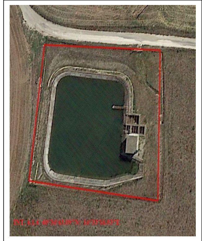
Int. 4.1.4. MANUTENZIONE VASCA CONSORTILE
