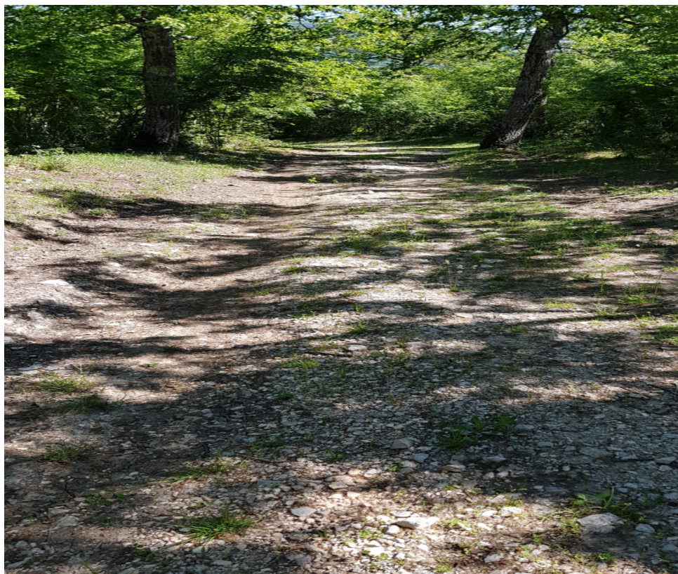
Manutenzione pista di servizio – Loc. Manche
