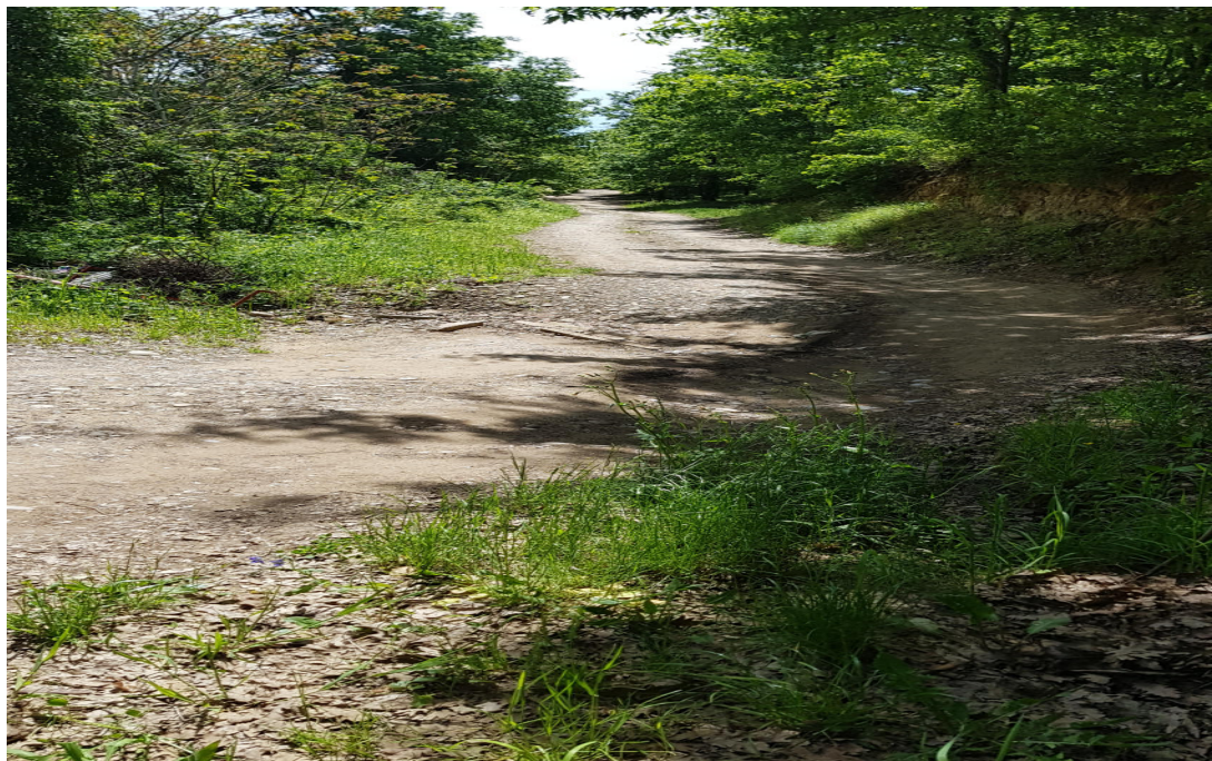
Manutenzione pista forestale – Loc. Macchia
