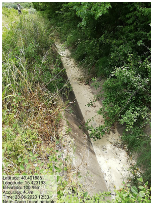
Int.4.1.3 Loc. Fosso Naturale Manutenzione aste fluviali
