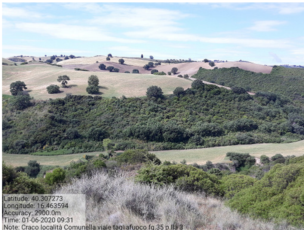
Int.1.2.1 Loc. Comunella fg.35 p.IIa 3 Realizzazione viale tagliafuoco
