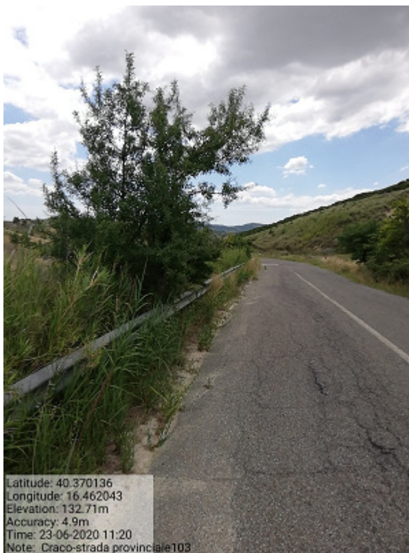
Int.5.1.1 S.P. 103 Craco Peschiera –Craco Manutenzione della viabilità
