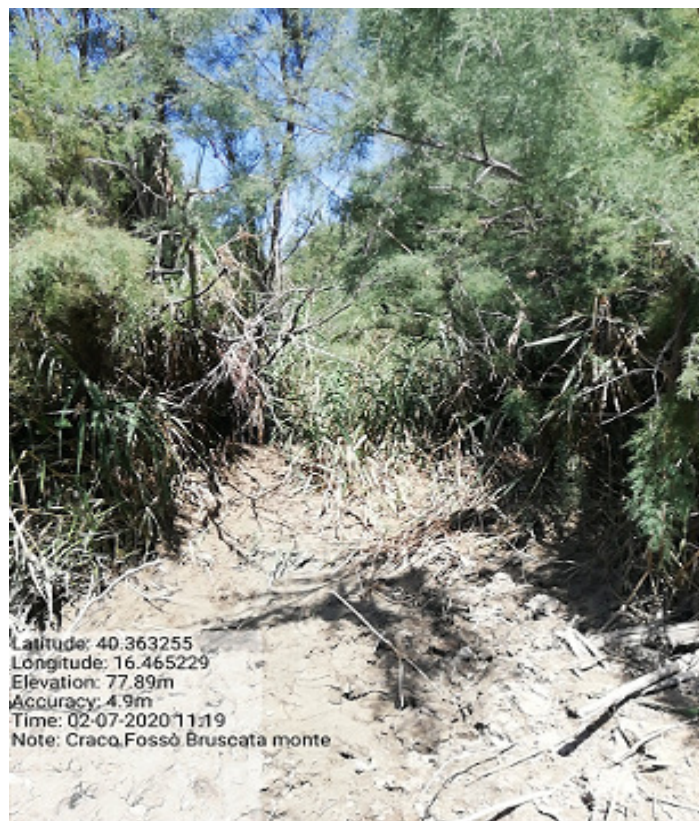
Int.4.1.2 Loc. Fosso Bruscata monte Manutenzione aste fluviali
