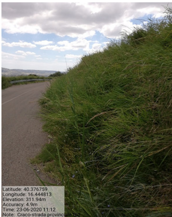
Int.5.2.1 S.P. 103 Craco Peschiera –Craco Manutenzione della viabilità pulizia cunette
