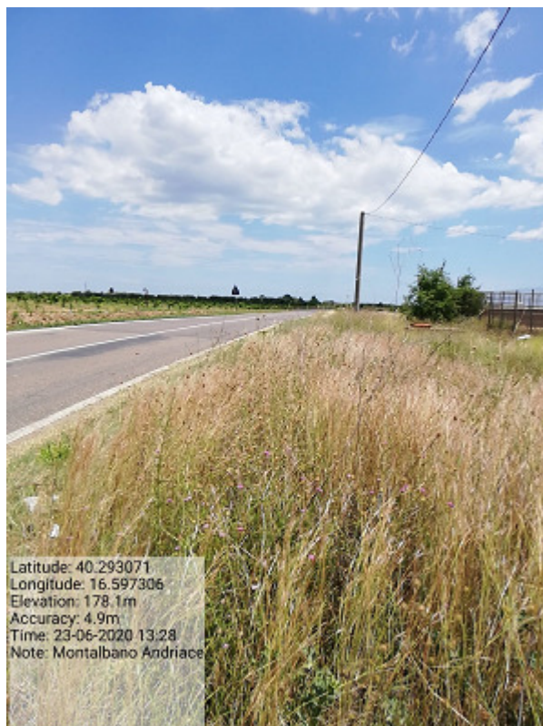
Int.5.1.2 S.P 154 Montalbano –Andriace Manutenzione della viabilità
