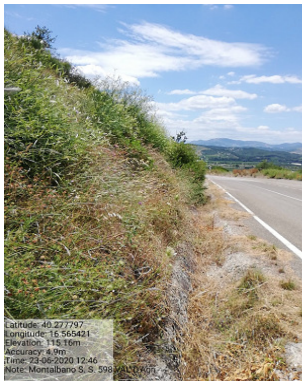
Int.5.1.3 S.P Fratta Montalbano -S.S. 598 Val d'agri Manutenzione della viabilità
