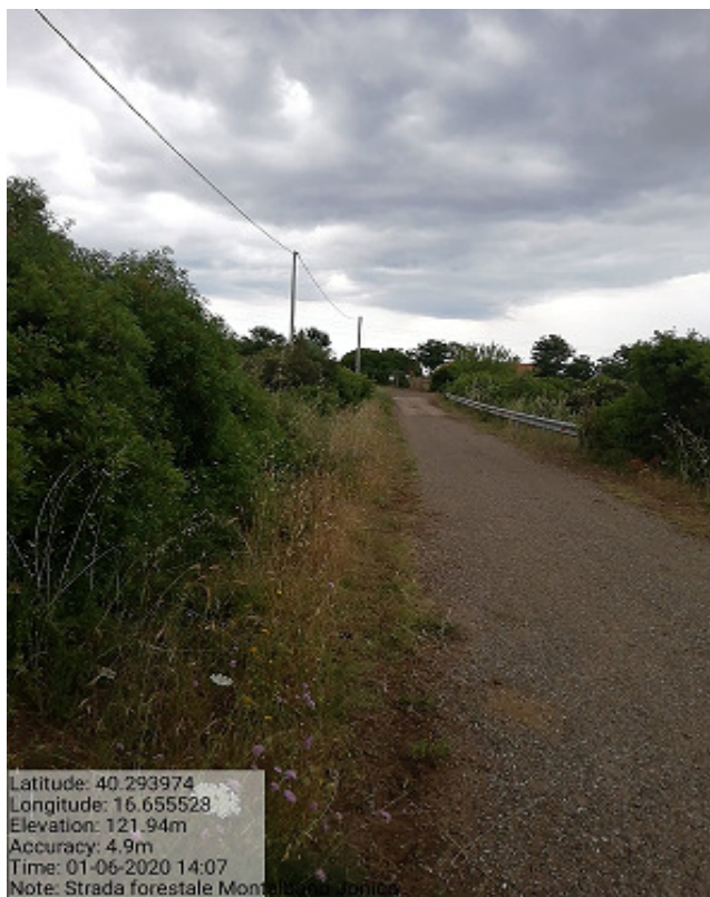
Int.3.2.1 Loc. Bosco Andriace Manutenzione strada forestale
