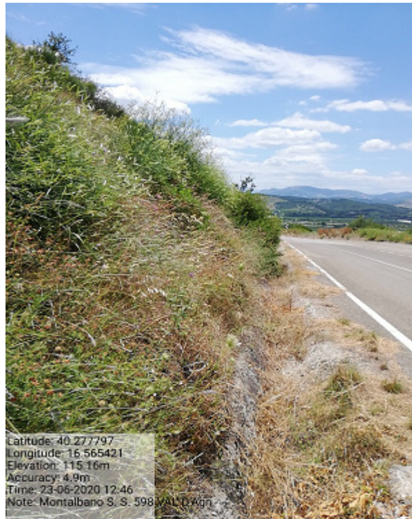
Int.5.2.2 S.P Fratta Montalbano -S.S. 598 Manutenzione della viabilità pulizia cunette
