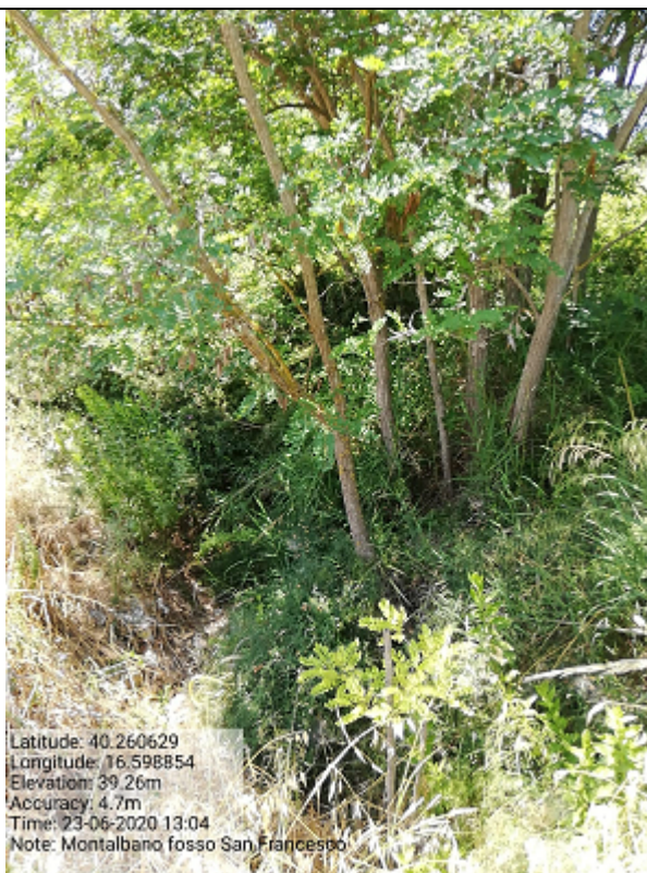
Int.4.1.2 Loc. Fosso San Francesco Manutenzione asta fluviale
