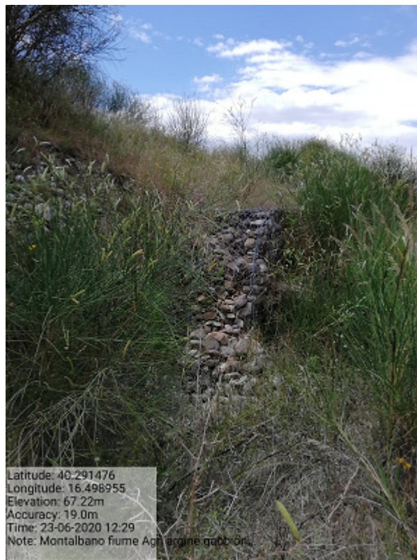
Int.6.1.1-2 Loc. Capolevata Fiume Agri Versante in frana ripristino gabbioni
