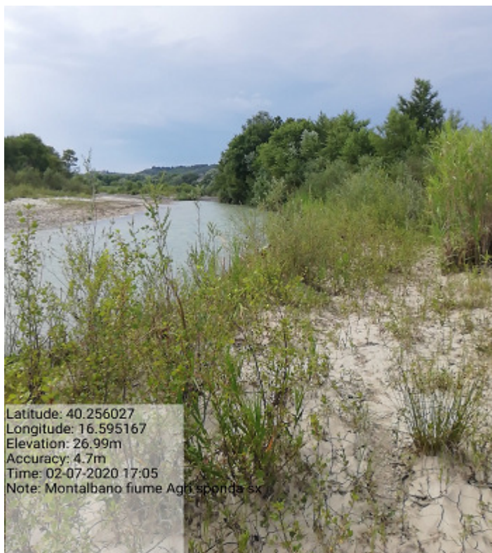
Int.6.3.1 Loc. Argine sx Fiume Agri Versante in frana consolidamento di sponda
