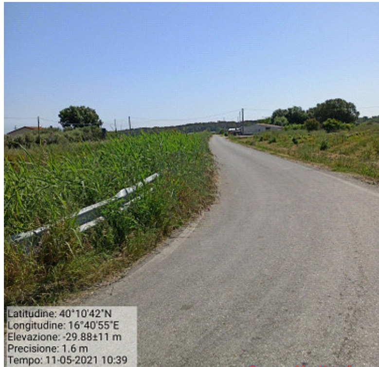
Int.4.1.2 Loc. Canale 2B4 Via Giumenteria Manutenzione aste fluviali
