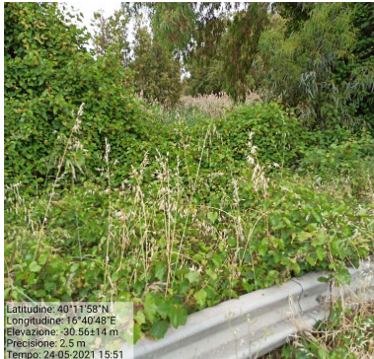
Int.4.1.10 Loc. Canale 7 Manutenzione aste fluviali
