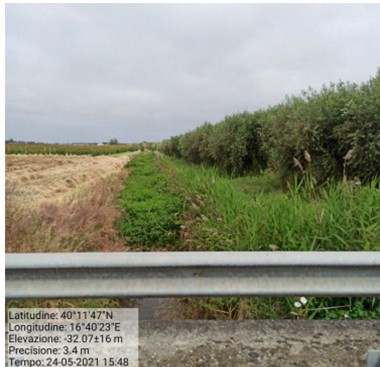
Int.4.1.9 Loc. Canale 3 B16 Manutenzione aste fluviali
