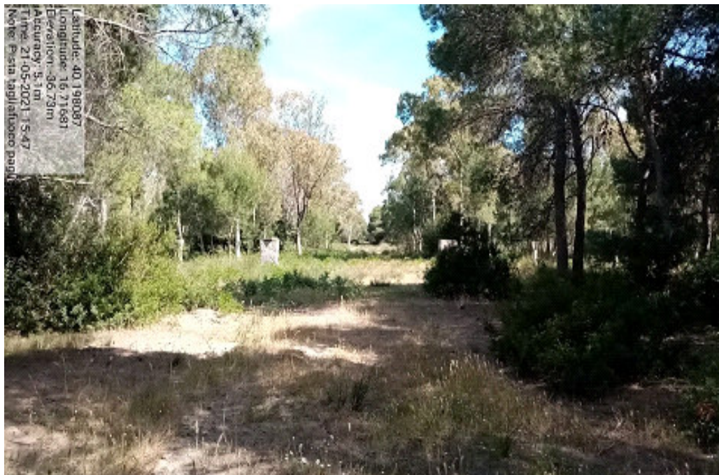
Int.3.1.1 Loc. Paglie di marefg.5 p.lle 104; 123 Manutenzione pista forestale
