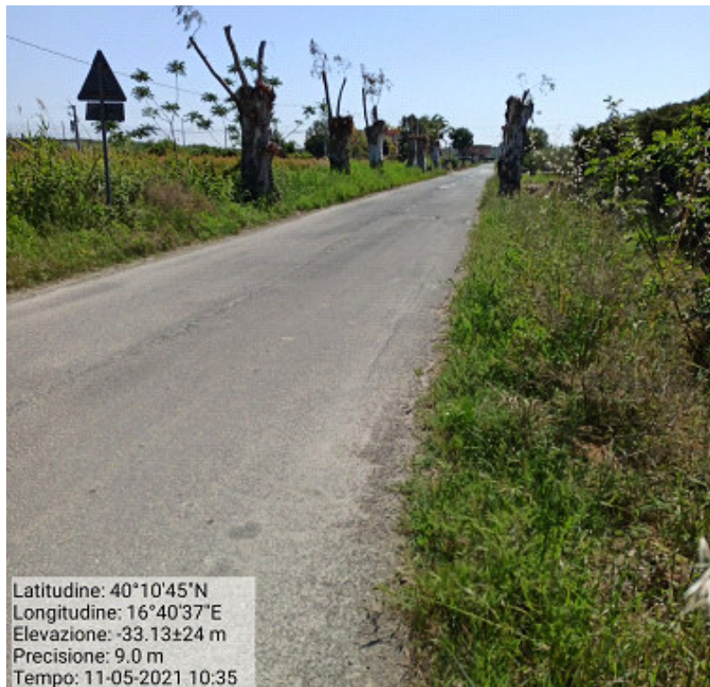
Int.5.1.1 Loc. Viale Mascagni Manutenzione Viabilità Comunale e Provinciale
