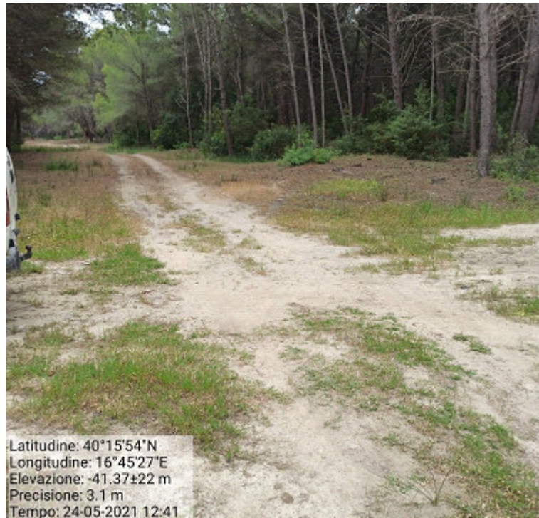
Int.3.2.1 Loc. Terzo Marzoccolo Manutenzione strada forestale
