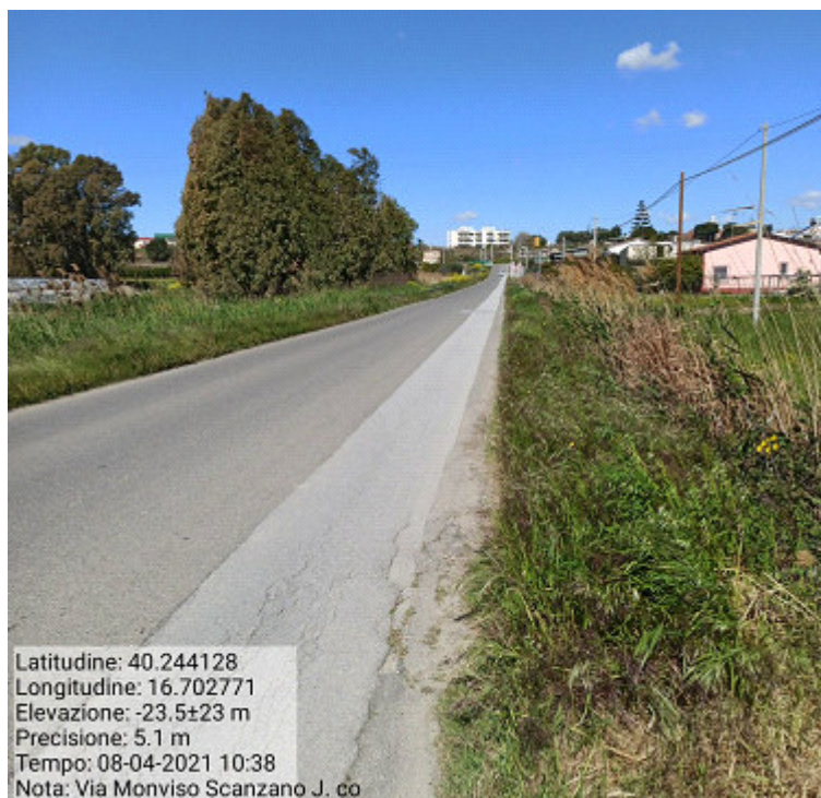
Int.5.1.6 Loc. Via Monviso-mare Manutenzione Viabilità Comunale e Provinciale
