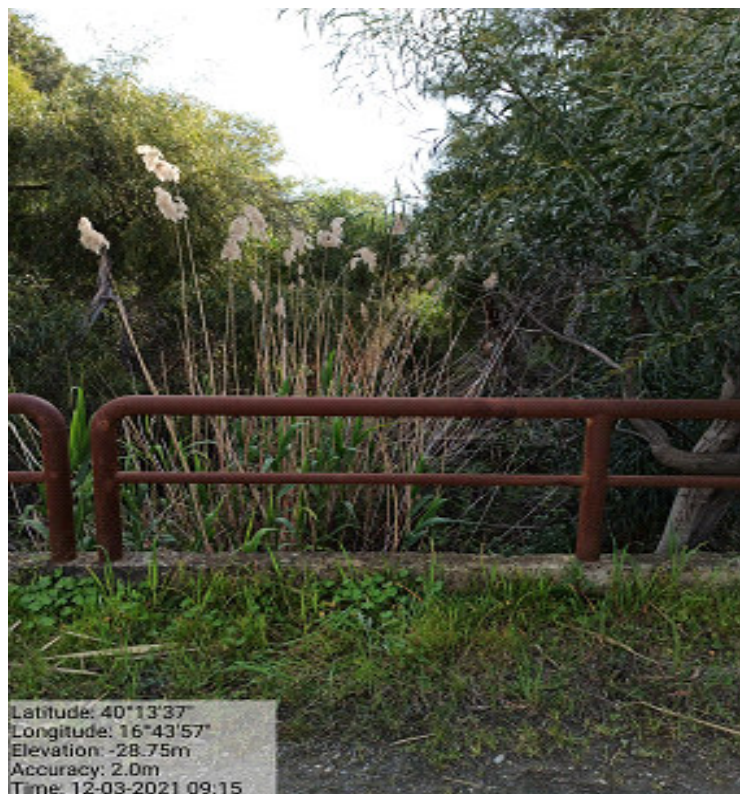
Int.4.1.4 Loc. Canale 13 B2 Manutenzione aste fluviali
