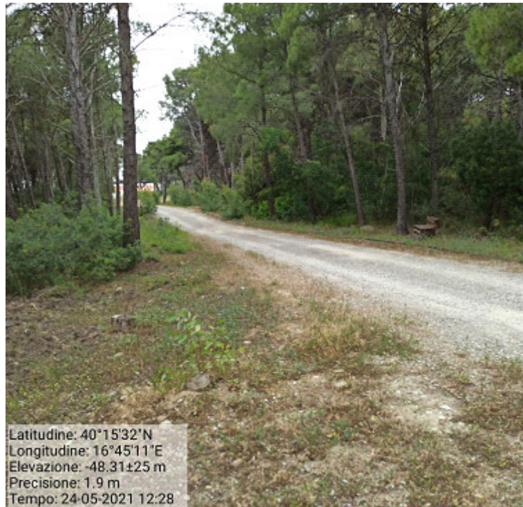
Int.3.2.2 Loc. Terzo Marzoccolo Manutenzione strada forestale
