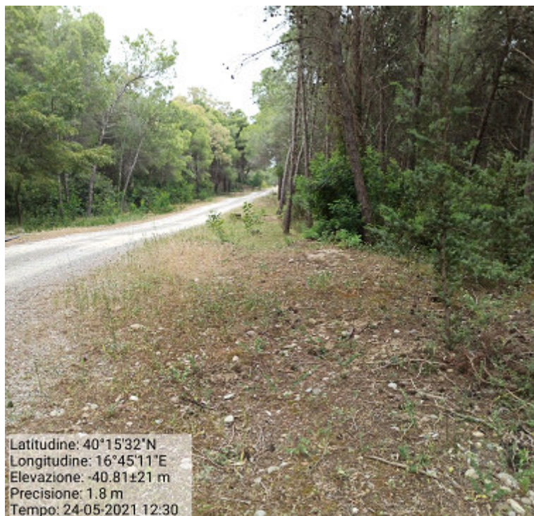
Int.3.2.3 Loc. Terzo Marzoccolo Manutenzione strada forestale
