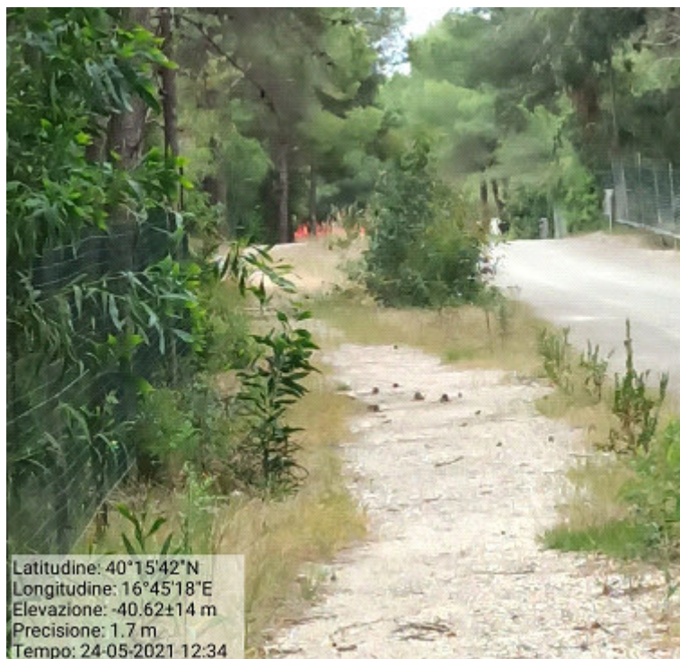
Int.3.2.4 Loc. Terzo Marzoccolo Manutenzione strada forestale
