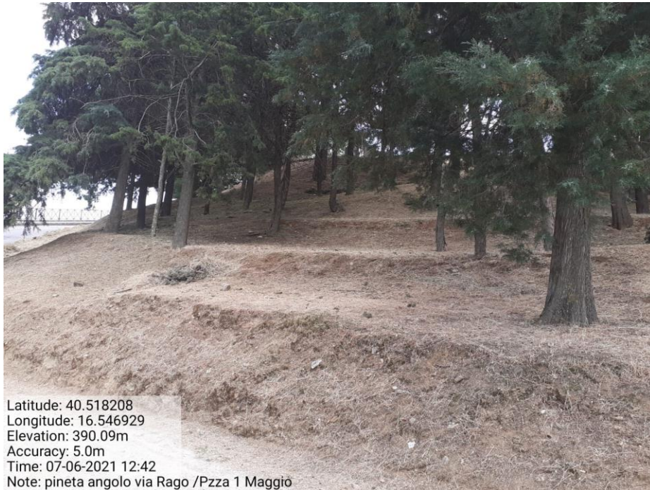
Intervento 2.1.1 Area Urbana Pineta Via Rago angolo Piazza 1° Maggio — POST OPERAM
