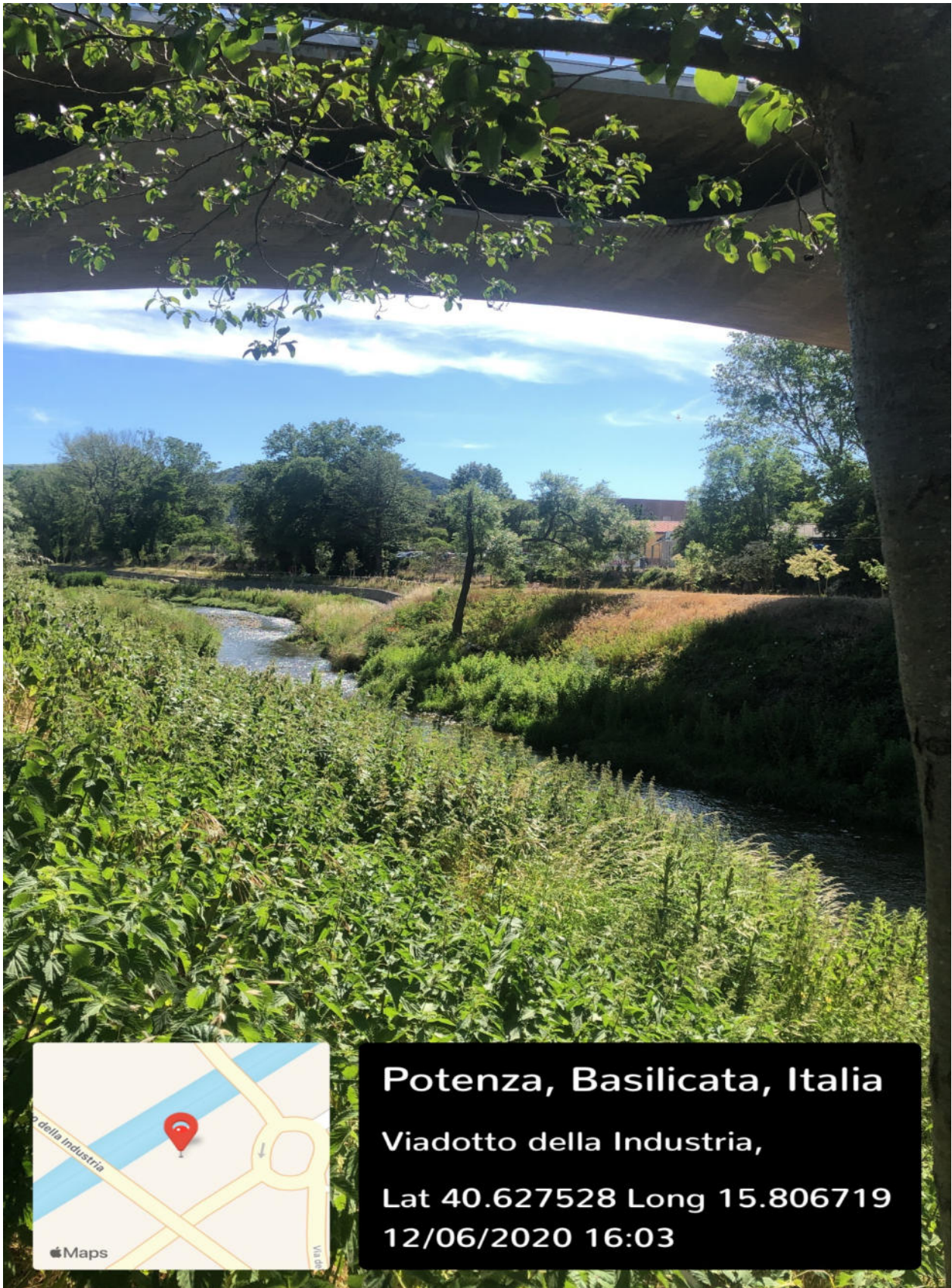
FOTO 5 INT. 4.1.2 Fiume Basento
