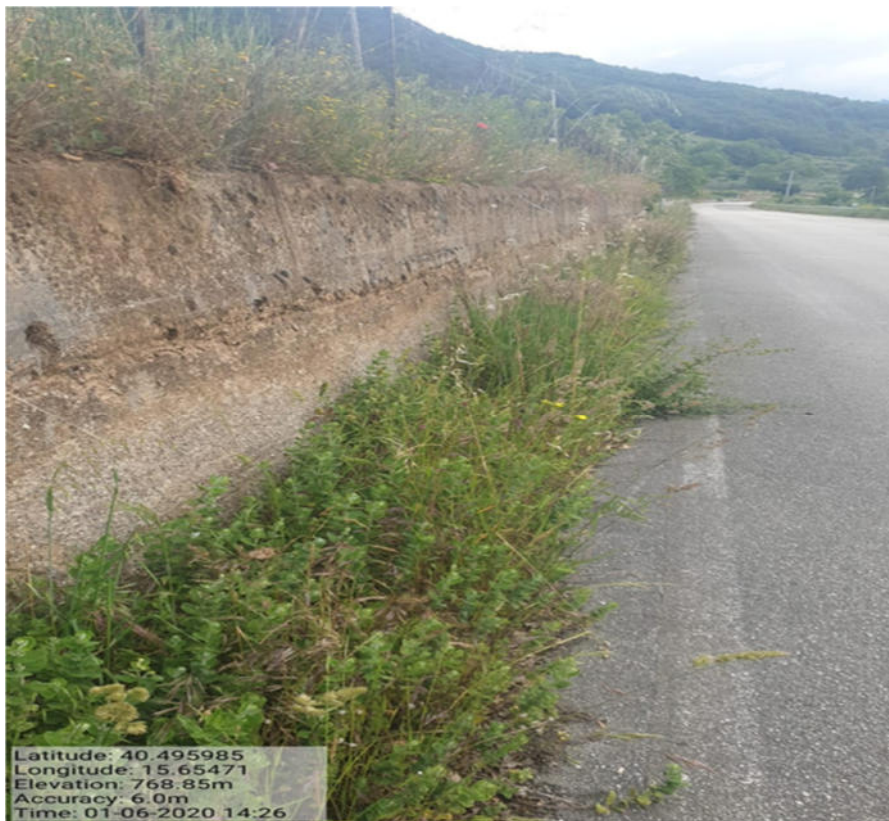
FOTO 7 N. INT. 5.1.1_ Loc. Turri
