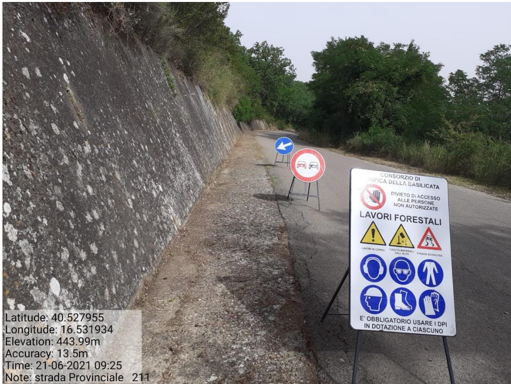
Intervento 5.1.9 Manutenzione Viabilità comunale (Pulizia cunette ) Tronco 23 SP 211 POST OPERAM
