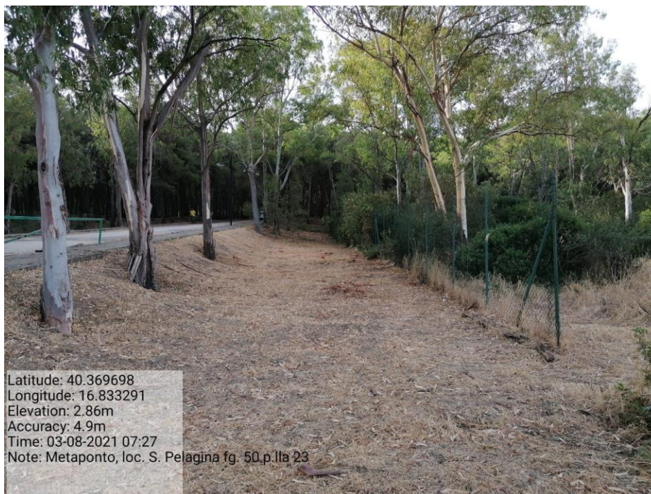
Intervento 1.1.1 Manutenzione Viale Tagliafuoco Loc S.Pelagina Fg 50 P.Ila 23 — POST OPERAM
