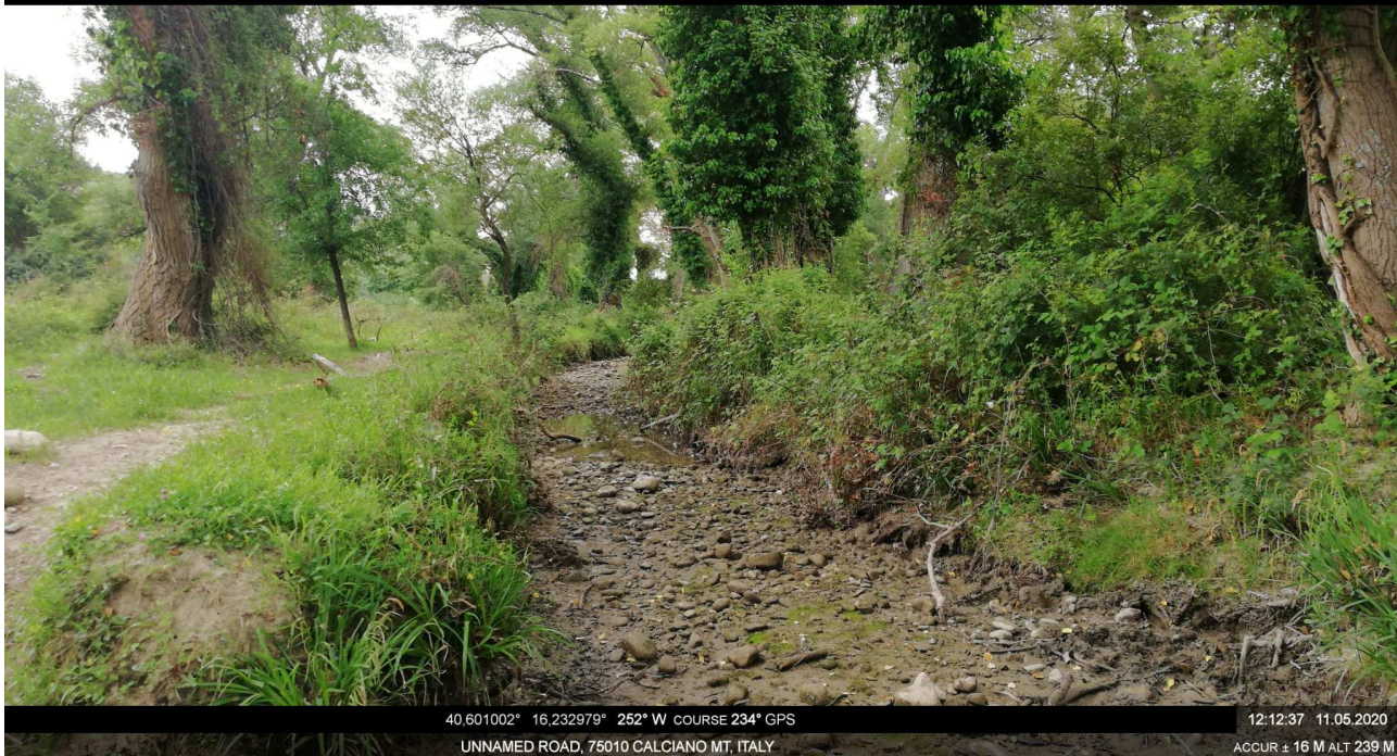
CANALE DI SUPERO IRRIGAZIONE
