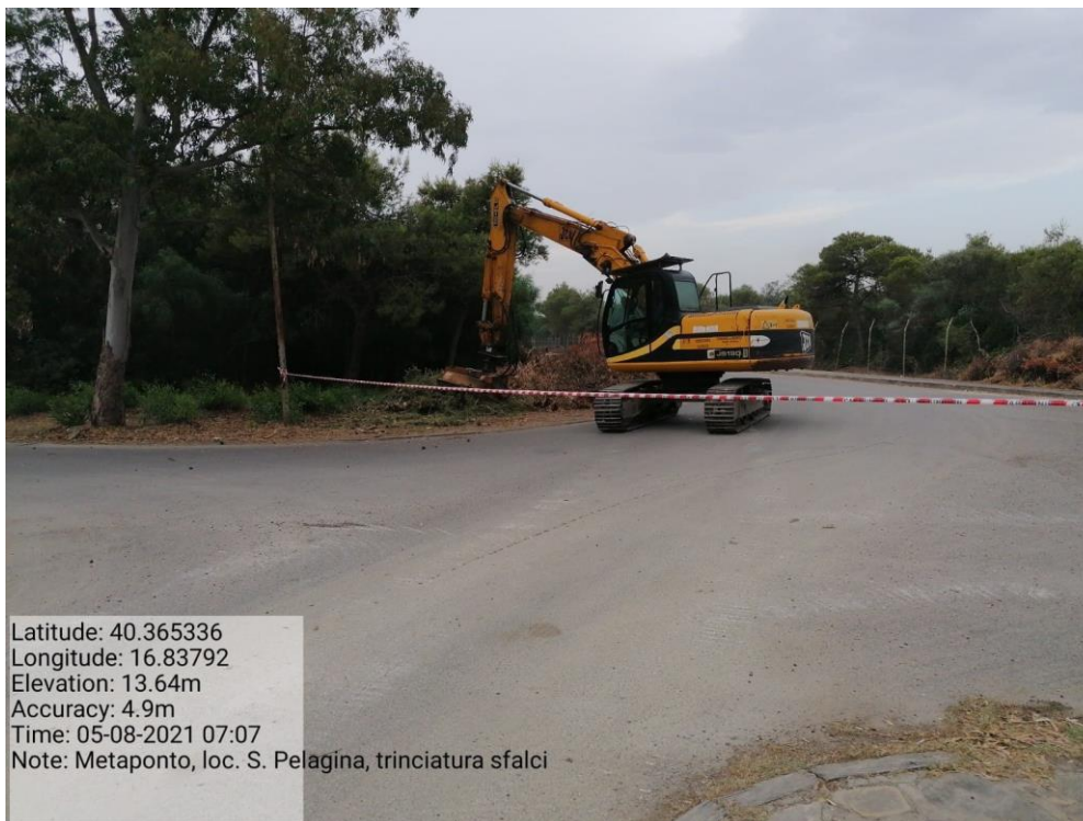
Intervento Triturazione scarti di lavorazione provenienti dalla manutenzione fasce taglia fuoco Loc S.Pelagina
