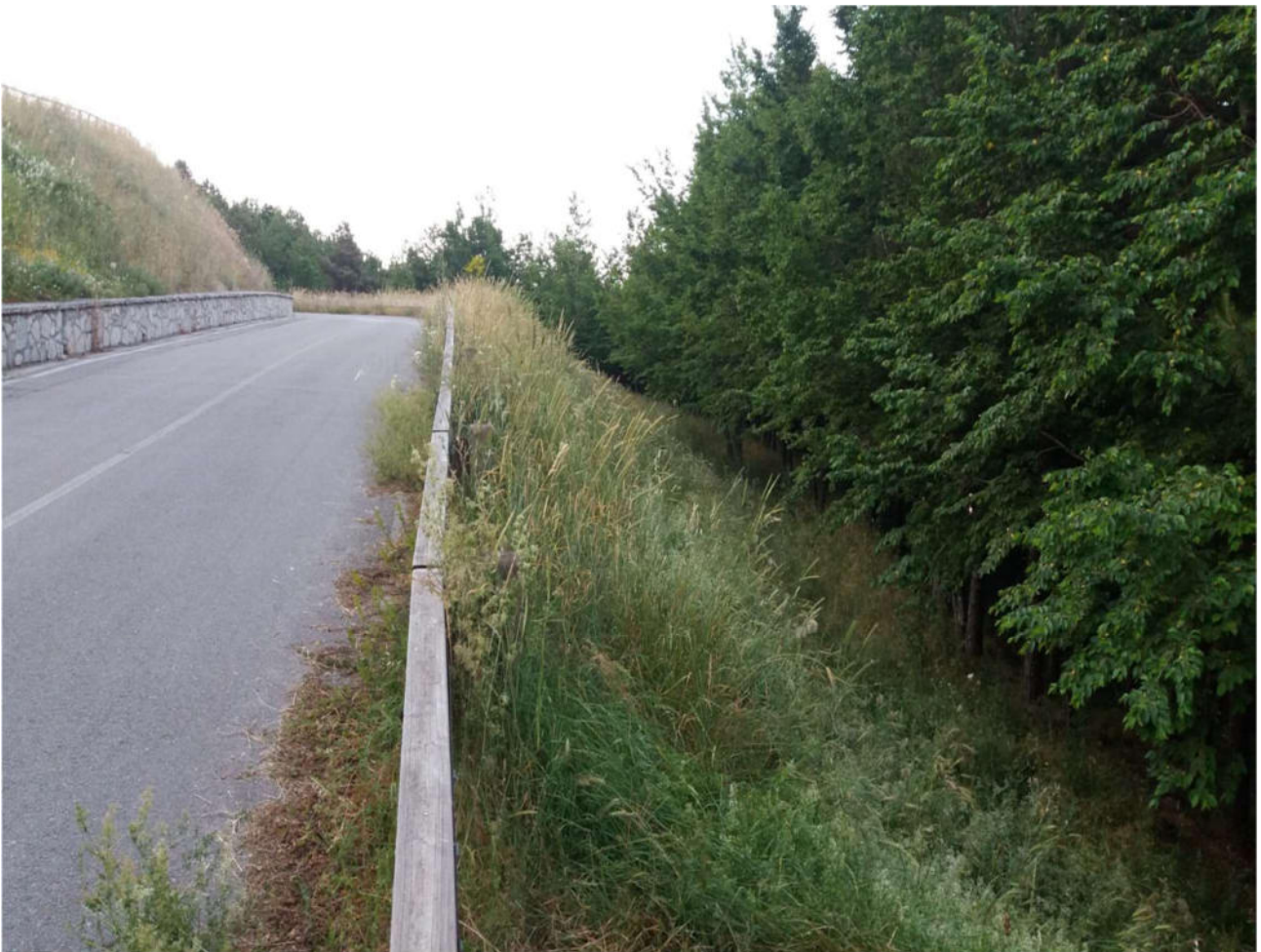
Foto 01-05 – Manutenzione strada comunale -Monte Carmine – Avigliano.
