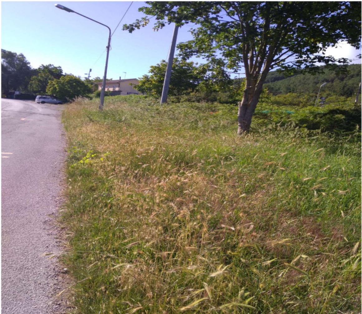
Foto 01-03 – Manutenzione strada comunale – Possidente
