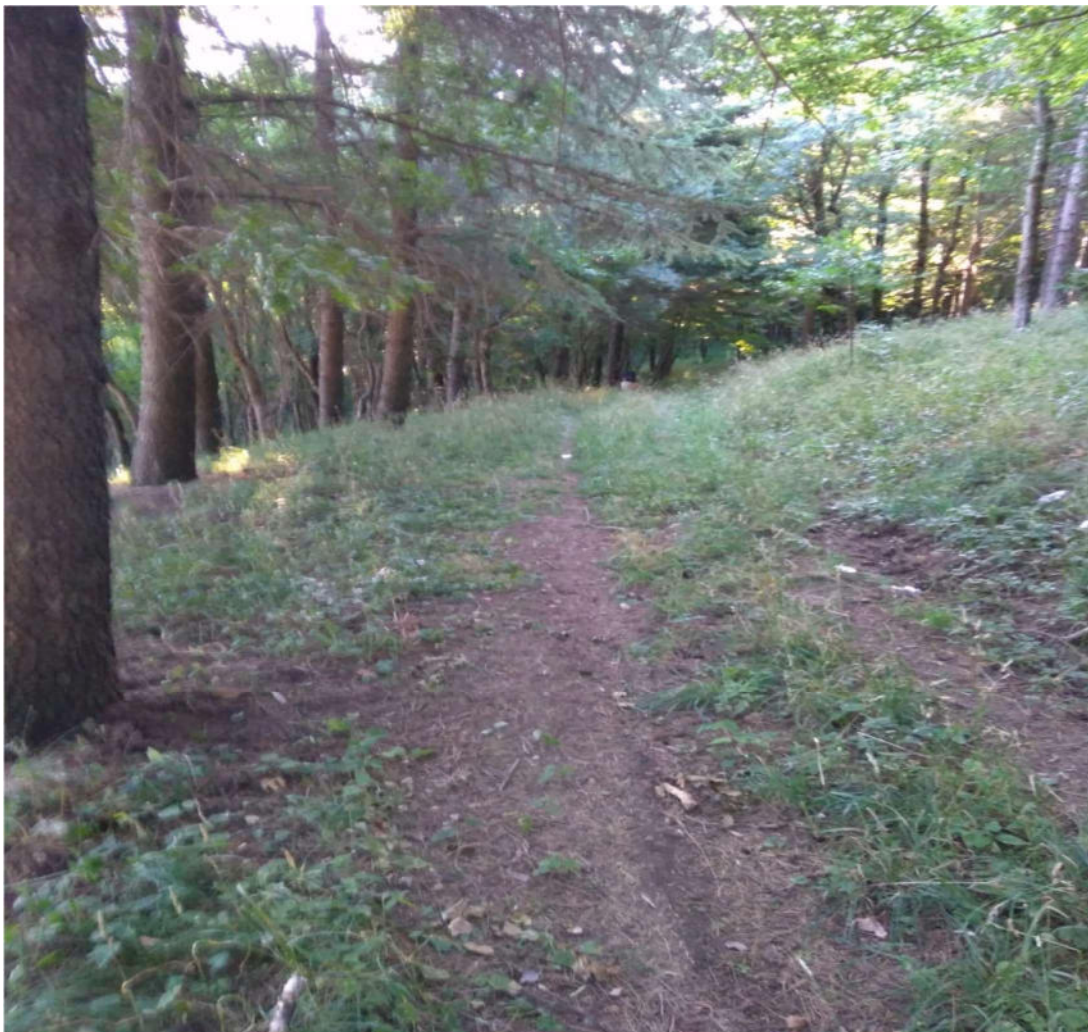
Foto 01-06 – Manutenzione pista tagliafuoco – Monte Carmine - Avigliano.
