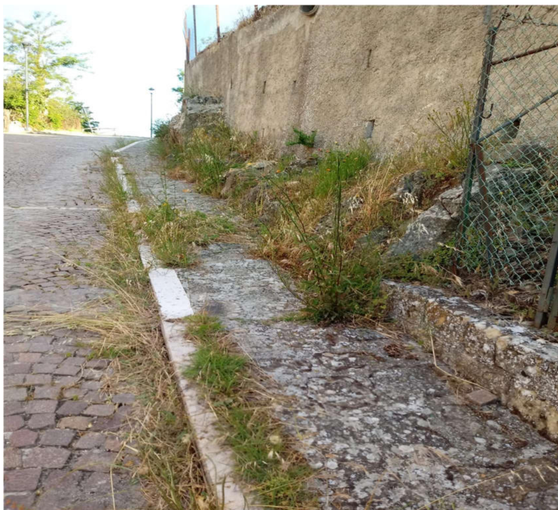
Foto 01-04 – Manutenzione strada accesso castello – Lagopesole.
