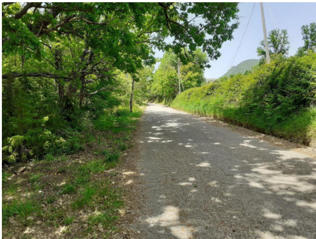
Int. 5.1.4 Loc. Strada San Evraso
