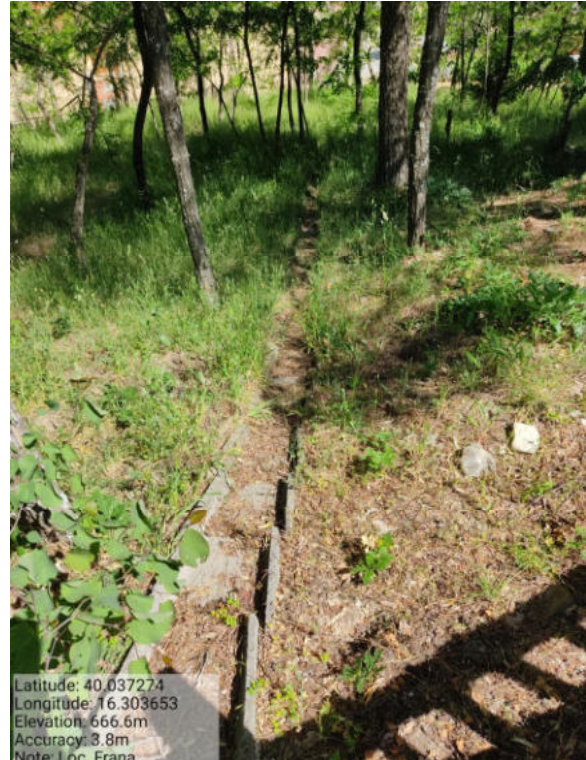
Int. _6.2._Manutenzione Canalette Foto 2
