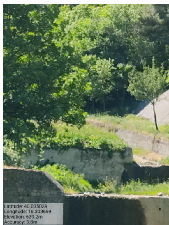
Int. _4.1.2_ Pulizia Fosso Soave Foto 2
