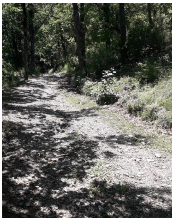
Int. _1.2_ Manutenzione Piste Foto 1
