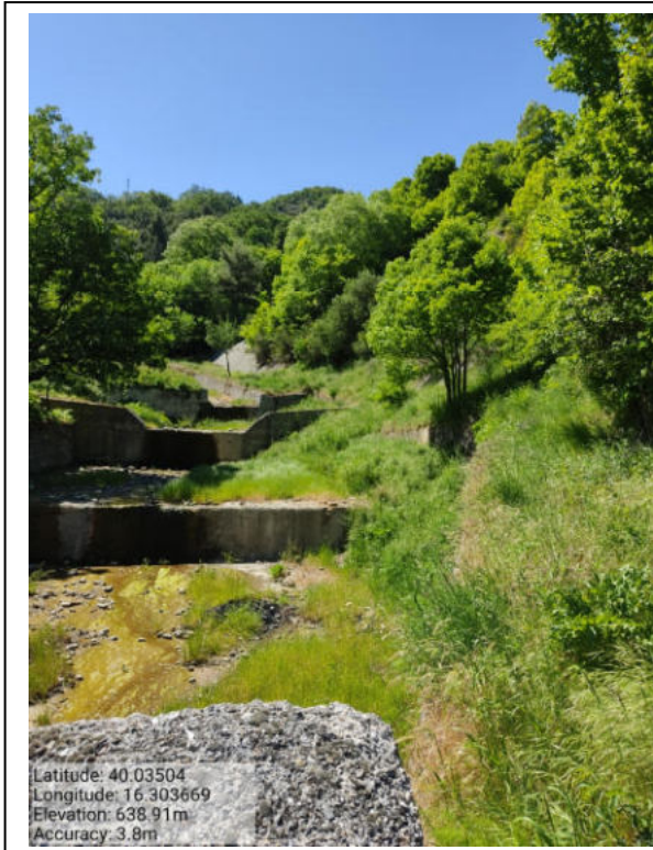
Int. _4.1.2_ Pulizia Fosso Soave Foto 1
