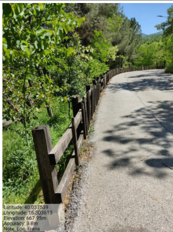
Int. _8.1.1_ Manutenzione Staccionate Foto 2
