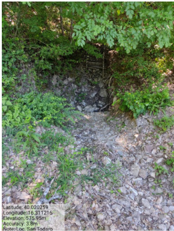
Int. _6.2._Manutenzione Canalette Foto 1
