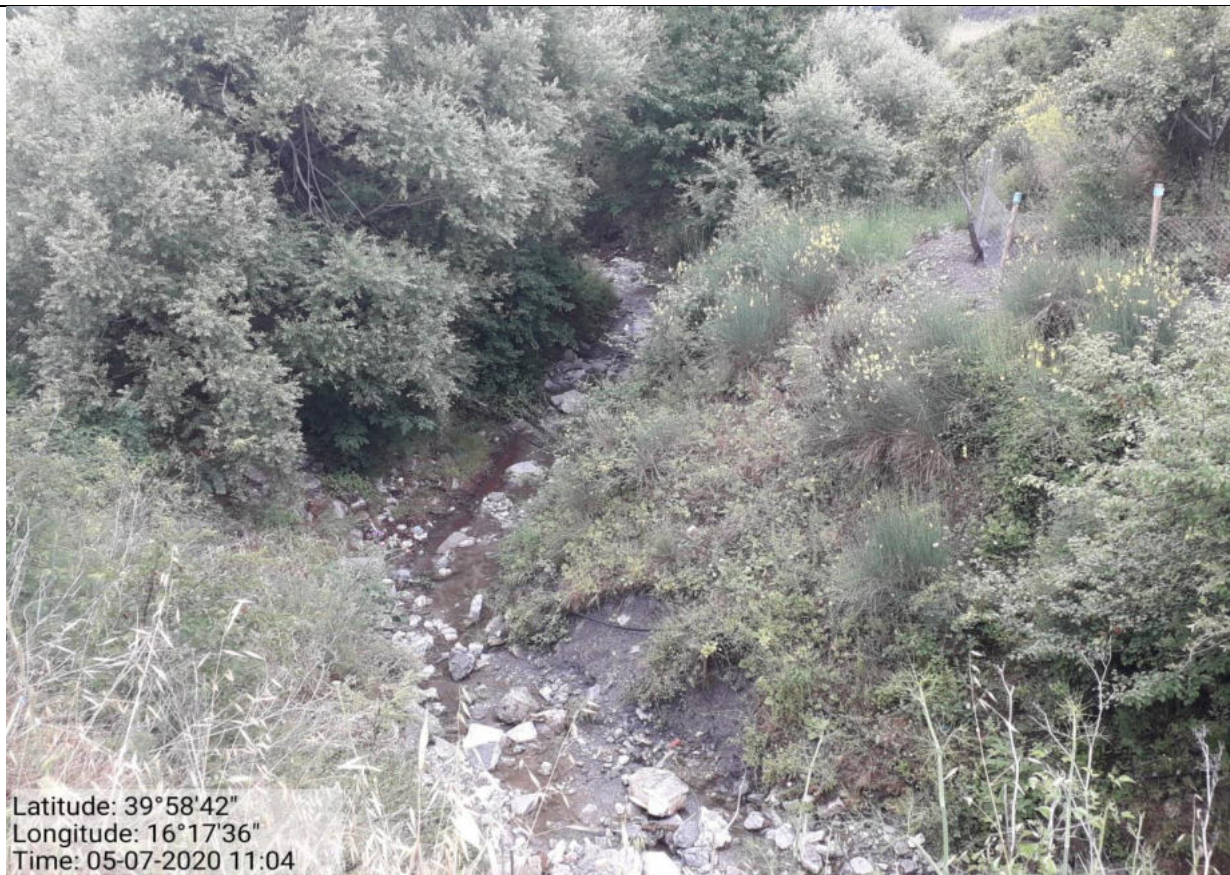
Int. 4.1.1 -Manutenzione aste fluviali. Loc. Pietra Casella.
