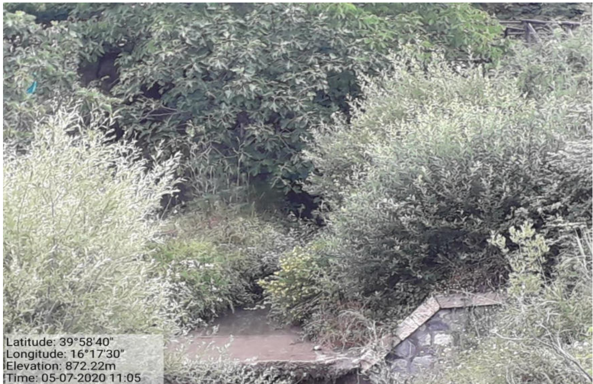
Int. 4.1.1 -Manutenzione aste fluviali. Loc. Pietra Casella.
