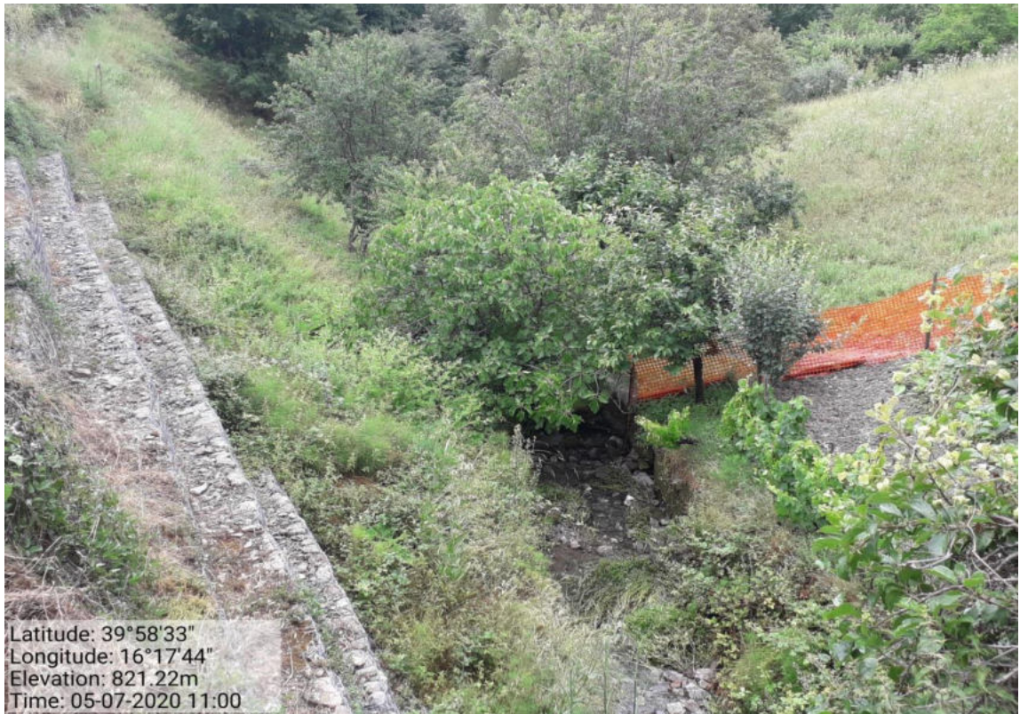
Int. 4.1.2 -Manutenzione aste fluviali. Loc. Piano della Frana.
