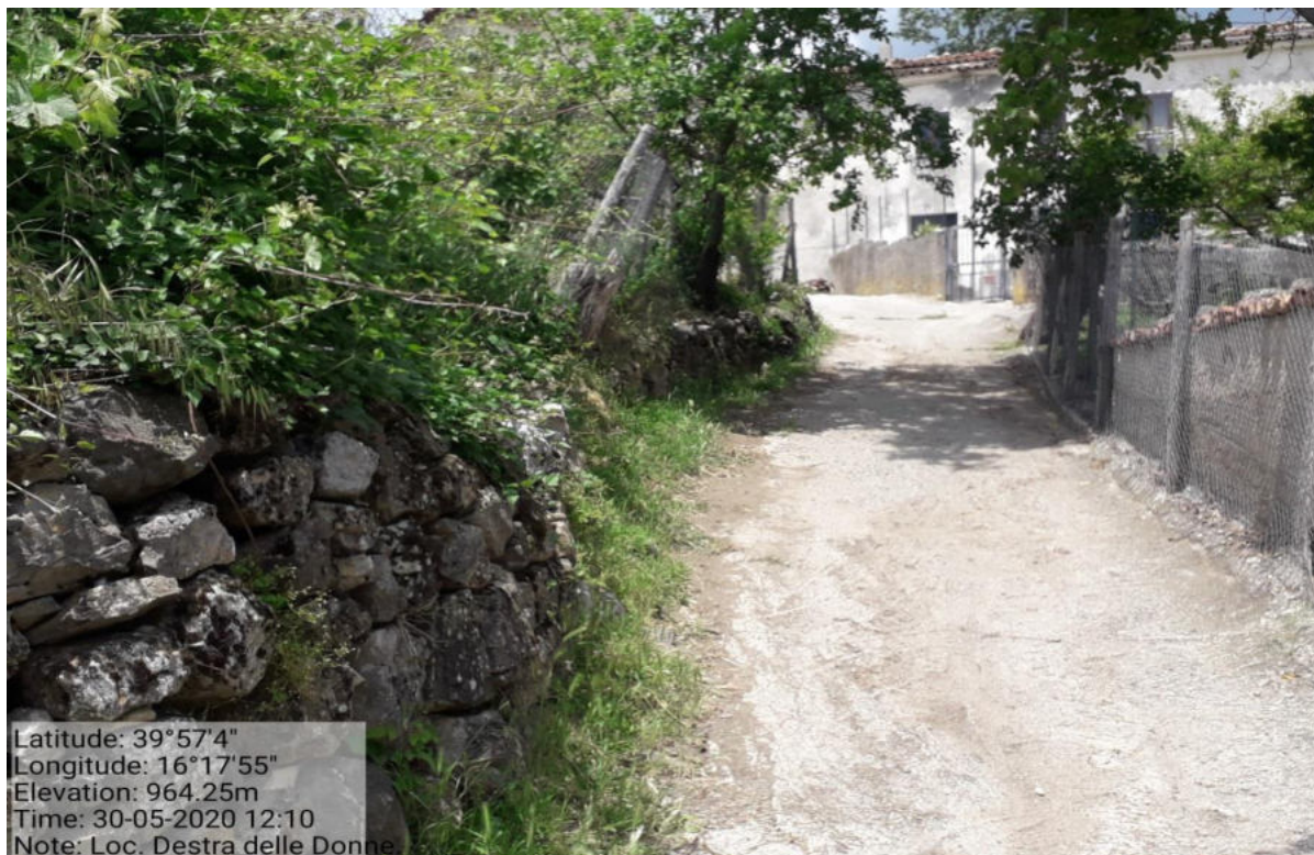
Int. 6.3.2 -Sistemazione Muretti in Pietra Loc. Destra delle Donne.
