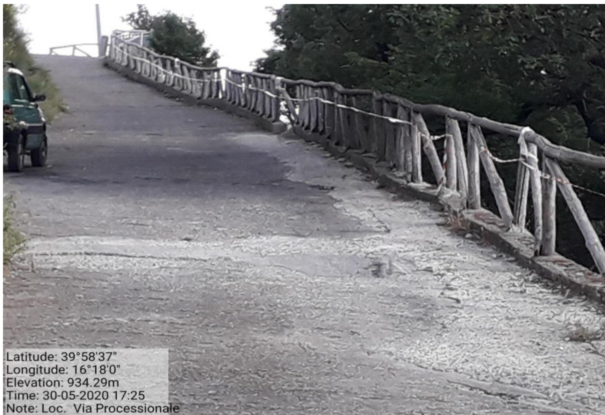
Int. 8.1.5 –Ripristino Staccionate. Loc. Via Processionale.
