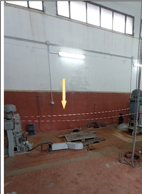
Foto 1) Punto di installazione E.P.
