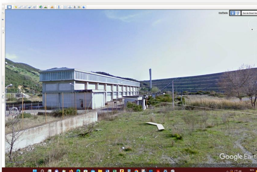
Fig. 7 – impianto di Sollevamento "Monte Cotugno"
