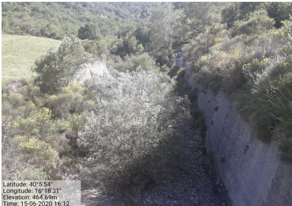
Int. 4.1.1 –Manutenzione Aste Fluviali.
