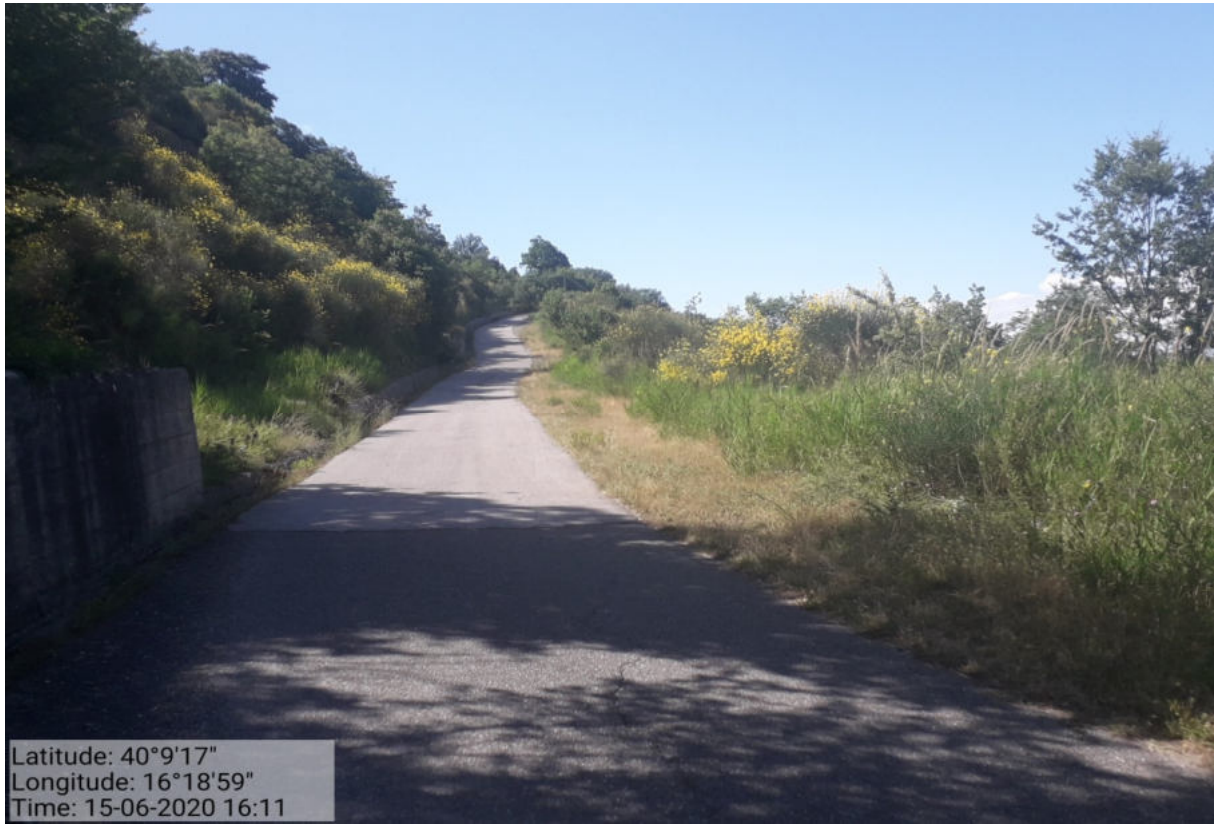
Int. 5.1.1_5.2.1 –Manutenzione Strade Loc. Scazzariello.
