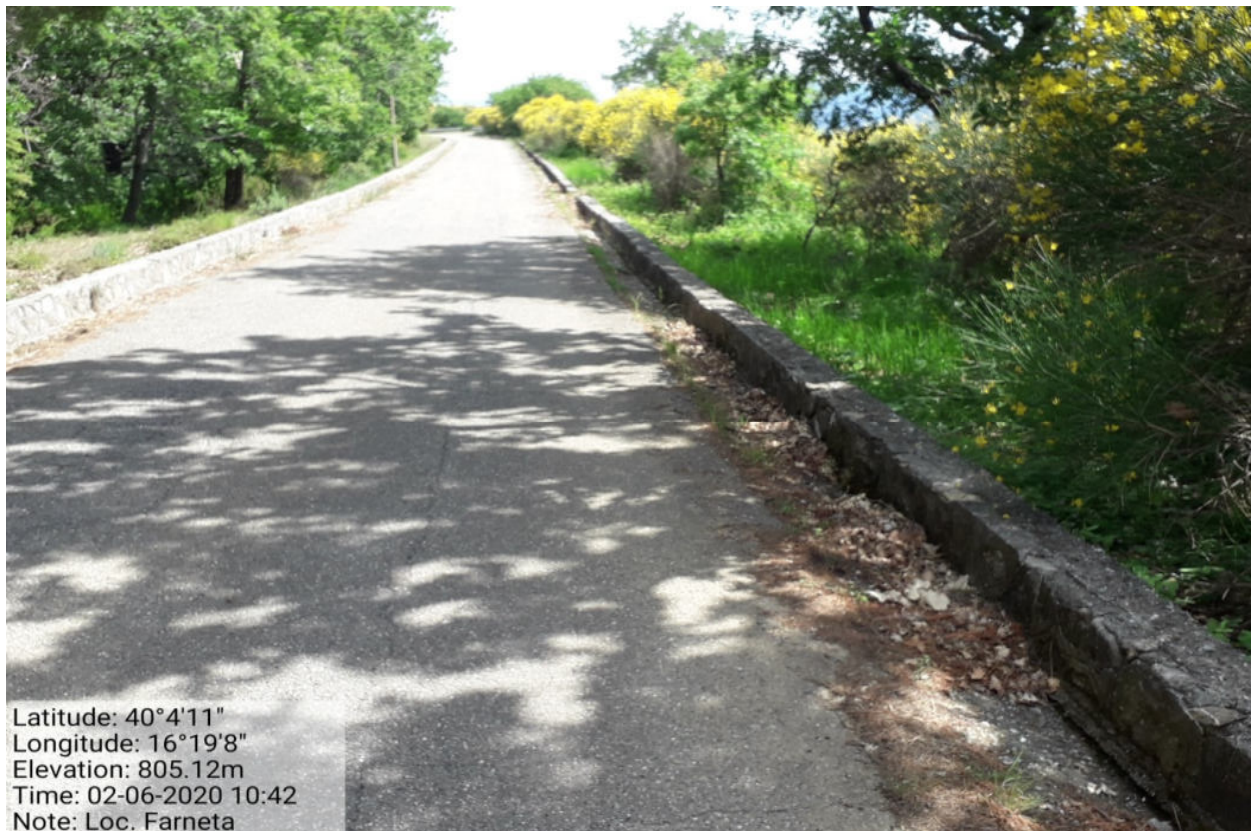
Int. 5.1.1_5.2.1 –Manutenzione Strade Loc. Farneta.
