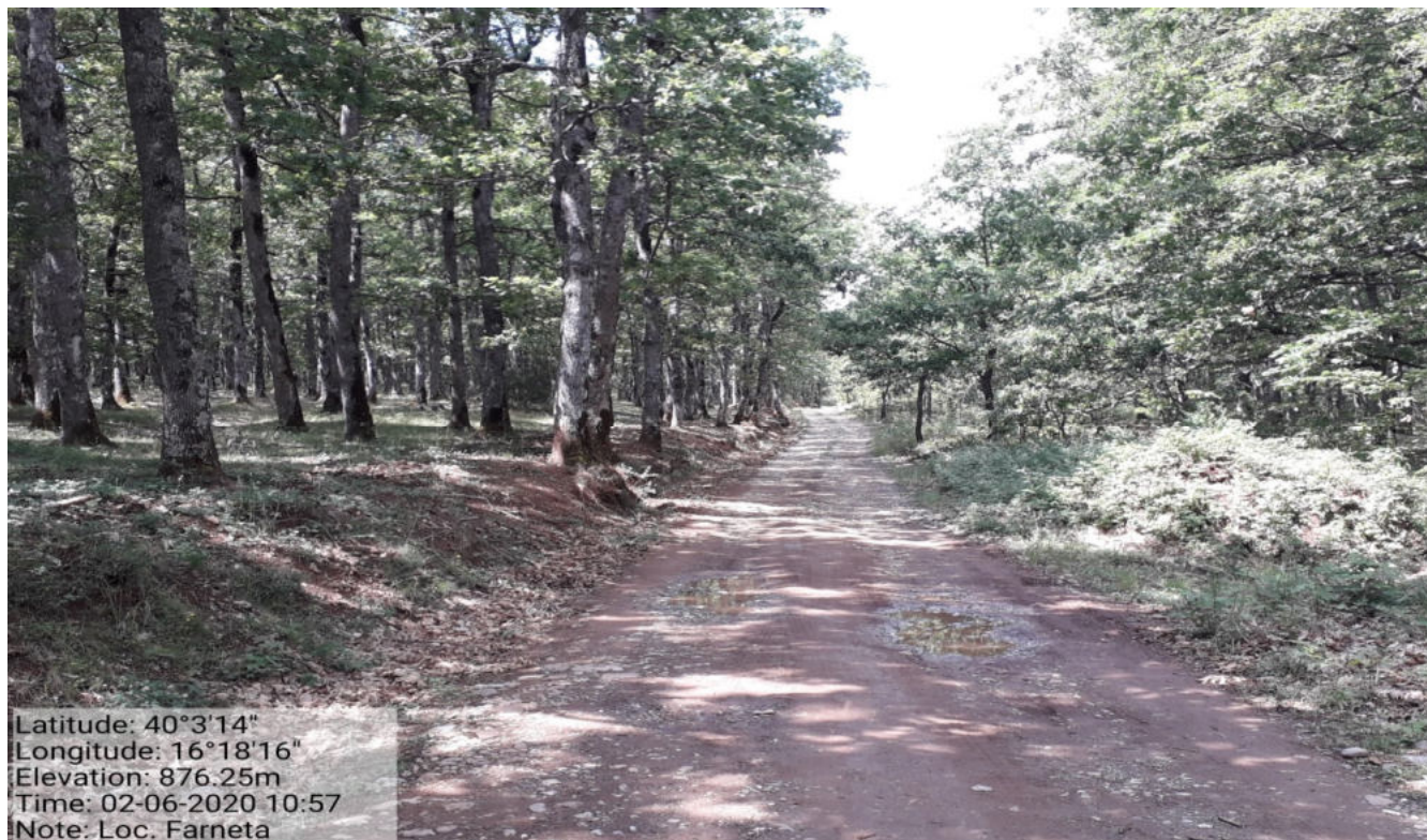
Int. _1.2.1_ Manutenzione Piste. Loc. Farneta.
