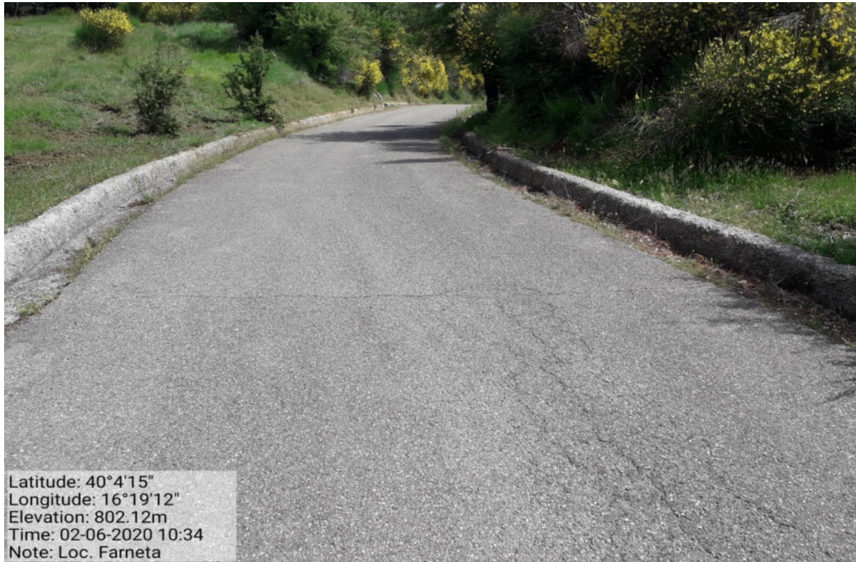
Int. 5.1.1_5.2.1 –Manutenzione Strade Loc. Farneta.
